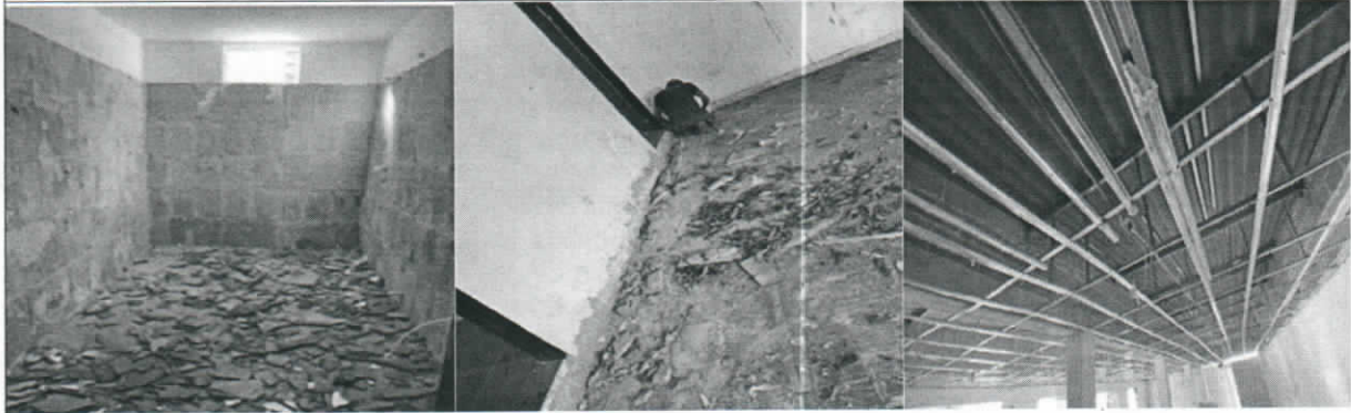
Desmontes de enchape en baños, retiro de cielo rasos, lámparas largas y cuadradas.
