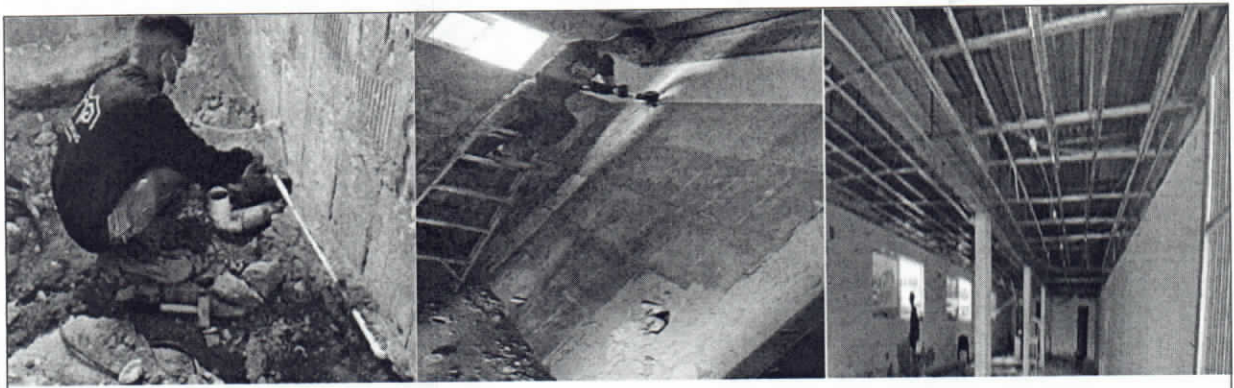
Desmonte de puntos y red hidrosanitaria, desmonte de pañete, desmonte de cableado eléctrico incluida tubería y accesorios.
