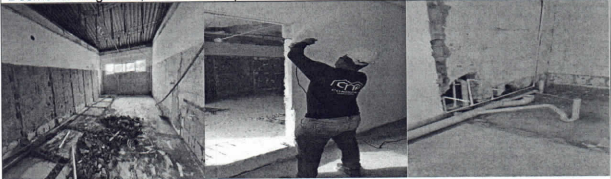
Desmante de grifería, desmante de puntos hidrosanitarios, desmante de muebles empotrados.
