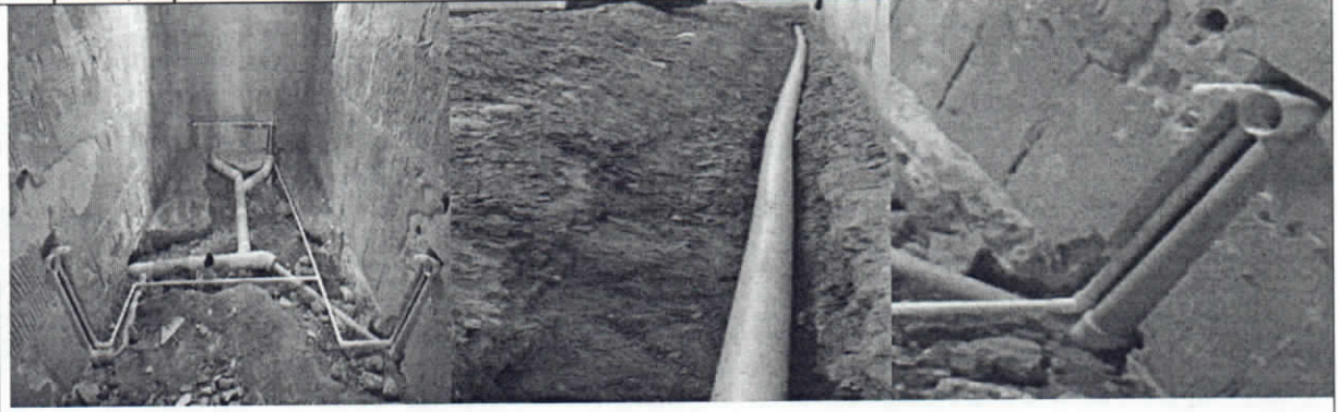
Ajuste y suministro de la red hidráulica y sus elementos faltantes, reposición e instalación de tuberías sanitarias PVC "4", reposición e instalación de puntos de agua fría.
