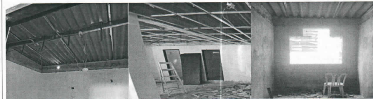
Retiro de red eléctricas, desmonte de puertas, retiro de ventanas y marcos.
