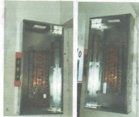
Mantenimiento y/o reposición e instalación de tablero TRIF.C/PUERTA ESP. TOTAL.24 CTOS
