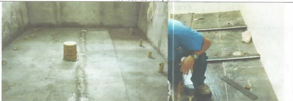
Mantenimiento y reposición e instalación de alistado de piso 4cm impermeabilizado y Mantenimiento y/o reposición e instalación poyo ducha en los casos que se requiera
