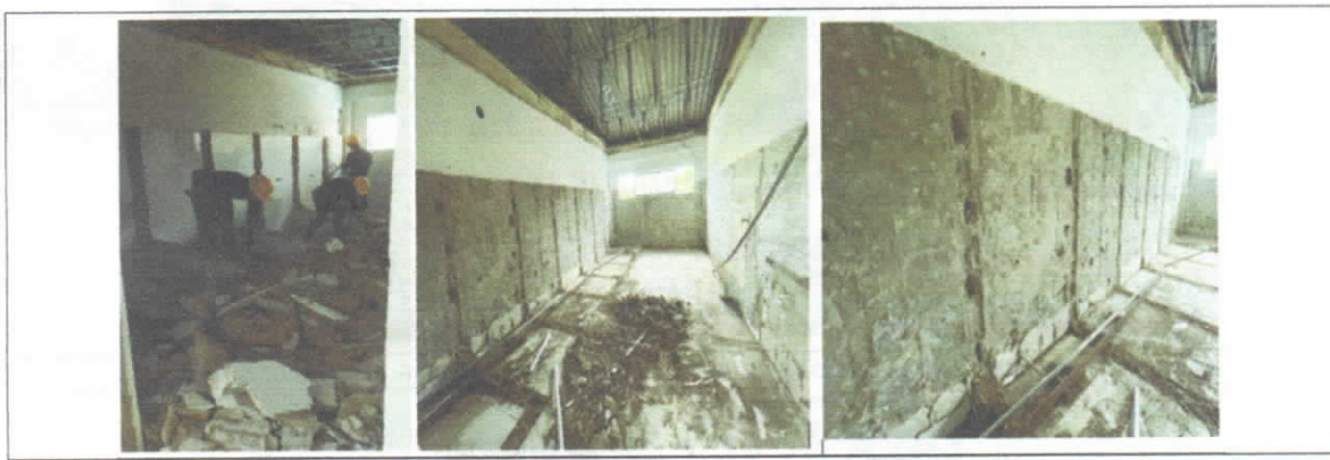
Desmante Alistado de Piso, Desmante de Enchape de Pared y/o Piso y Desmante de pañete
