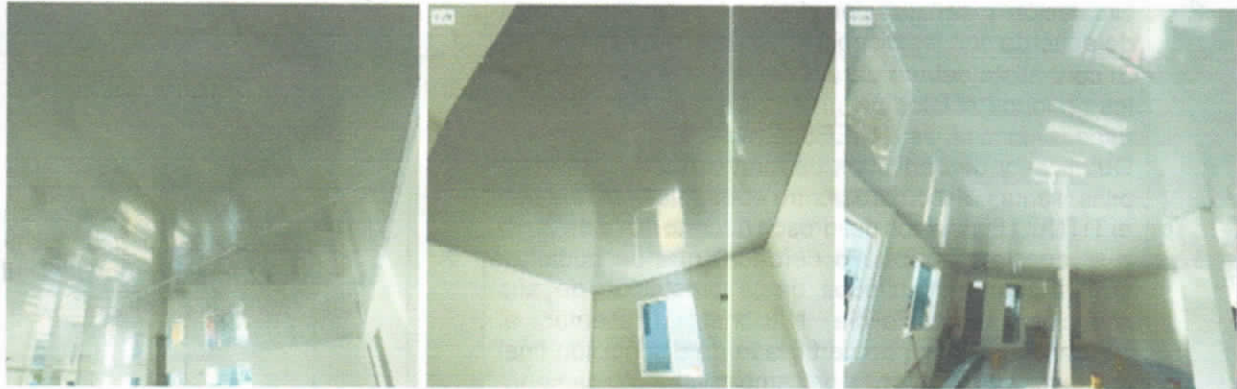
Suministro e instalación de cielo raso con tablilla en PVC. Incluye estructura metálica.
