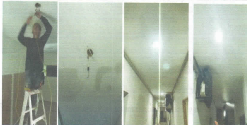
Reposición e instalación de Panel Led redondo 18w
