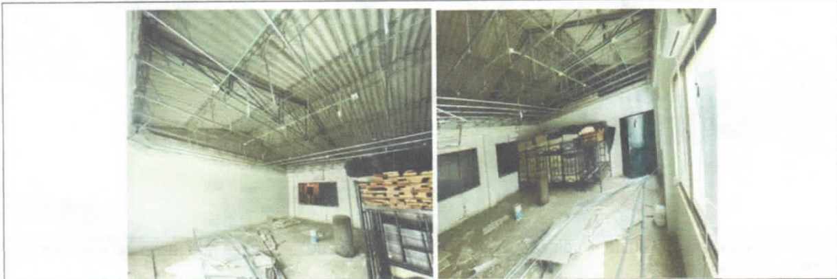
Desmante de cielo raso en cualquier material conservando la estructura portante
