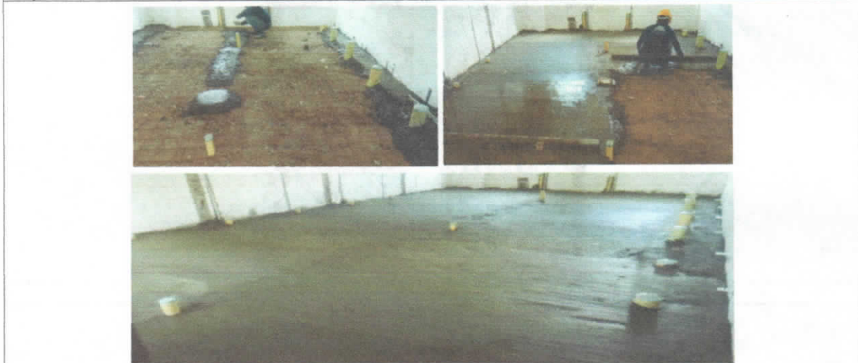
Suministro e instalación de losa con lamina colaborante y concreto de 3.500 PSI. incluye refuerzo
