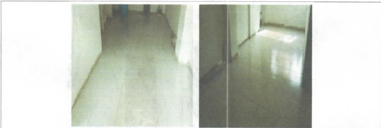
Mantenimiento y reposición e instalación de piso cerámico tráfico moderado
