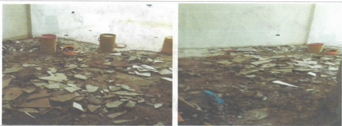
Desmante de Enchape de Pared y/o Piso
