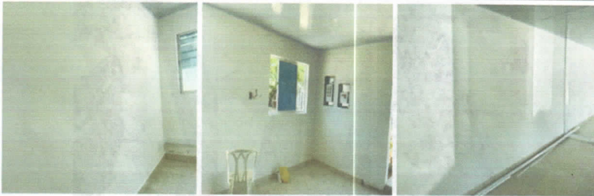
Mantenimiento y reposición e instalación de estuco
