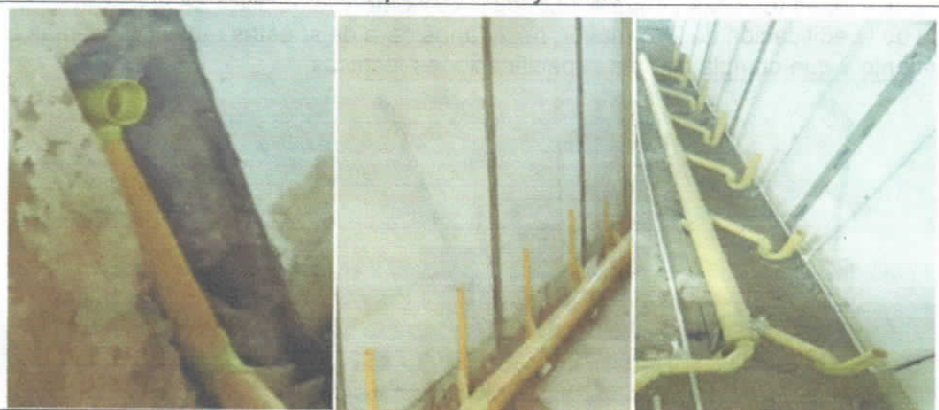
Corte en muro o piso con máquina, en material rígido con y sin acabado de enchape.
