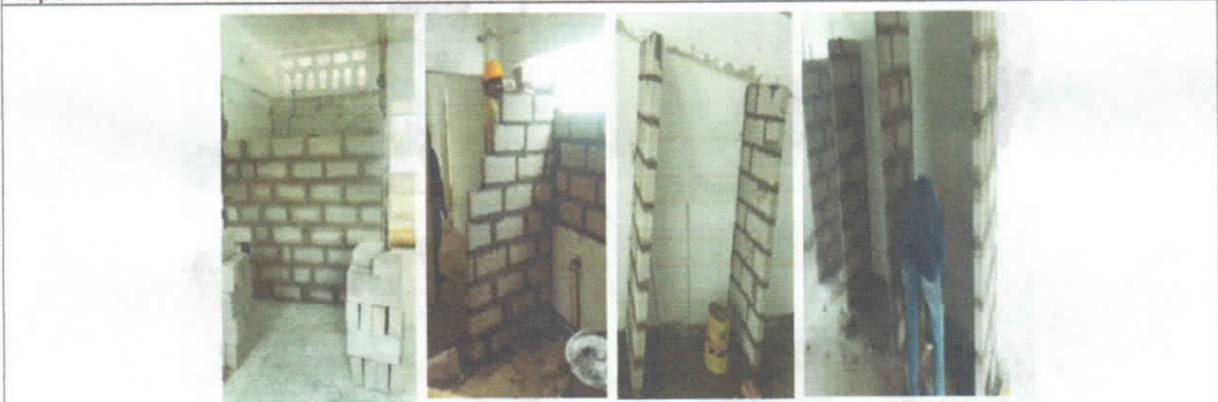
Mantenimiento y/o reposición e instalación de muro divisorio bloque estriado N°5 en los casos que se requiera
