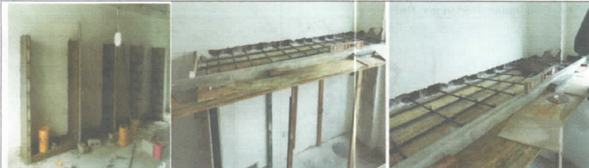
Mantenimiento y/o reposición e instalación de muro divisorio bloque estriado N°5 en los casos que se requiera y Reposición e instalación de mesón en concreto
