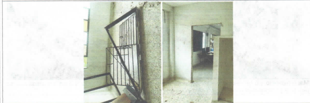
Desmante de Rejas Metálicas
