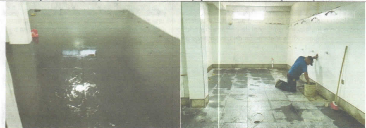
Mantenimiento y reposición e instalación de piso cerámico tráfico moderado y mantenimiento y reposición e instalación de enchape pared cerámico, color por definir
