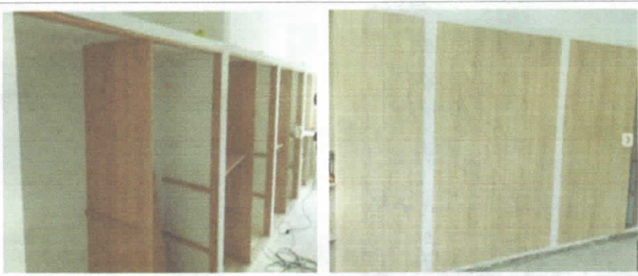
Reposición e instalación de Clóset formorado
