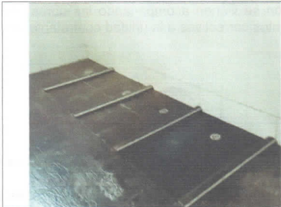
Mantenimiento y reposición e instalación de rejilla anticucaracha 3"x2"
