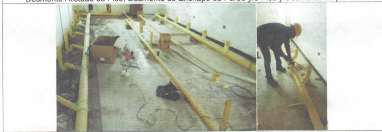
Desmante de puntos hidrosanitarios. Incluye retiro de red hidrosanitaria en una longitud hasta 1,5
