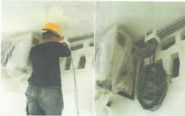
Mantenimiento y/o reposición e instalación de Caja de paso 15 x 15 x 10 cm con chapa
