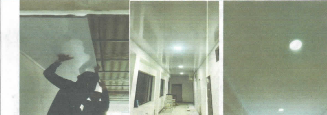
Suministro e instalación de cielo raso con tablilla en PVC. Incluye estructura metálica y Reposición e instalación de Panel Led redondo 18w
