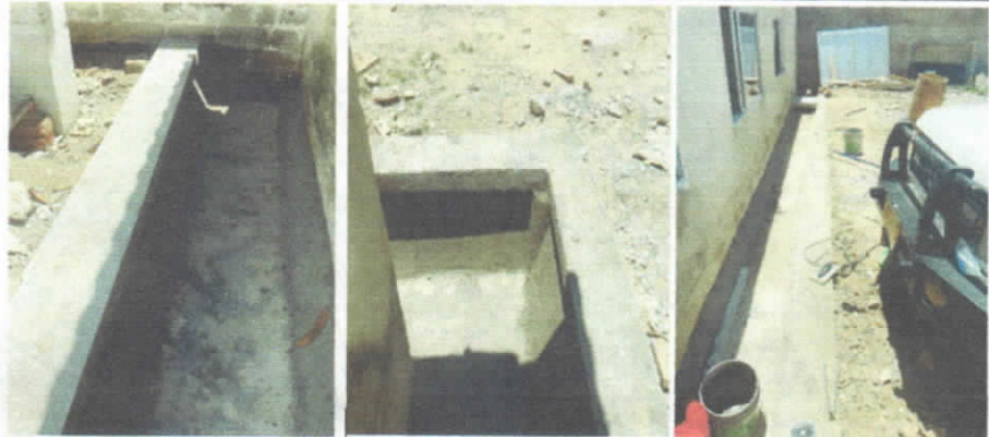
Mantenimiento y/o reposición e instalación de alfajía concreto 0.25 M y Mantenimiento, reposición e instalación de guardaescoba para piso técnico extruido monomasa e:0.10 m
