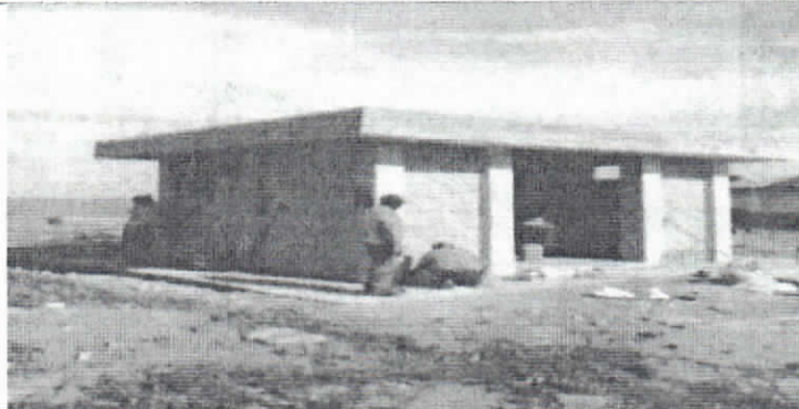
Reposición e instalación de pañete impermeabilizado muros 1:3
