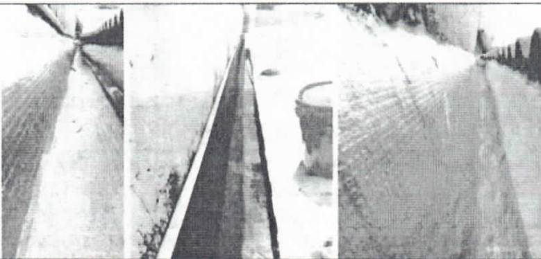
Mantenimiento, reposición e instalación de manto autoprotegido con foil aluminio y alma central en poliéster de alta capacidad de calibre igual o superior 3mm
