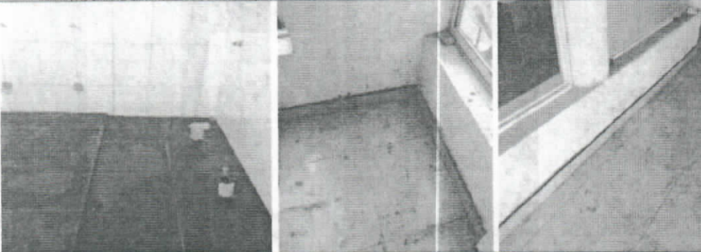
Mantenimiento y reposición e instalación de piso cerámico tráfico moderado y Mantenimiento y reposición e instalación de guardaescoba en cerámica.
