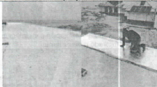
Mantenimiento, reposición e instalación de manto bituminoso impermeabilizante de superficies con acabado en piso duro de calibre igual o superior 4 mm
