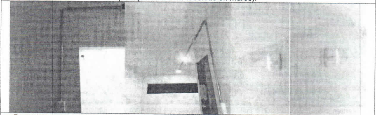
Reposición, suministro e instalación de la red eléctrica en tubería EMT (incluye tubería, cableado y anclaje), y/o elementos necesarios para dejar estas redes en óptimas condiciones de funcionamiento (para redes expuestas) y Reposición e instalación interruptor sencillo.
