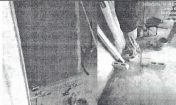
Reposición e instalación de pañete impermeabilizado muros 1:4 y Suministro e instalación de anclaje epoxico hasta 1/2" y longitud 15 cm o superior.
