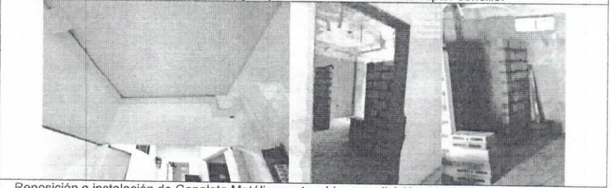
Reposición e instalación de Canaleta Metálica portacables con división para la instalación de salidas de voz, datos y energía regulada y Mantenimiento y/o reposición e instalación de muro divisorio bloque estriado N°5 en los casos que se requiera
