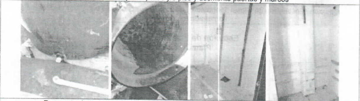
Desmante de tanques elevados de agua y desmante de muebles empotrados
