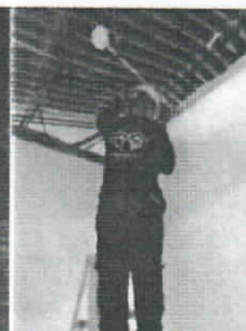
Reposición, suministro e instalación de la red eléctrica en tubería PVC (incluye tubería, cableado y regateo), y/o elementos necesarios para dejar estas redes en óptimas condiciones
