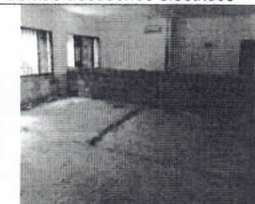
Mantenimiento y/o reposición e instalación de muro divisorio bloque estriado N°4 en los casos que se requiera
