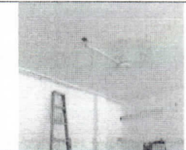
Desmante de lámparas Iluminación largas, Cuadradas, Redondas, Reflectores
