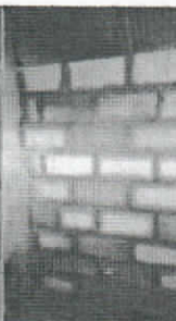
Mantenimiento y/o reposición e instalación de muro divisorio bloque estriado N°5 en los casos que se requiera.
