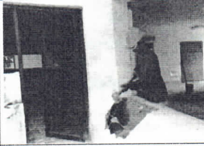
Desmante de Muros en ladrillo o bloque
