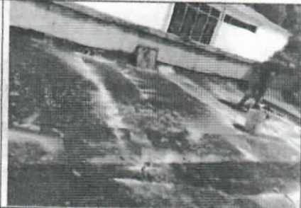
Retiro de manto asfaltico de impermeabilización de cubiertas.
