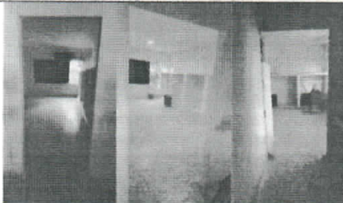
Desmonte Puertas y Marcos
