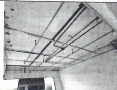
Mantenimiento y/o reposición e instalación de salida en tubería PVC
