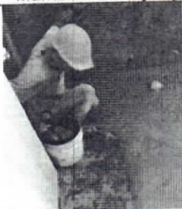
Mantenimiento y reposición e instalación de alizado de piso 4cm impermeabilizado
