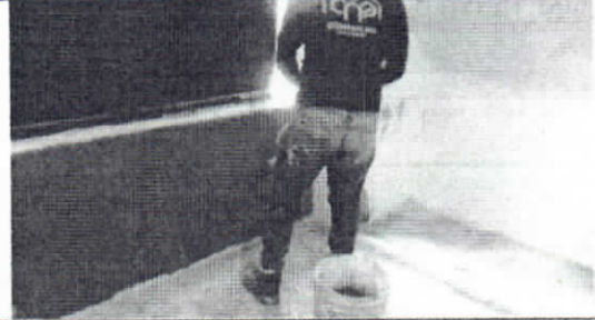
Mantenimiento y/o reposición e instalación anti humedad fachada dos capas
