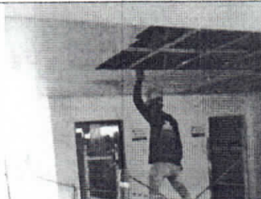
Desmante de cielo raso en cualquier material y estructura portante
