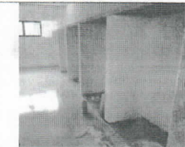
Mantenimiento y/o reposición e instalación de muro divisorio bloque estriado N°5 en los casos que se requiera.
