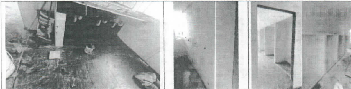
Mantenimiento y reposición e instalación de piso cerámico tráfico moderado y Mantenimiento y reposición e instalación enchape pared cerámico, color por definir
