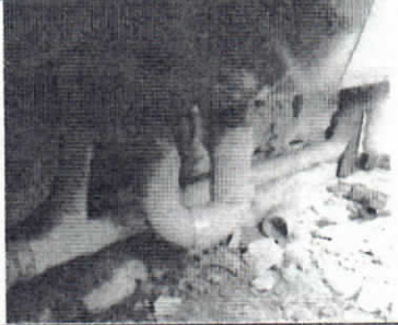
Reposición e instalación de salida sanitaria 2"
