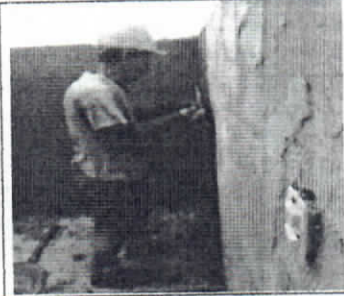
Reposición e instalación de pañete impermeabilizado muros 1:4
