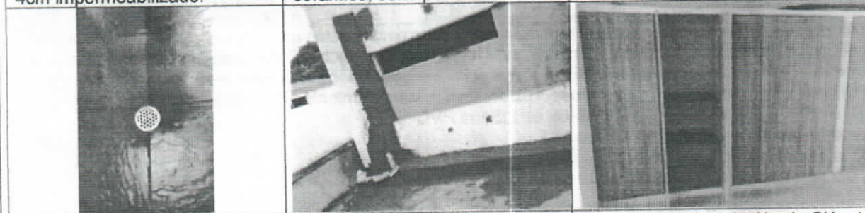
Mantenimiento y reposición e instalación de REJILLA ANTICUCARACHA 3"x2" Mantenimiento y resanes generales Reposición e instalación de Clóset flormorado
