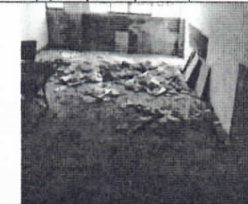
Desmante de enchape y Guarda Escoba
