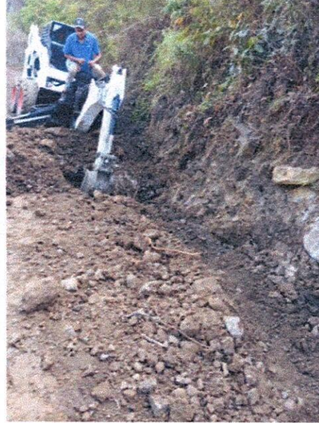
Replanteo y excavaciones varias en material común.
