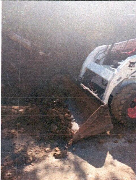
Excavaciones varias en material común.
