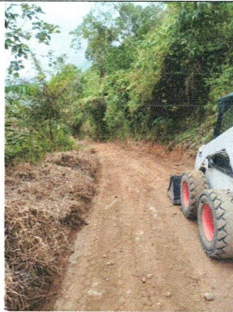
Replanteo y excavaciones varias en material común.
