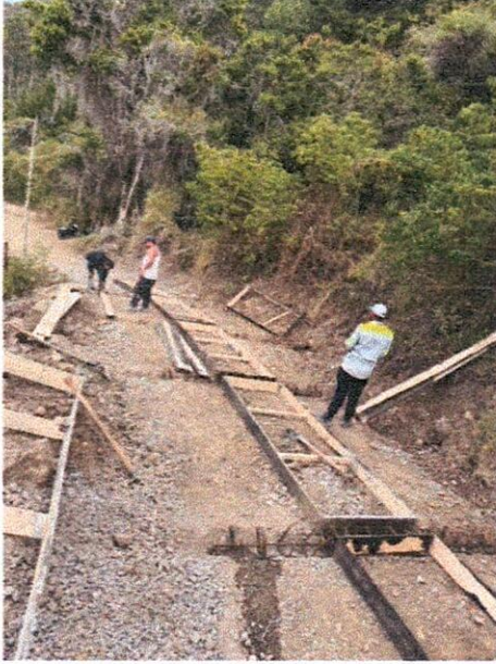
Preparación para fundir huellas y vigas.
