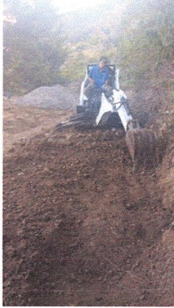
Replanteo y excavaciones varias en material común.
