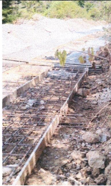
Acero de refuerzo de 4200 mpa para placas, vigas, cunetas y bordillos.
