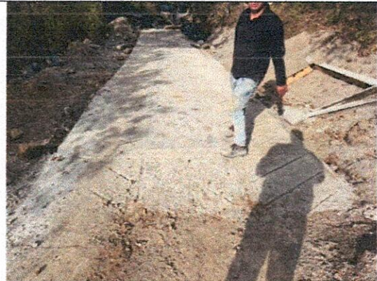
Suministro e instalación de concreto de 3.000 psi para estructuras de placa huella
