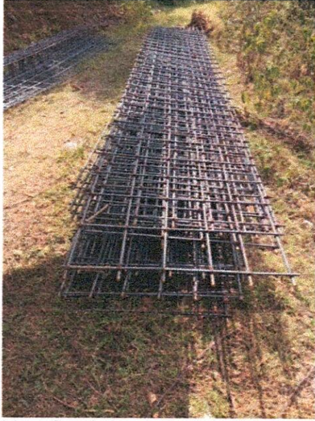
Suministro y figurado de acero de refuerzo de 4200 mpa para placas, vigas, cunetas y bordillos.
