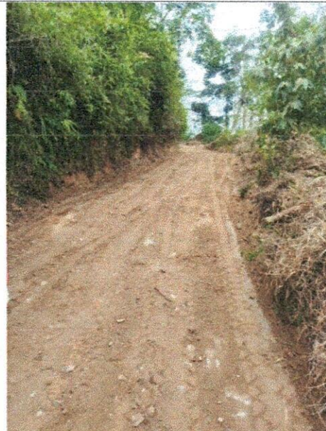
Replanteo y excavaciones varias en material común.
