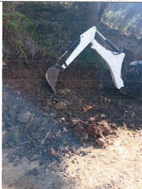
Excavaciones varias en material común.
