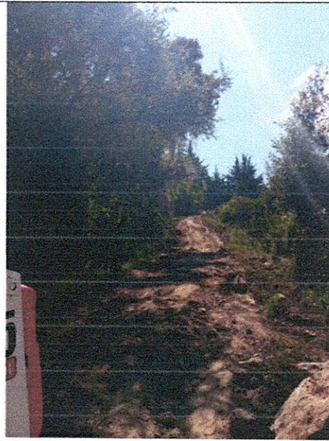
Replanteo y excavaciones varias en material común.
