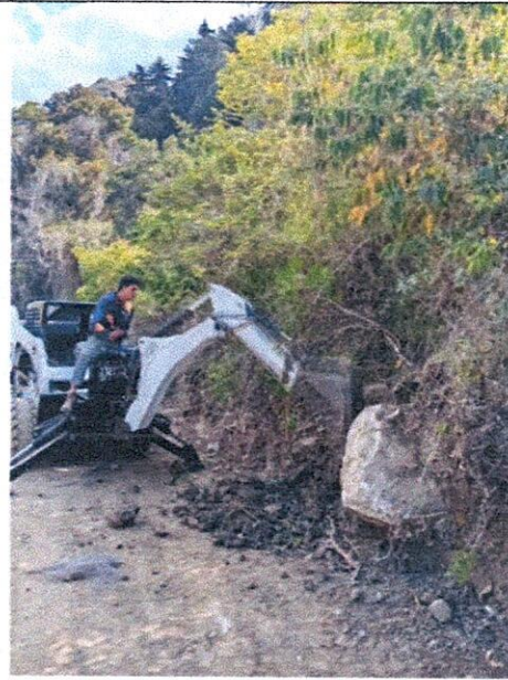
Excavaciones varias en material común.
