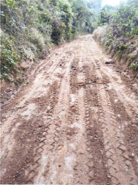
Replanteo y excavaciones varias en material común.
