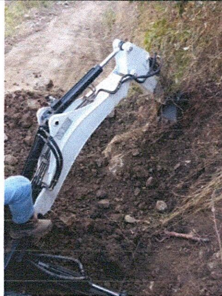
Excavaciones varias en material común.
