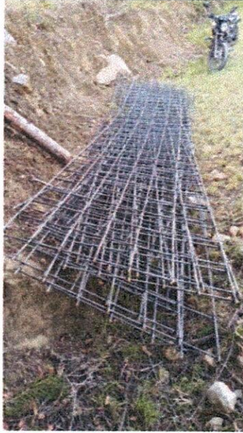
Acero de refuerzo de 4200 mpa para placas, vigas, cunetas y bordillos.
