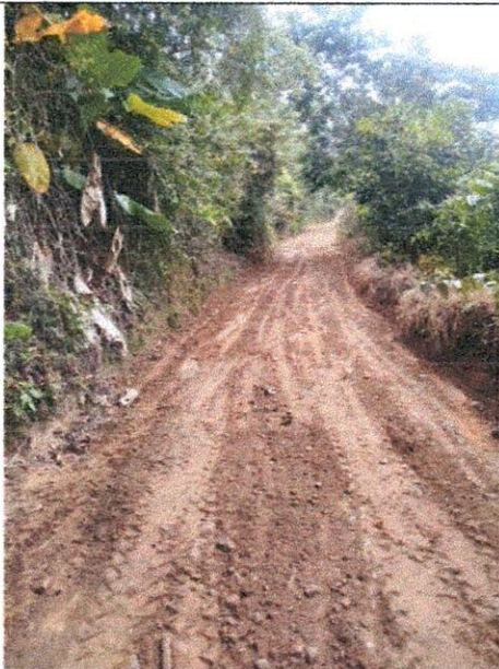
Replanteo y excavaciones varias en material común.
