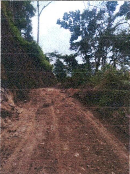
Replanteo y excavaciones varias en material común.
