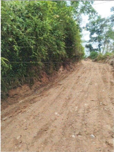
Replanteo y excavaciones varias en material común.
