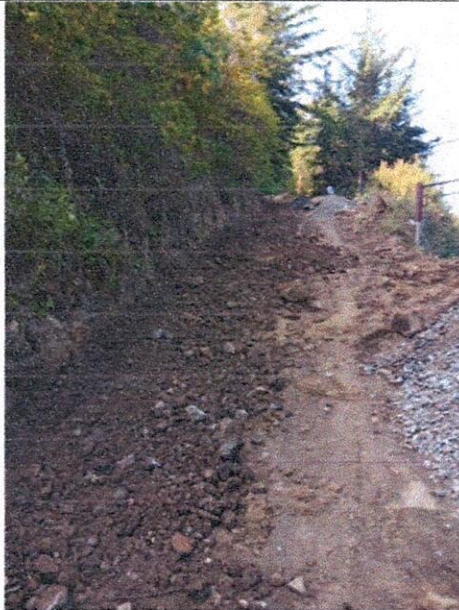
Replanteo y excavaciones varias en material común.
