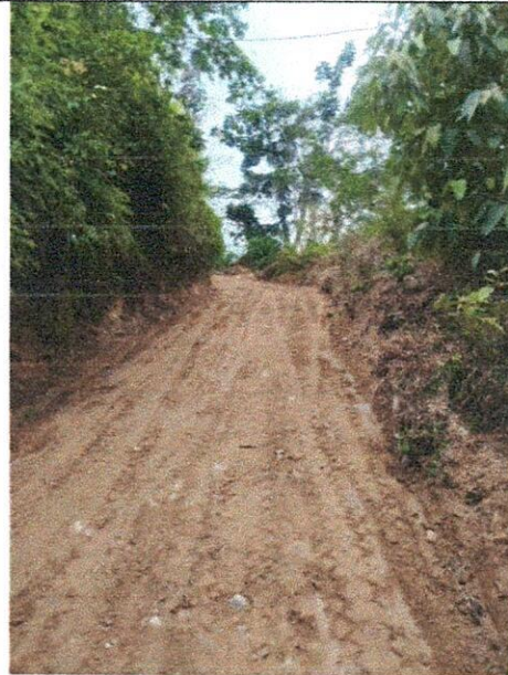
Replanteo y excavaciones varias en material común.
