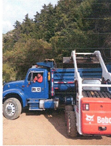
Retiro de material sobrante producto de las excavaciones. Incluye transporte
