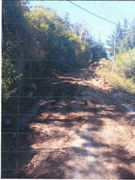
Replanteo y excavaciones varias en material común.
