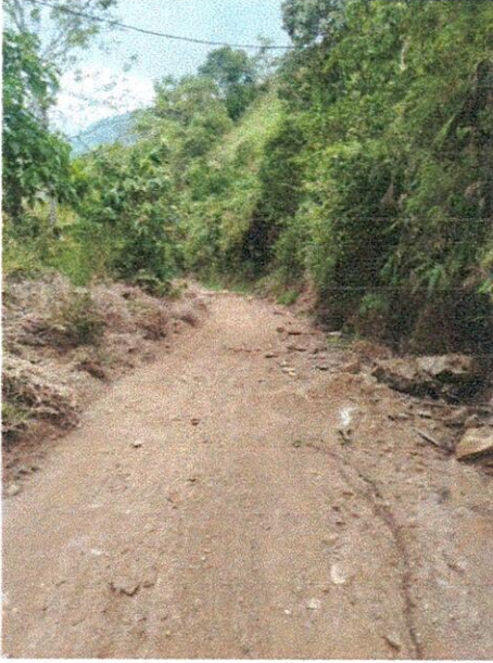
Replanteo y excavaciones varias en material común.
