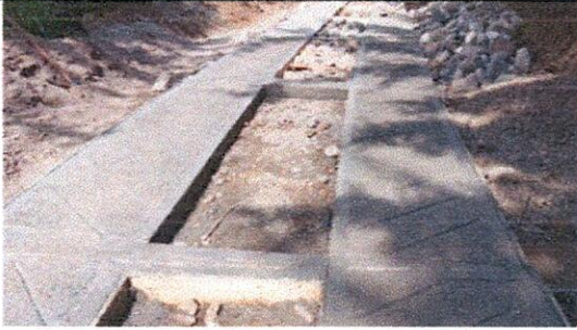
Suministro e instalación de concreto de 3.000 psi para estructuras de placa huella
