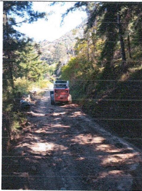
Excavaciones varias en material común.
