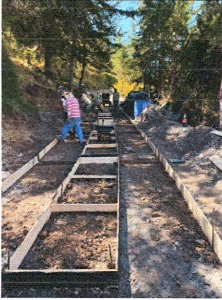
Preparación para fundir huellas y vigas.
