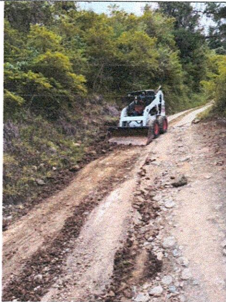
Excavaciones varias en material común.
