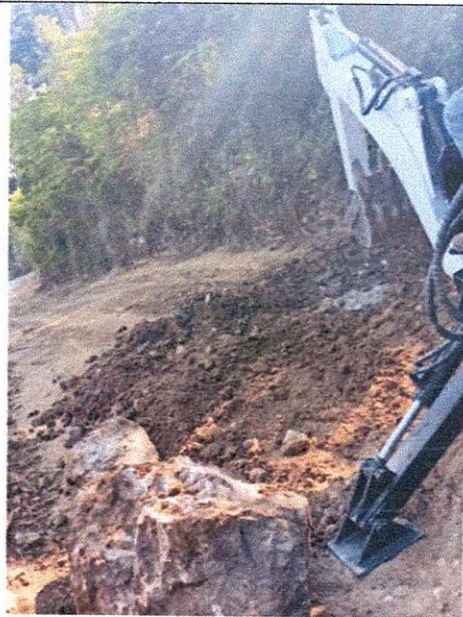
Excavaciones varias en material común.
