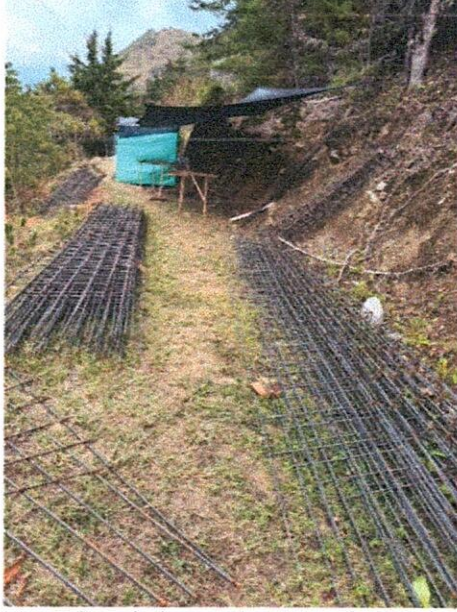
Suministro y figurado de acero de refuerzo de 4200 mpa para placas, vigas, cunetas y bordillos.
