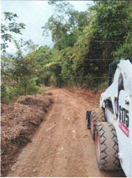
Replanteo y excavaciones varias en material común.
