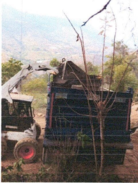
Retiro de material sobrante producto de las excavaciones. Incluye transporte
