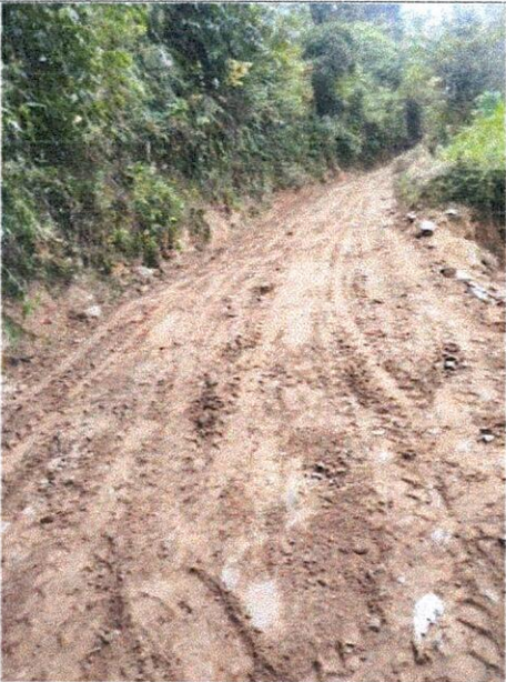
Replanteo y excavaciones varias en material común.
