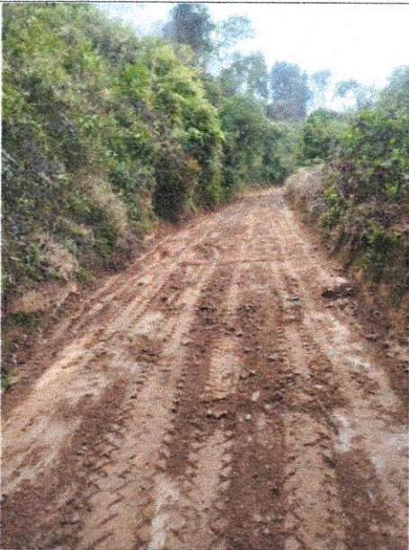
Replanteo y excavaciones varias en material común.
