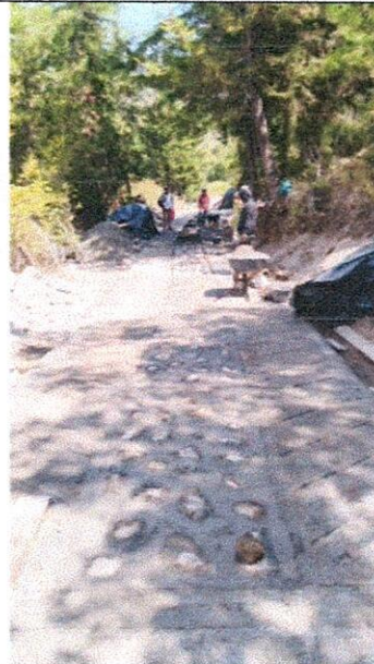
Suministro e instalación de concreto de 3.000 psi para estructuras de placa huella
