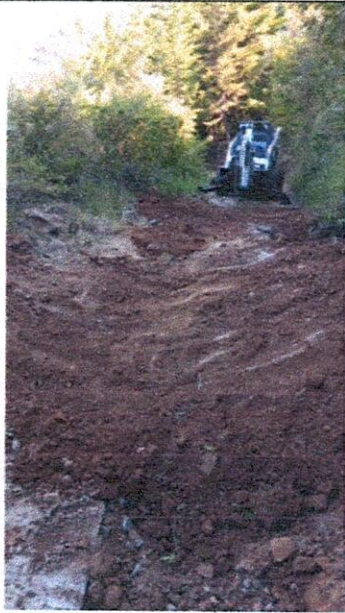
Excavaciones varias en material común.
