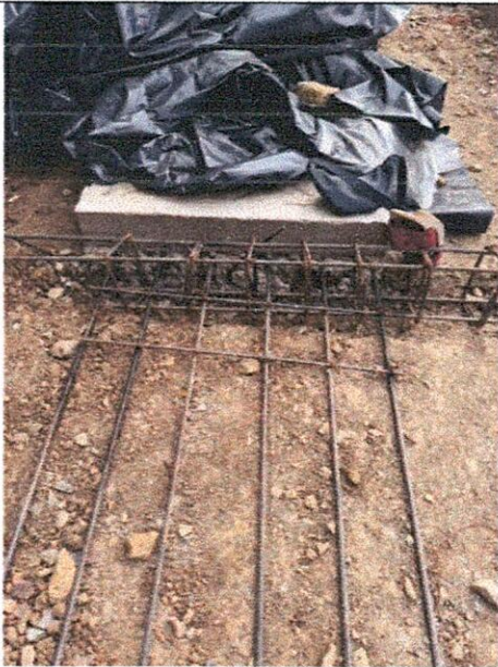
Acero de refuerzo de 4200 mpa para placas, vigas, cunetas y bordillos.
