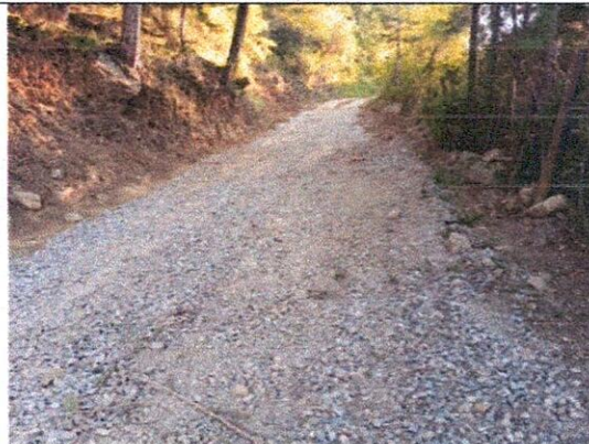
Material tipo sub-base clase a de espesor 0,15. Incluye transporte.
