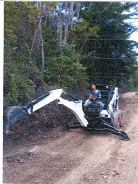
Excavaciones varias en material común.
