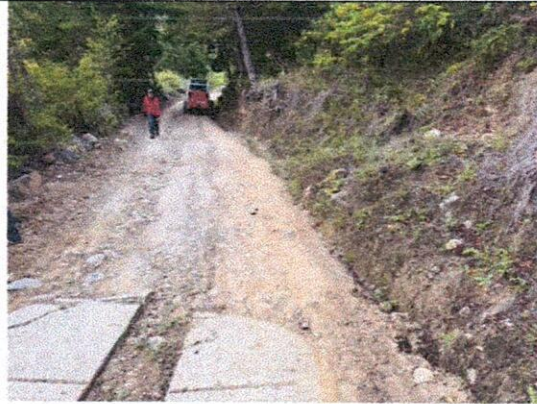
Excavaciones varias en material común.
