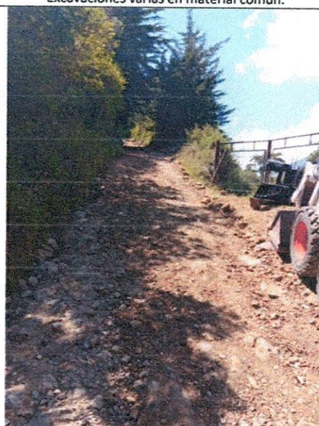
Replanteo y excavaciones varias en material común.
