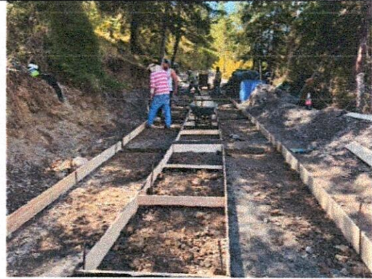
Preparación para fundir huellas y vigas.
