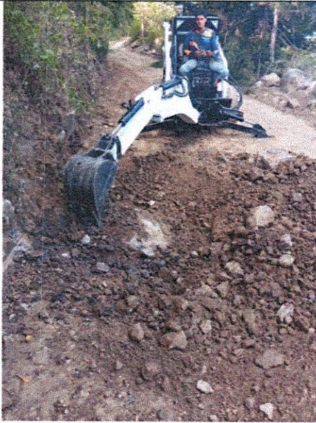
Excavaciones varias en material común.
