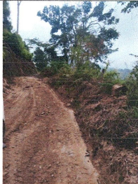
Replanteo y excavaciones varias en material común.
