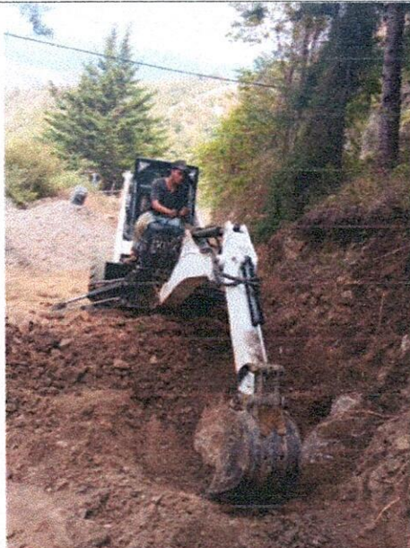
Replanteo y excavaciones varias en material común.
