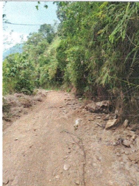
Replanteo y excavaciones varias en material común.
