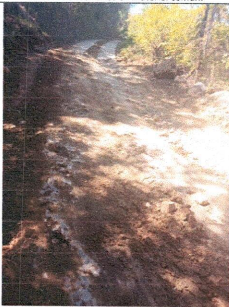
Replanteo y excavaciones varias en material común.
