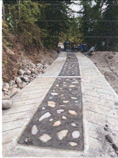
Suministro e instalación de concreto de 3.000 psi para estructuras de placa huella
