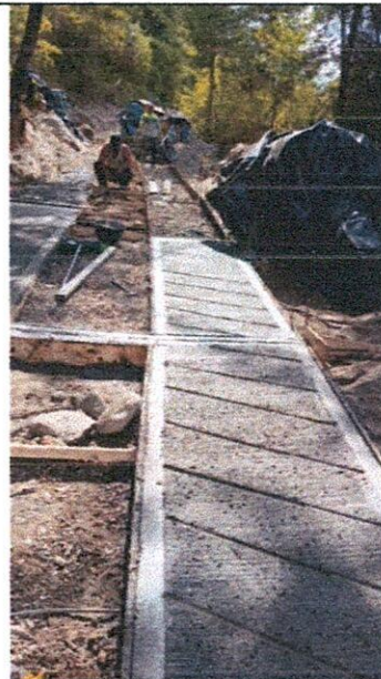
Suministro e instalación de concreto de 3.000 psi para estructuras de placa huella
