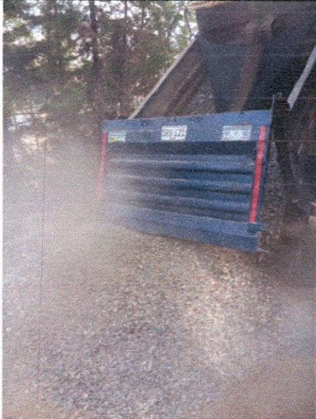
Material tipo sub-base clase a de espesor 0,15. Incluye transporte.
