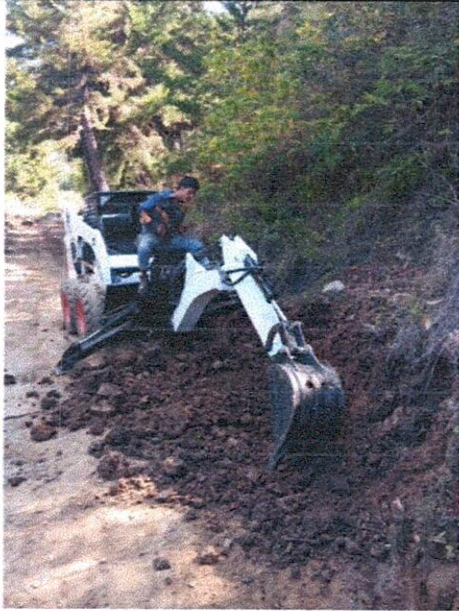
Excavaciones varias en material común.
