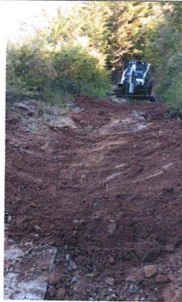
Excavaciones varias en material común.
