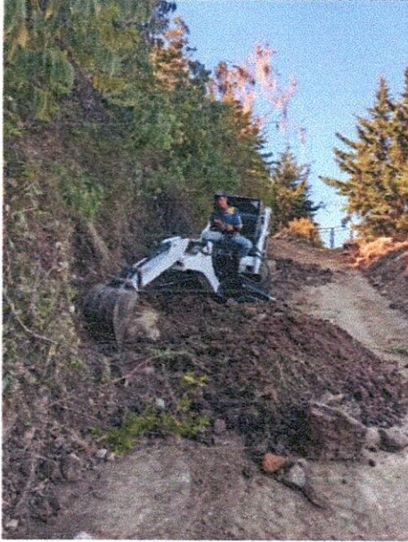
Excavaciones varias en material común.
