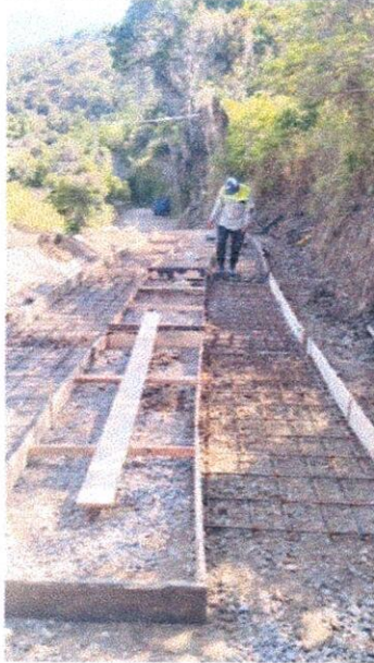
Acero de refuerzo de 4200 mpa para placas, vigas, cunetas y bordillos.
