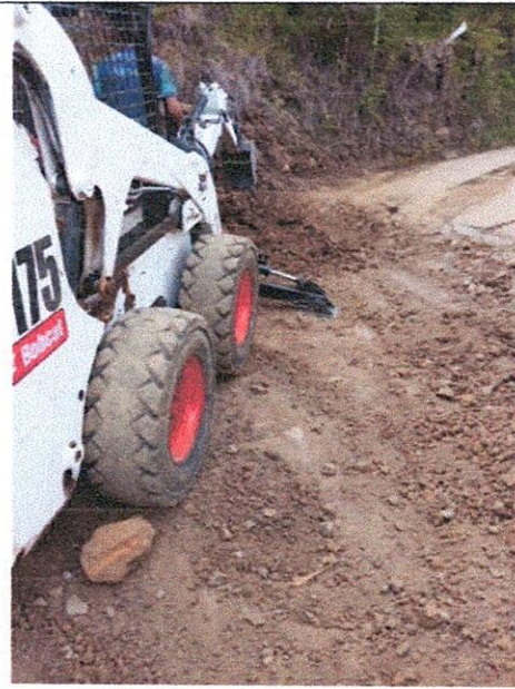
Excavaciones varias en material común.
