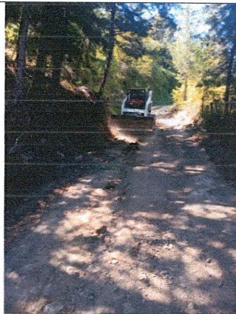
Excavaciones varias en material común.
