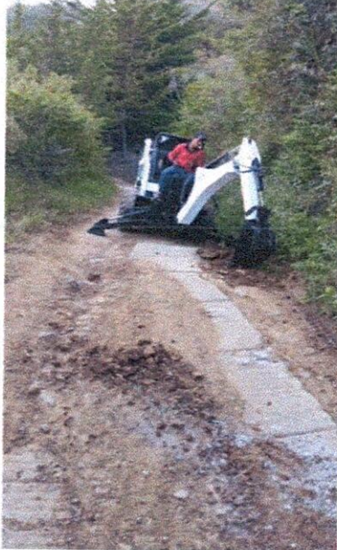
Excavaciones varias en material común.
