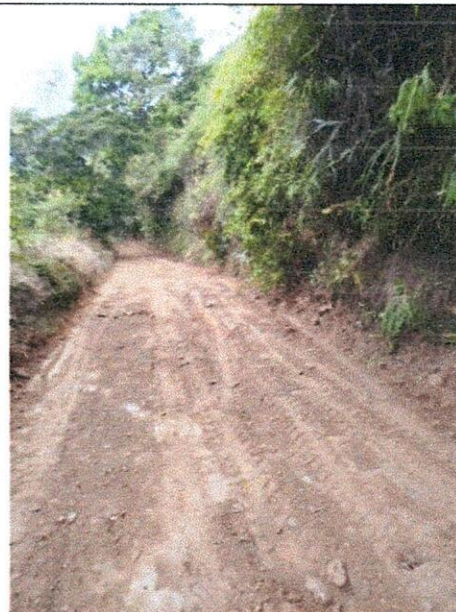
Replanteo y excavaciones varias en material común.
