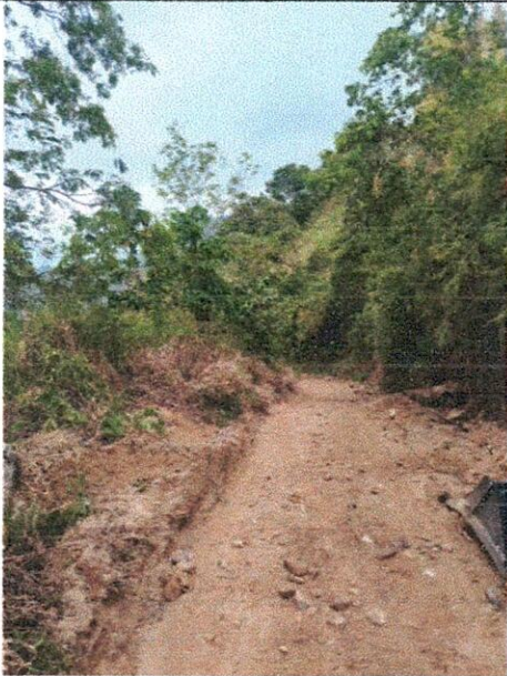
Replanteo y excavaciones varias en material común.
