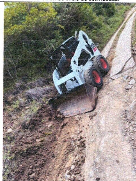
Excavaciones varias en material común.
