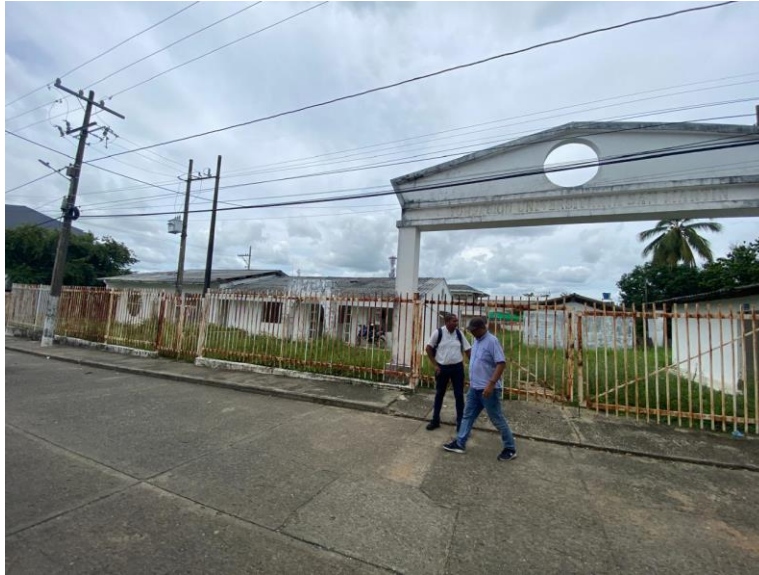
Ilustración 11 Registro Fotografico de Cerramiento
