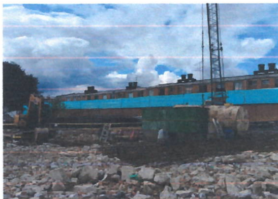
Fig. 13 suministro e instalación de acero de refuerzo 60000 psi. Cimentación
