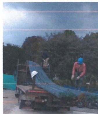
Fig. 14 suministro e instalación de acero de refuerzo 60000 psi. Cimentación
