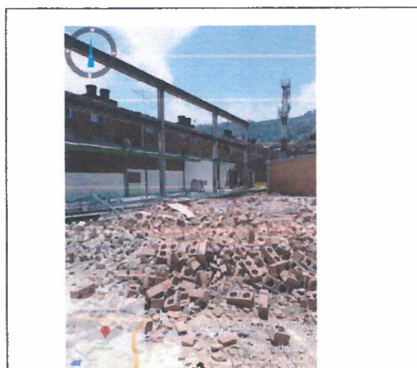
Fig. 10 Cárcamos existentes para demolición.
