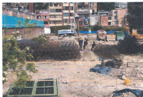
Fig. 6 Instalación de acero de refuerzo.
