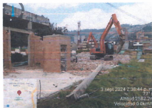
Fig. 7 Demolición de adoquines
