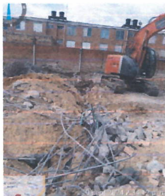
Fig. 11 Separación acero de refuerzo estructuras existentes
