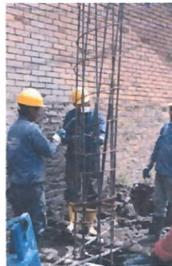
Fig. 21 instalación parillas pilotes
