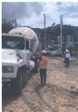
Fig. 25 suministro de concreto
