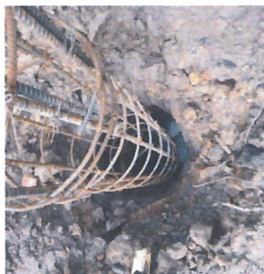
Fig. 22 instalación acero pilotes
