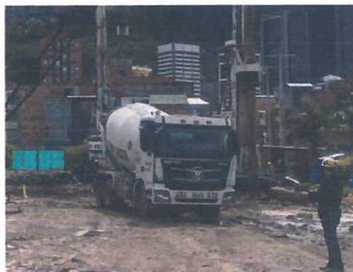
Fig. 26 suministro de concreto
