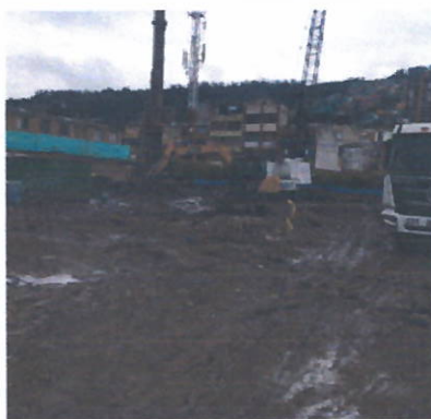
Fig. 24 retiro de material de excavación
