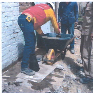
Fig. 33 Ejecución ensayo Slump
