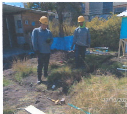
Fig. 14 excavación Zona dura y blanda, perfilación, montaje de tuberías
