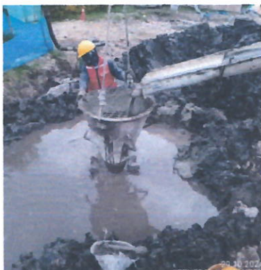
Fig. 27 Fundida de pilotes
