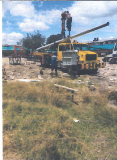
Fig. 10 Suministro e instalación de poste 12 mts
