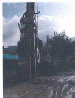
Fig. 19 Excavacion para Construcción pilotes
