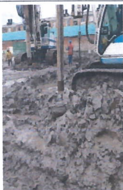
Fig. 18 Excavacion para construcción de pilotes
