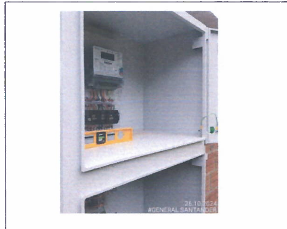
Fig. 15 Suministro e instalación de Tablero de Medida indirecta.
