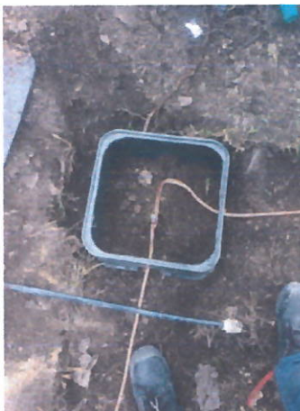
Fig. 17 malla de puesta a tierra.
