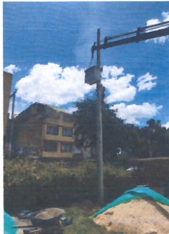
Fig. 11 instalación transformador de 75 KVA
