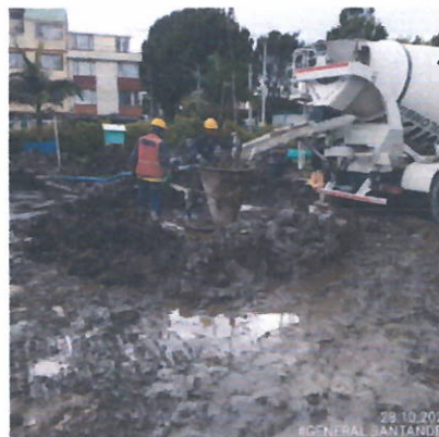
Fig. 28 Fundida de pilotes
