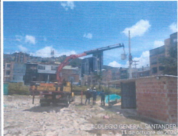
Fig. 12 instalación transformador de 75 KVA
