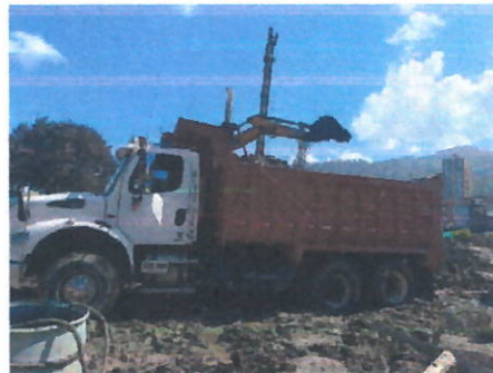
Fig. 16 retiro de material de excavación
