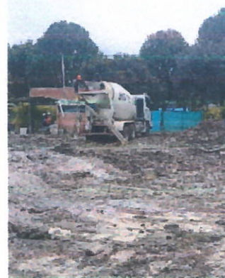
Fig. 20 Fundida de pilotes
