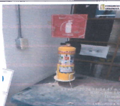
Fig. 28 inspección elementos de emergencia
