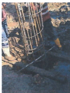
Fig. 14 instalación acero pilotes
