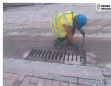
Fig. 26 Limpieza de vías de acceso al proyecto
