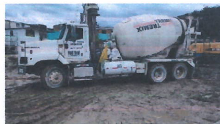
Fig. 18 suministro de concreto
