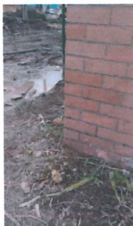
Imagen 3: Acopio residuo vegetal y eliminación de tocones
