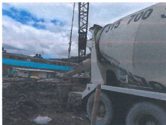
Fig. 5 Construcción de pilotes, suministro de concreto
