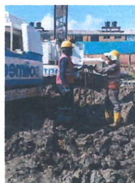
Fig. 13 instalación parillas pilotes
