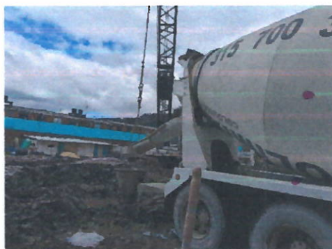
Fig. 19 Fundida de pilotes
