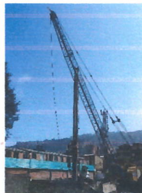
Fig. 11 Excavación para Construcción pilotes
