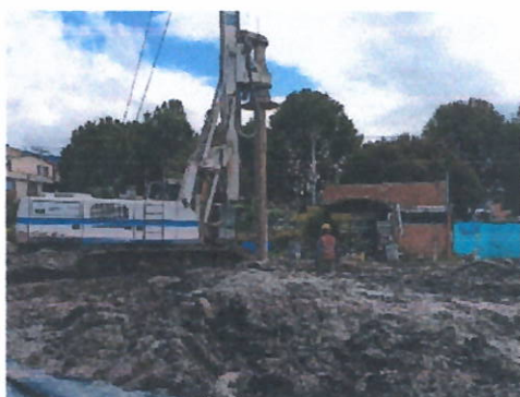
Fig. 10 Excavación para construcción de pilotes
