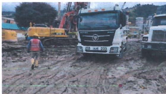
Fig. 17 suministro de concreto
