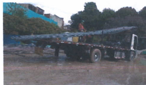
Fig. 7 suministro de acero
