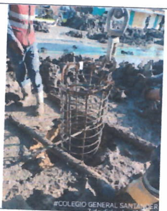
Fig. 15 instalación acero pilotes
