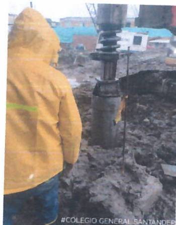
Fig. 12 Excavación para Construcción pilotes
