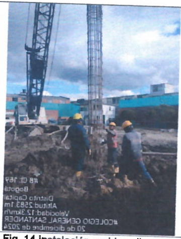
Fig. 14 Instalación parrillas pilotes
