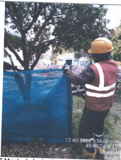
Fig. 27 Mantenimiento de sumideros perimetrales al frente de trabajo
