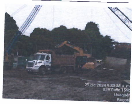
Fig. 17 retiro de material de excavación
