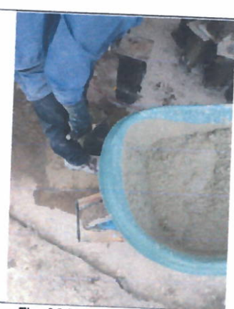
Fig. 36 Toma de asentamiento
