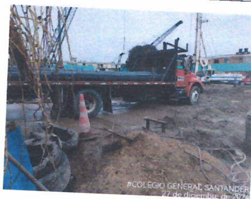
Fig. 8 suministro de acero
