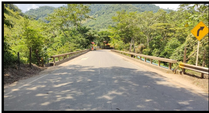
Sector PR 80 – Tramo de mantenimiento de vía
