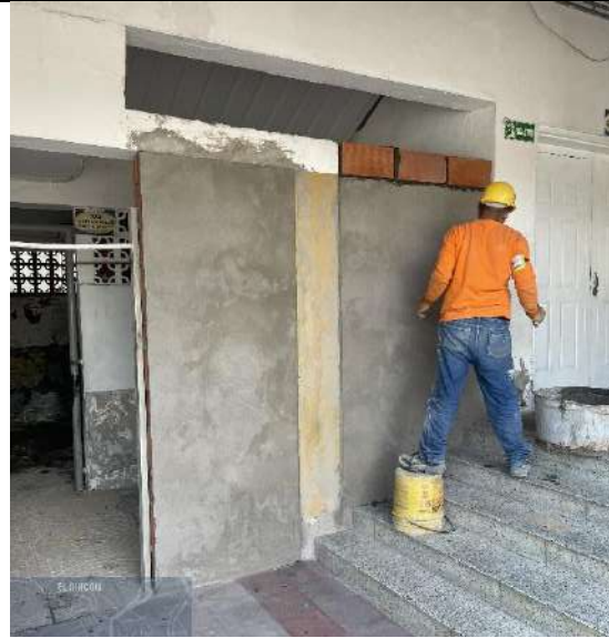
FRENTE 5-SE ANTONIO JOSE RESTREPO-LEVANTAMIENTO DE MURO BAÑO NIÑAS
