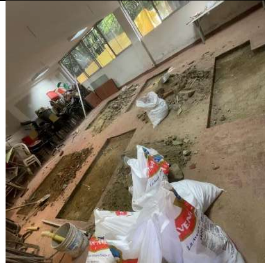
FRENTE 6- SE LAS PLAYAS- DEMOLICION DE LABORATORIO
