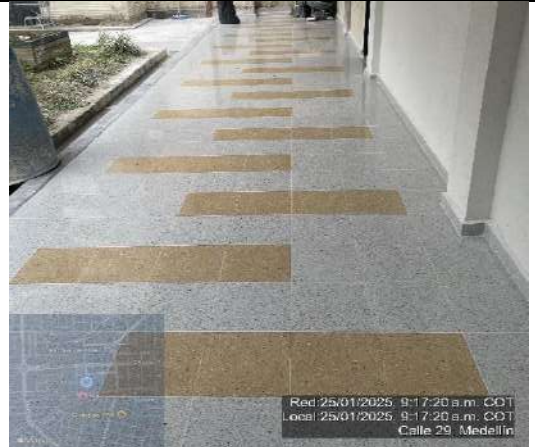
FRENTE 4-IE YERMO Y PARRES-PULIDA PISO PASILLO AULAS NUEVAS
