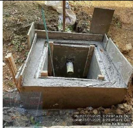
FRENTE 6- SE LAS PLAYAS- VACIADO CONCRETO CAJAS DE INSPECCION
