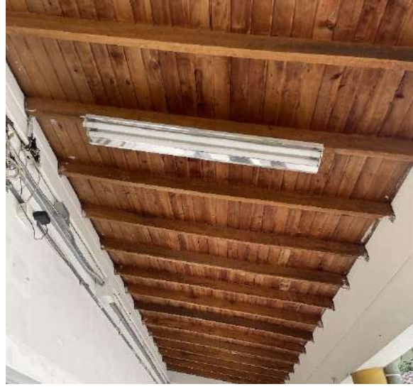
FRENTE 5-SE ANTONIO JOSE RESTREPO-ACTIVIDADES ELECTRICAS
