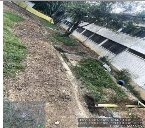
FRENTE 6- SE LAS PLAYAS-INSTALACION TUBERIA DE 4" Y 6"
