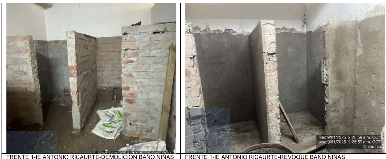
FRENTE 1-IE ANTONIO RICAURTE-DEMOLICION BAÑO NIÑAS
