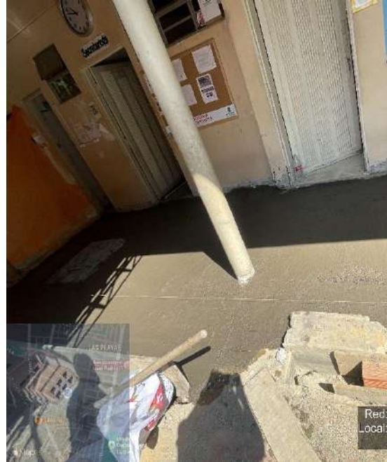
FRENTE 6- SE LAS PLAYAS- VACIADO MORTERO PASILLO, OFICINA Y BAÑO
