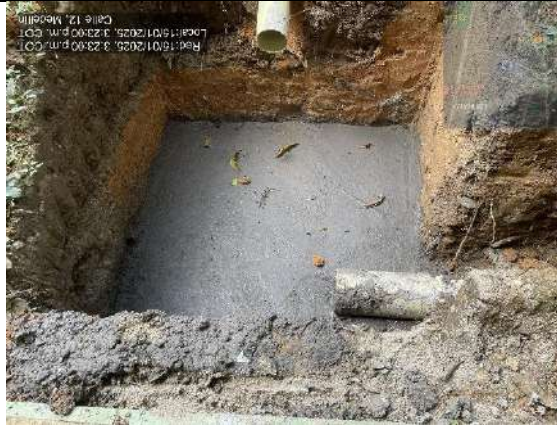
FRENTE 6- SE LAS PLAYAS- VACIADO SOLADOS
