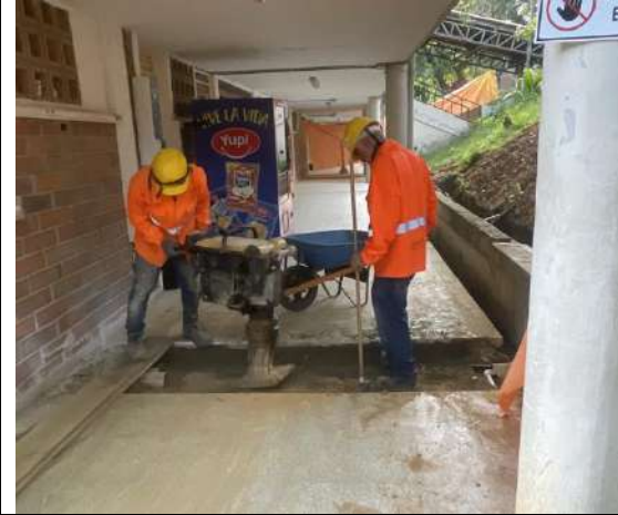
FRENTE 6- SE LAS PLAYAS- LLENOS Y COMPACTACION DE EXCAVACIONES
