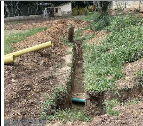
FRENTE 6- SE LAS PLAYAS- EXCAVACION BRECHAS
