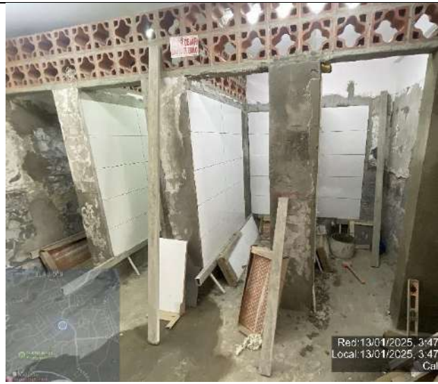
FRENTE 5-SE ANTONIO JOSE RESTREPO-REVOQUE Y ENCHAPE BAÑOS NIÑAS
