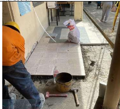
FRENTE 6- SE LAS PLAYAS- ENCHAPE PISO PASILLO SECRETARIA
