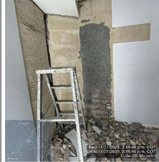
FRENTE 5-SE ANTONIO JOSE RESTREPO-MANTENIMIENTO A MURO DE RESTAURANTE
