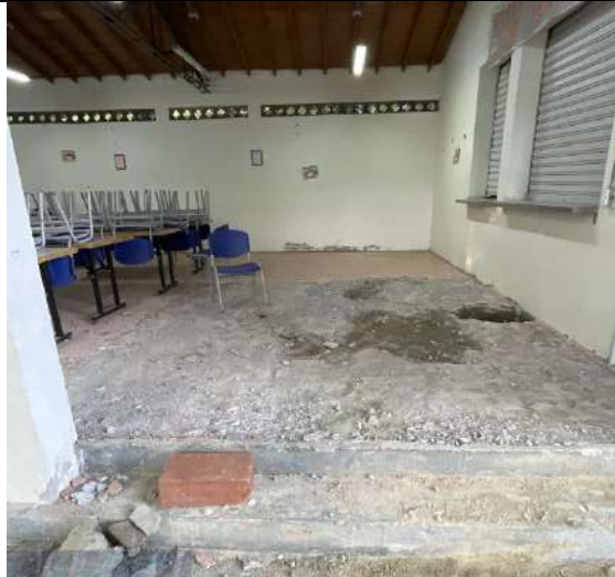
FRENTE 6- SE LAS PLAYAS- DEMOLICION PISO RESTAURANTE
