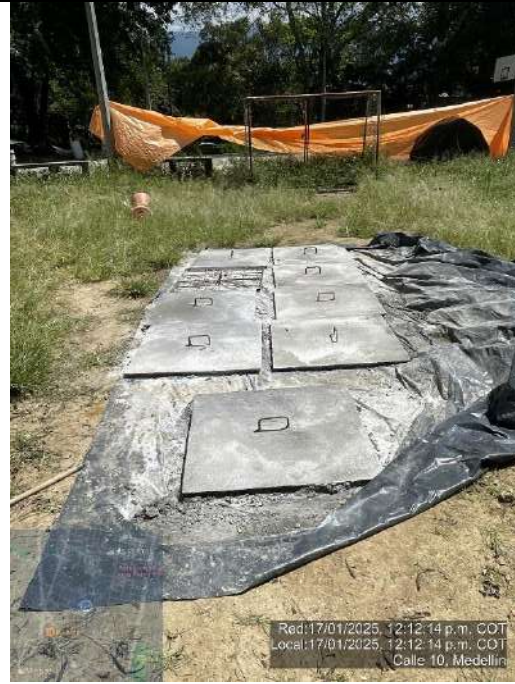
FRENTE 6- SE LAS PLAYAS- TAPAS DE CAJAS DE INSPECCION
