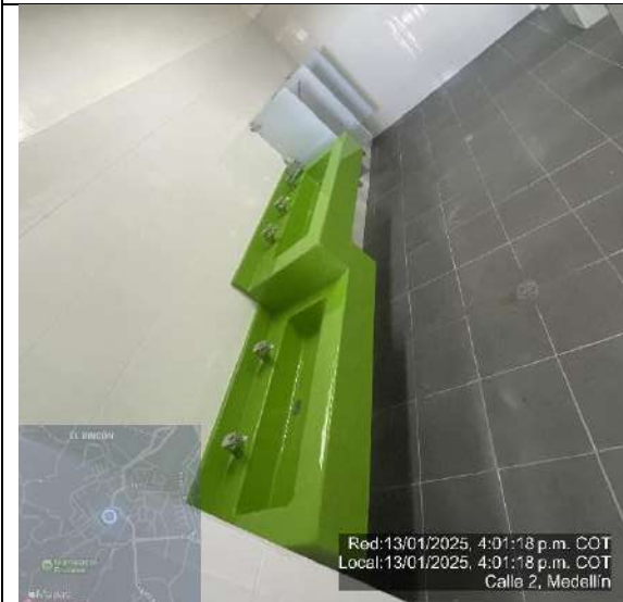
FRENTE 5-SE ANTONIO JOSE RESTREPO-INSTALACION DE QUAZAR EN BAÑO DE NIÑOS
