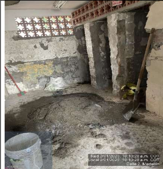
FRENTE 5-SE ANTONIO JOSE RESTREPO-DEMOLICION BAÑO NIÑAS
