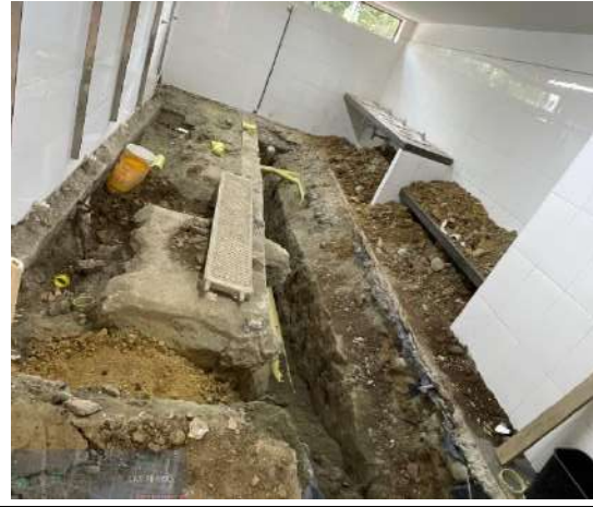
FRENTE 6- SE LAS PLAYAS- DEMOLICION Y RETIRO DE UNIDADES SANITARIAS
