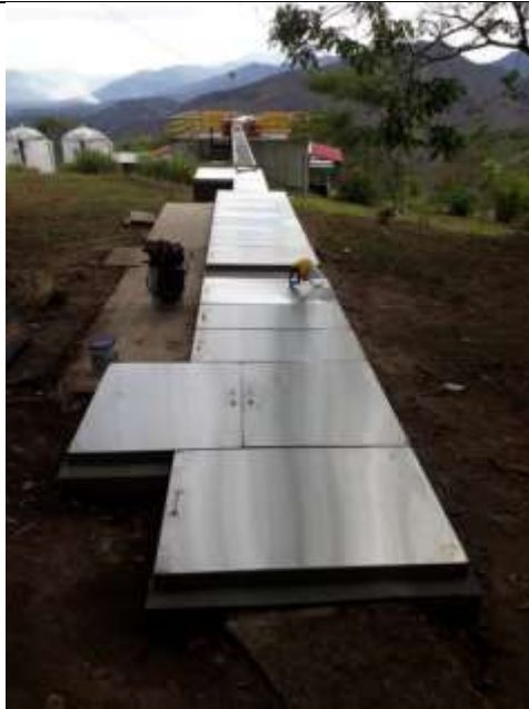
FOTOGRAFIA 3 Y 4: TAPAS EN ACERO INOXIDABLE CALIBRE 18 Y ESTRUCTURA PERIMETRA EN ANGULO DE 11/2"X1/8" REFERENCIA 304.
