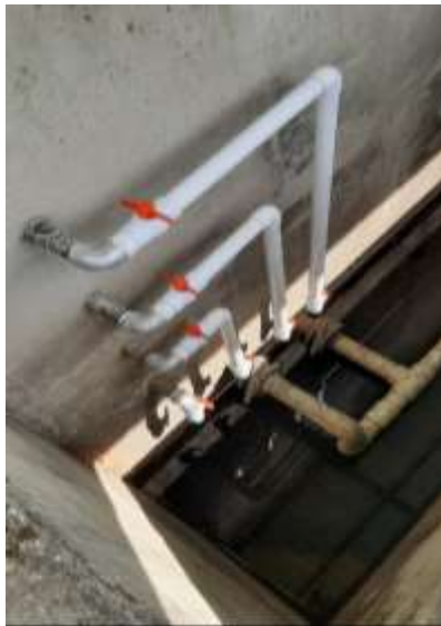
FOTOGRAFIA 9 Y 10: TOMAS DE MUESTRAS DE LODOS CONSTRUIDAS PARA LOS 4 TANQUES.
