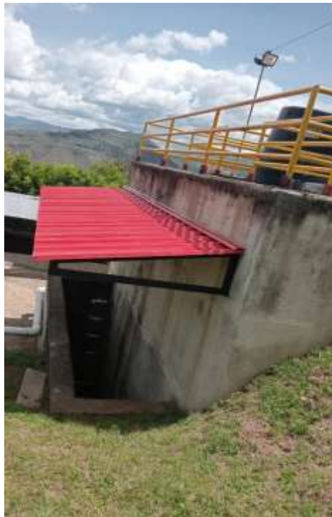
FOTOGRAFIA 5 Y 6: CUBIERTAS CAJAS DE VALVULAS DE TOMA DE MUESTRAS DE LOS LODOS
