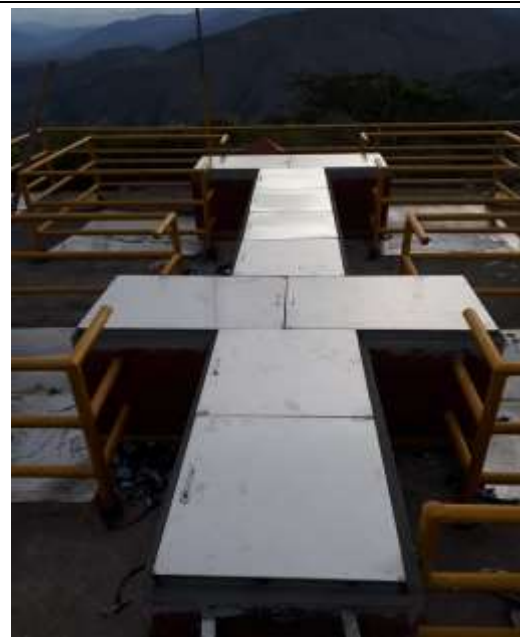
FOTOGRAFIA 3 Y 4: TAPAS EN ACERO INOXIDABLE CALIBRE 18 Y ESTRUCTURA PERIMETRA EN ANGULO DE 11/2"X1/8" REFERENCIA 304.
