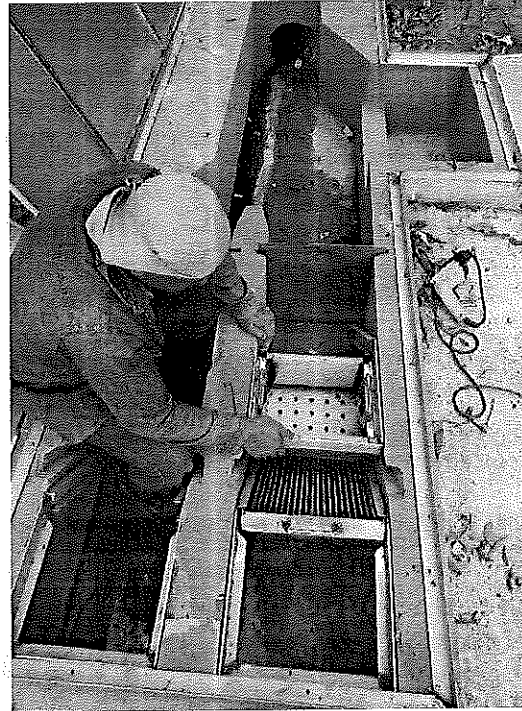
FOTOGRAFIA 1 Y 2: PROCESO DE CONSTRUCCION E INTALACION REJAS DE CRIBADO
