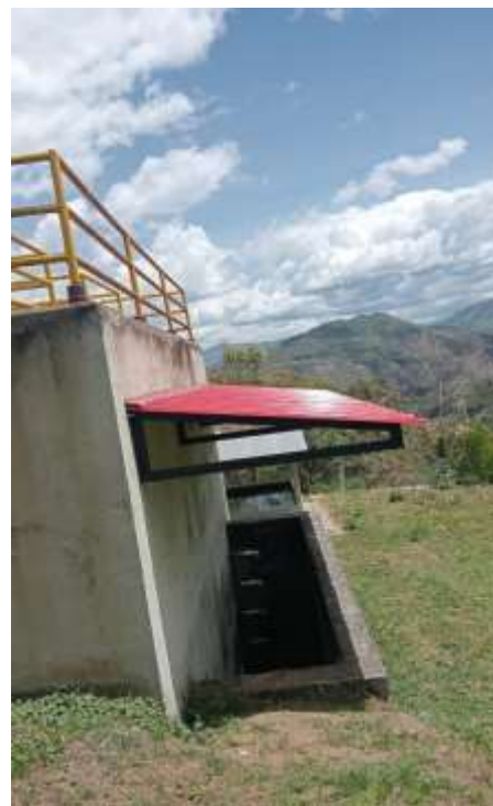
FOTOGRAFIA 5 Y 6: CUBIERTAS CAJAS DE VALVULAS DE TOMA DE MUESTRAS DE LOS LODOS
