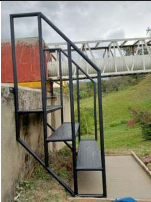
FOTOGRAFIA 7 Y 8: ESCALERA EN TUBERIA A.N. DIAMETRO 1" CALIBRE 16 LAMINA ALFAJOR DE 2.5 MILIMETROS.
