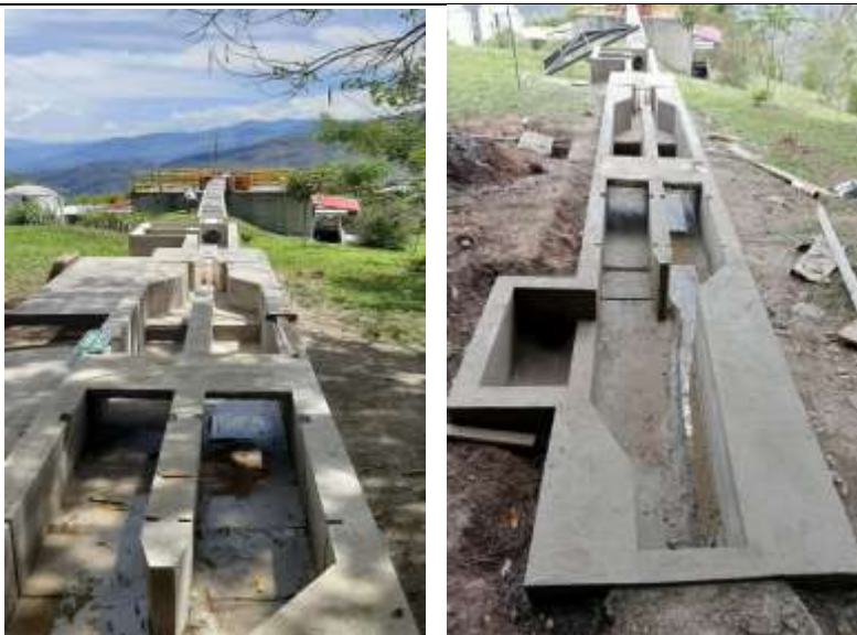
FOTOGRAFIA 11 Y 12: UNIDADES DE PRETRATAMIENTO RESANADAS Y PAÑETAS EN SU TOTALIDAD
