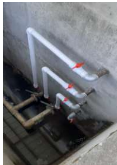
FOTOGRAFIA 9 Y 10: TOMAS DE MUESTRAS DE LODOS CONSTRUIDAS PARA LOS 4 TANQUES.
