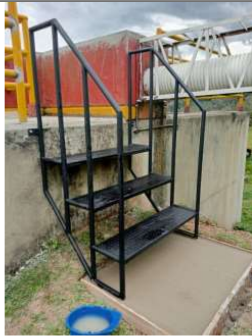
FOTOGRAFIA 7 Y 8: ESCALERA EN TUBERIA A.N. DIAMETRO 1" CALIBRE 16 LAMINA ALFAJOR DE 2.5 MILIMETROS.
