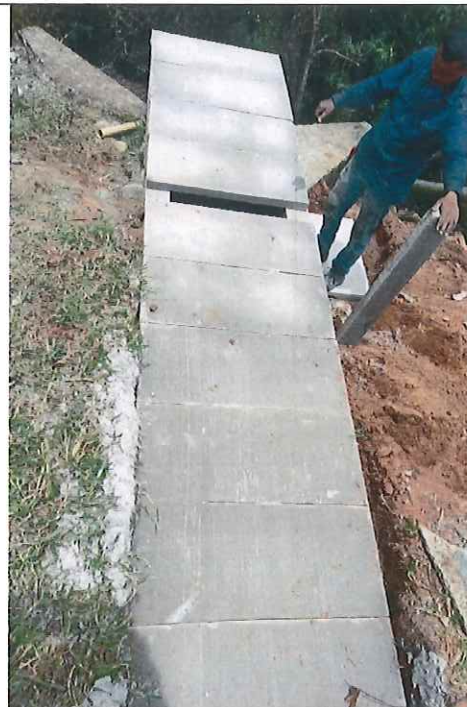
FOTOGRAFIA 19 Y 20: CAJILLA FINAL DE RECIBO DEL EFLUENTE. FACILITA MEDICION DE CAUDALES.
