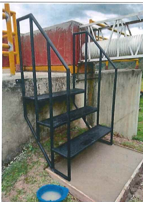
FOTOGRAFIA 8 Y 9: ESCALERA EN TUBERIA A.N. DIAMETRO 1" CALIBRE 16 LAMINA ALFAJOR DE 2.5 MILIMETROS.
