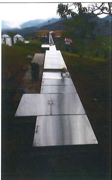
FOTOGRAFIA 3, 4 y 5: TAPAS EN ACERO INOXIDABLE CALIBRE 18 Y ESTRUCTURA PERIMETRA EN ANGULO DE 11/2"X1/8" REFERENCIA 304.
