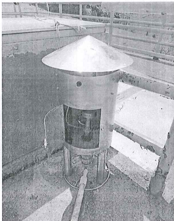
FOTOGRAFIA 14: QUEMADOR DE GASES EN ACERO INOXIDABLE 304.
