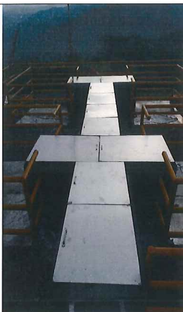
FOTOGRAFIA 3, 4 y 5: TAPAS EN ACERO INOXIDABLE CALIBRE 18 Y ESTRUCTURA PERIMETRA EN ANGULO DE 11/2"X1/8" REFERENCIA 304.
