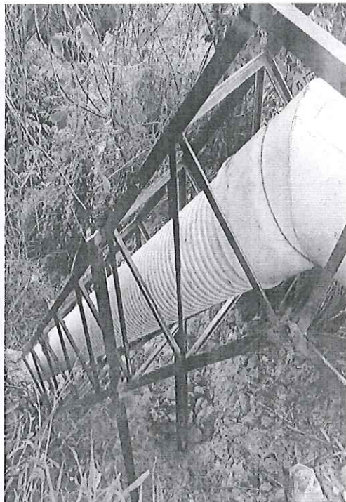
FOTOGRAFIA 17 Y 18: CERCHA METALICA PARA SOPORTE DE TUBERIA DE DESCARGA DEL EFLUENTE DE LA PTAR.
