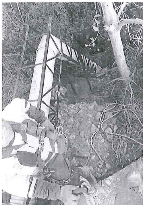
FOTOGRAFIA 17 Y 18: CERCHA METALICA PARA SOPORTE DE TUBERIA DE DESCARGA DEL EFLUENTE DE LA PTAR.
