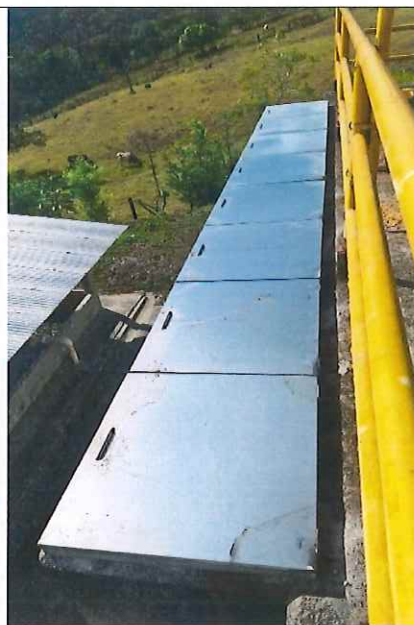
FOTOGRAFIA 3, 4 y 5: TAPAS EN ACERO INOXIDABLE CALIBRE 18 Y ESTRUCTURA PERIMETRA EN ANGULO DE 11/2"X1/8" REFERENCIA 304.
