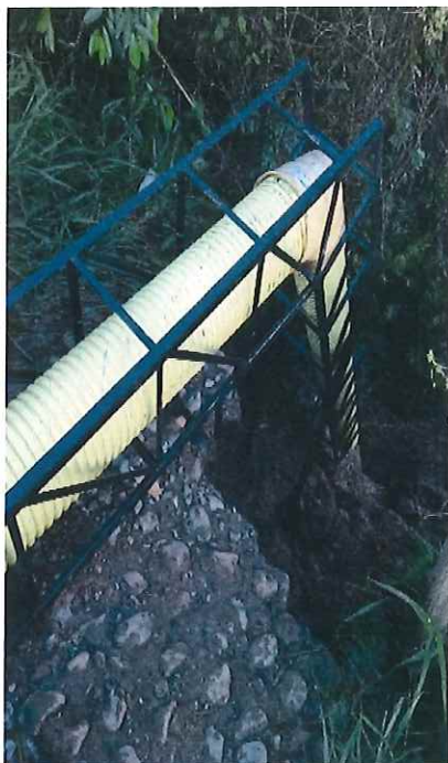
FOTOGRAFIA 21 Y 22: TUBERIA CORRUGADA SELLO HERMETICO DE 315 MILÍMETROS. DESCARGA DEL EFLUENTE DE LA PTAR.
