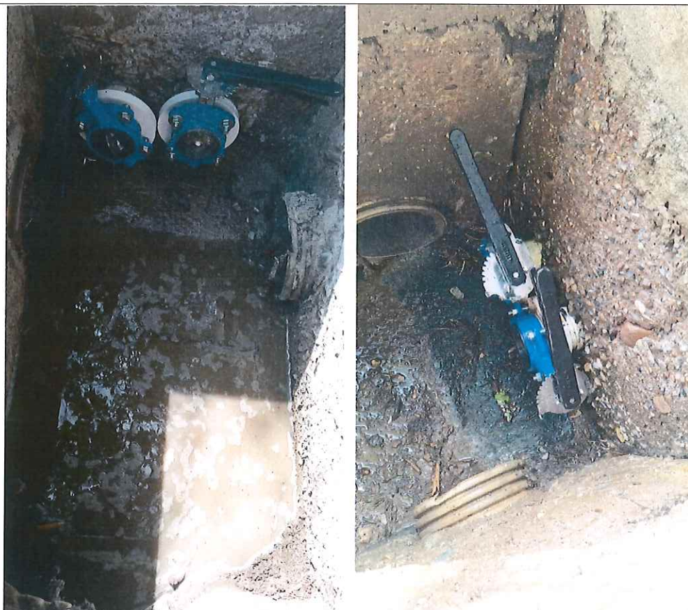
FOTOGRAFIA 23 Y 24: VALVULAS MARIPOSAS DE 3" PARA CONTROL DE LAVADO DE LOS DESARENADORES DE LAS UNIDADES DE PRETRATAMIENTO DE LA PTAR.
