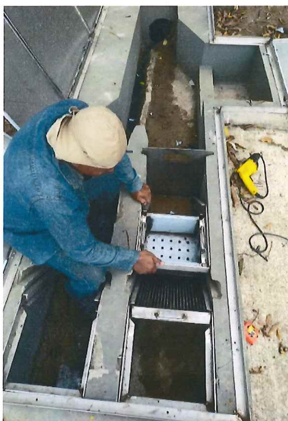
FOTOGRAFIA 1 Y 2: PROCESO DE CONSTRUCCION E INTALACION REJAS DE CRIBADO
