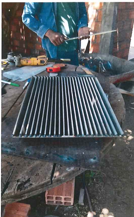
FOTOGRAFIA 1 Y 2: PROCESO DE CONSTRUCCION E INTALACION REJAS DE CRIBADO
