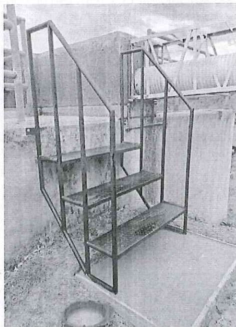
FOTOGRAFIA 8 Y 9: ESCALERA EN TUBERIA A.N. DIAMETRO 1" CALIBRE 16 LAMINA ALFAJOR DE 2.5 MILIMETROS.
