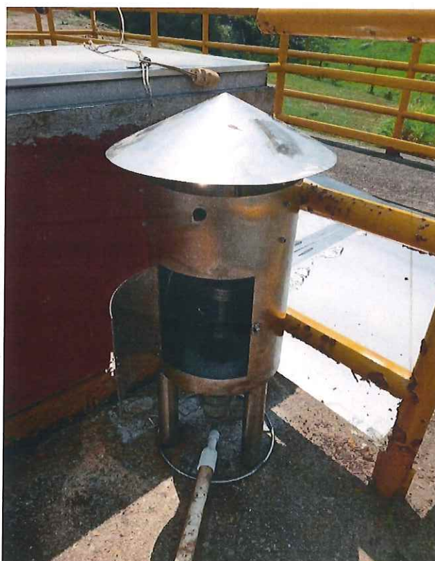
FOTOGRAFIA 14: QUEMADOR DE GASES EN ACERO INOXIDABLE 304.
