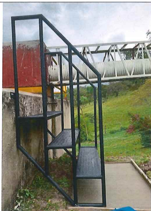
FOTOGRAFIA 8 Y 9: ESCALERA EN TUBERIA A.N. DIAMETRO 1" CALIBRE 16 LAMINA ALFAJOR DE 2.5 MILIMETROS.
