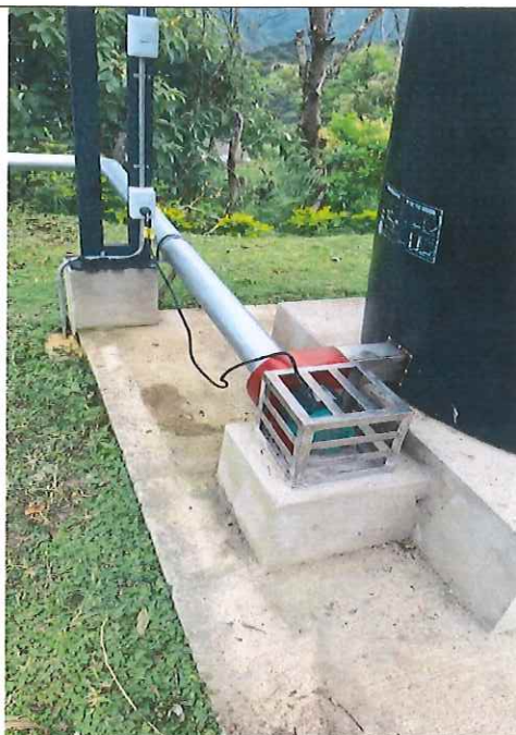
FOTOGRAFIA 15 Y 16: FILTRO PARA CONTROL DE OLORES. CON VENTILADOR CENTRIFUGO.
