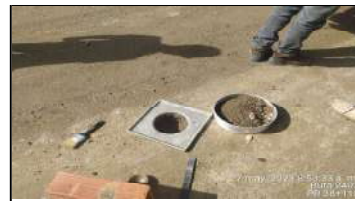
Ensayos de densidad en sub-sante. PB 28+110
