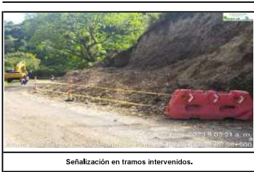
Señalización en tramos intervenidos.
