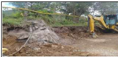
Excavación de roca en margen derecha para construcción de filtros. PB 37+900
