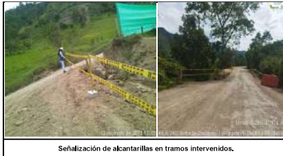
Señalización de alcantarillas en tramos intervenidos.
