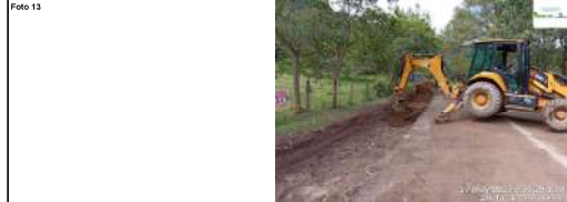
Ruta 2402, Instalación de material para mejoramiento de subrasante.
