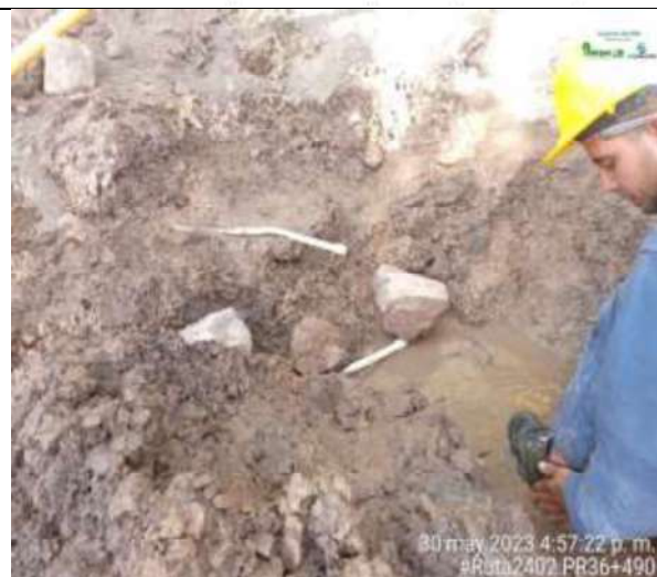
Foto 16: Reparación manguera de agua. Fecha: 30 de mayo de 2023 Lugar: Pr 36+490
