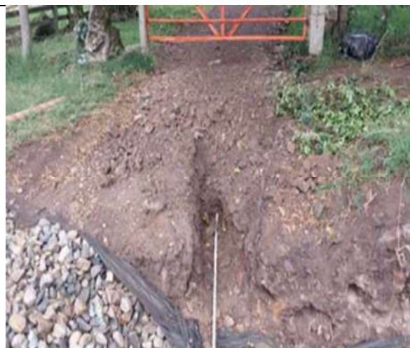
Foto 12: Reparación manguera de agua. Fecha: 21 de mayo de 2023 Lugar: Pr 37+960
