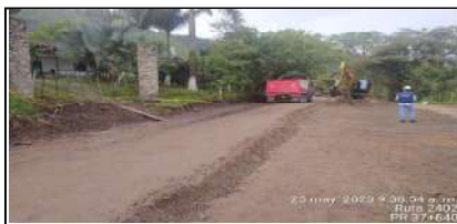
Excavación para aproximación de Sub-Rasante PR 37+640.
