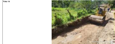
Ruta 2402, Compactación de subrasante para instalación de material de mejoramiento.
