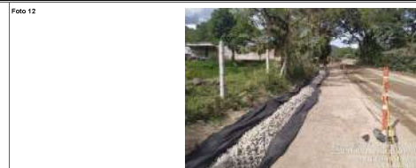
Ruta 2402, Construcción de filtro granular
