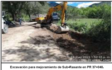
Excavación para mejoramiento de Sub-Rasante en PR 37+040.
