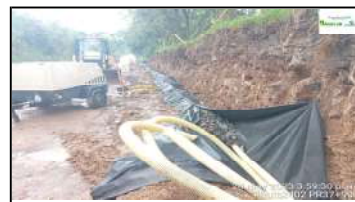
Instalación de Filtro en PR 37+900 a menores. Margen Derecha
