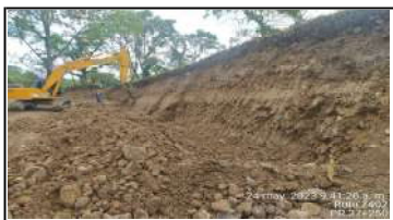
Excavación y perfilado de talud para ampliación de calzada PR 37+250.
