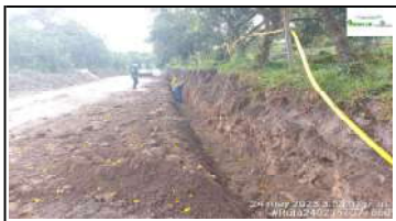
Excavación para construcción de filtros. Margen Derecha PB 37+860.
