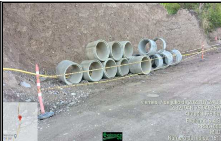
Ruta 2402: Prefabricados acordonados y señalizados
