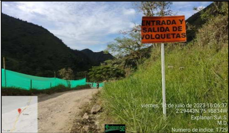
Ruta 2402: Cerramiento zona de nivelación predio PR 32+739
