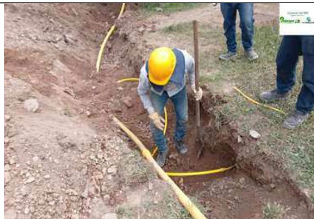
Foto 17: Reparación red de gas.
