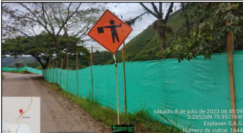
Ruta 2402: Cerramiento zona de nivelación predio PR 32+739
