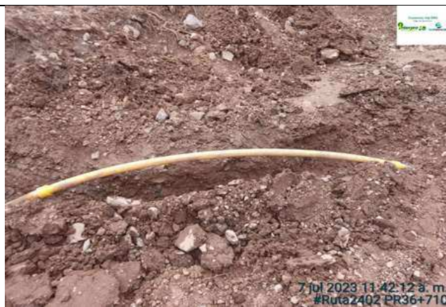
Foto 17: Reparación red de gas.
