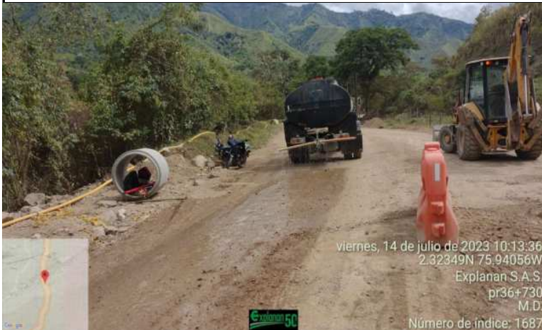
Ruta 2402: Humectación de vías
