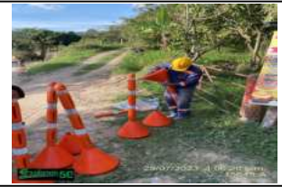
Adecuación e instalación de señalización en fretes de obra
