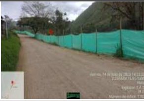
Cerramiento zona Nivelación PR 32+739.
