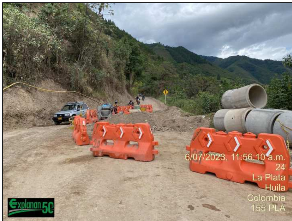
Fotografía – Obra PR 37+200
