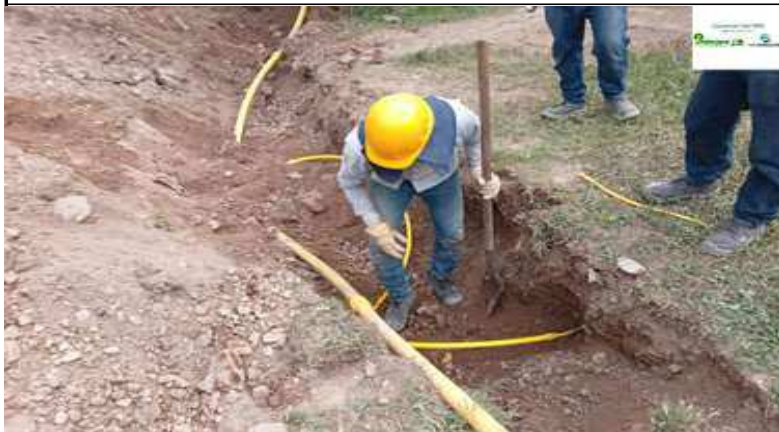
Ruta 2402. Reparación Red de Agua PR 36+720
