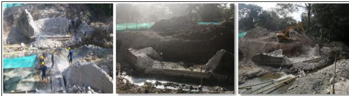
AVANCE DEMOLICIÓN EJE #2
