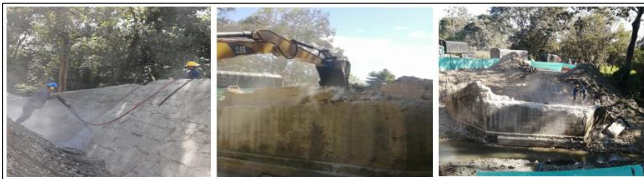
DEMOLICION ESTRIBO EJE #2
