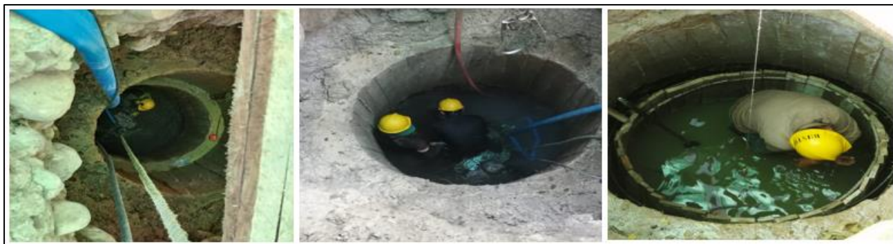
EXCAVACIÓN EN ROCA BAJO AGUA
