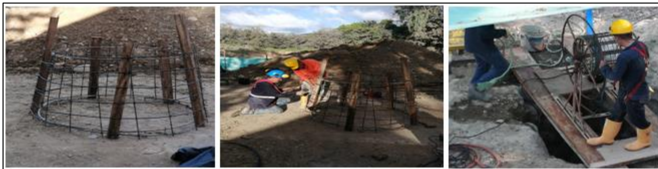
ACERO 420 MPA PARA ANILLO CAISSON
