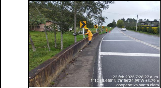
LIMPIEZA DE CUNETAS
