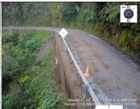
LIMPIEZA DE MUROS
