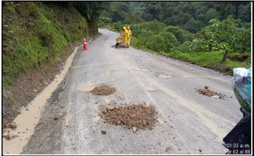
BACHEO EN AFIRMADO
