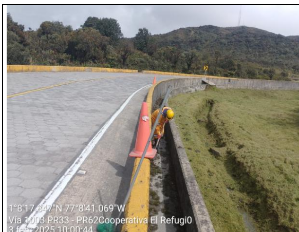
LIMPIEZA DE CANAL REVESTIDO
