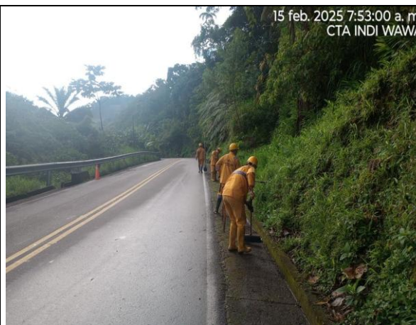
LIMPIEZA DE CUNETAS
