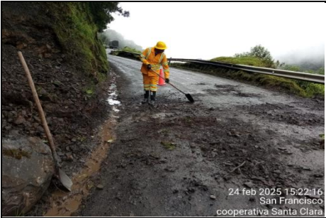
DESPEJE DE DERRUMBE
