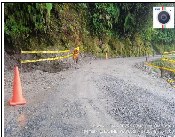
SEÑALIZACION CON CINTA
