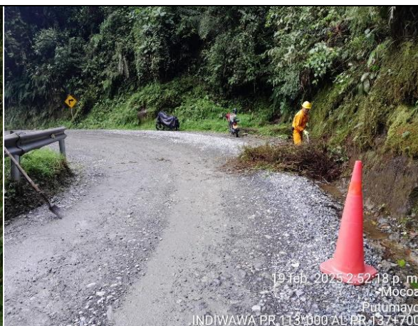
DESPEJE DE MATERIAL VEGETAL
