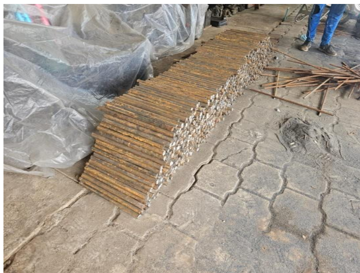
FOTO 06. Barras acero de transferencia de cargas.
