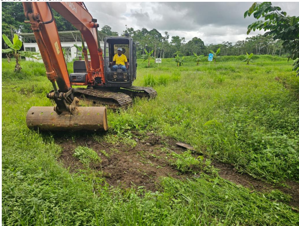
FOTOGRAFÍA 07. RELLENO CON MATERIAL DE EXCAVACIÓN.
