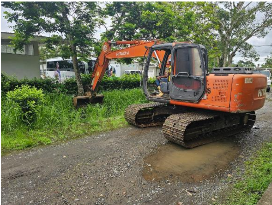
FOTOGRAFÍA 06. VISTA GENERAL ACTIVIDADES DE EXCAVACIÓN. – ACCIÓN DE RETROEXCAVADORA..
