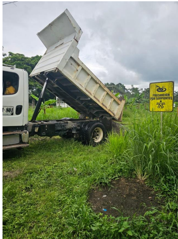
FOTO 05. SUMINISTRO MATERIAL DE AFIRMADO
