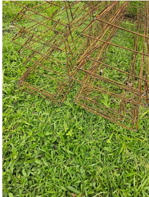
FOTO 05. CANASTILLAS DE ACERO DE REFUERZO PAVIMENTO
