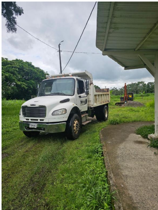
FOTO 06. DESALOJO DE MATERIAL SOBRENTE.
