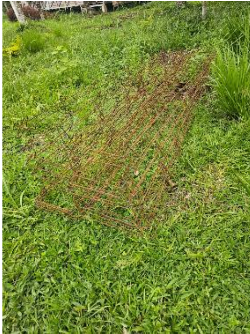
FOTO 05. CANASTILLAS DE ACERO DE REFUERZO PAVIMENTO
