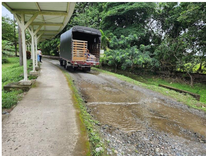
FOTOGRAFÍA 03. VISTA GENERAL DEL PROYECTO
