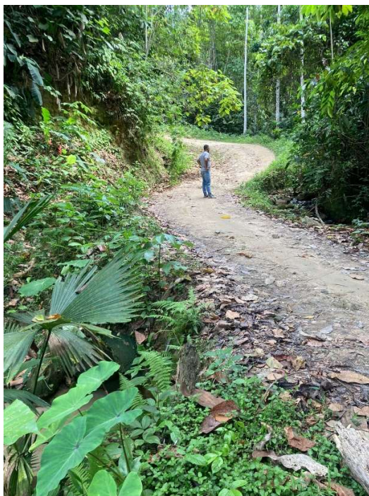
Imagen 4. Estado inicial tramo 1.
