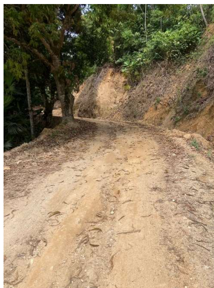
Imagen 3. Estado inicial tramo 1.
