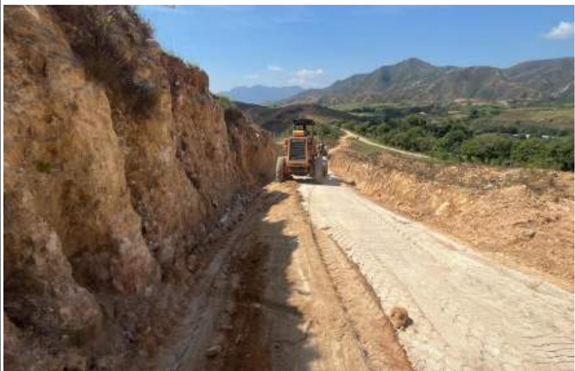
UBICACIÓN: ABREGO – CORREDOR 1 LA YEE DEL CHORRO DESCRIPCIÓN DE ACTIVIDAD: INSTALACION DE SUB-BASE
