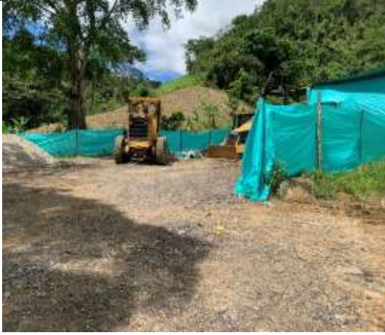
Estacionamiento de maquinaria.
