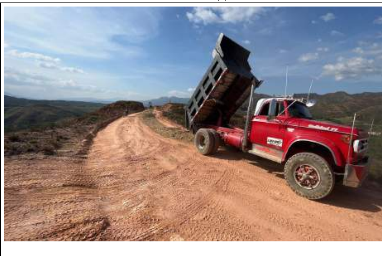
UBICACIÓN: ABREGO – CORREDOR 1 LA YEE DEL CHORRO DESCRIPCIÓN DE ACTIVIDAD: DESCARGUE DE SUB-BASE
