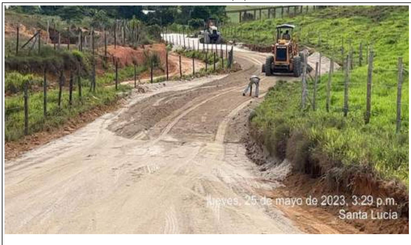
UBICACIÓN: ABREGO – CORREDOR 1 SANTA LUCIA DESCRIPCIÓN DE ACTIVIDAD: INSTALACION DE SUB BASE
