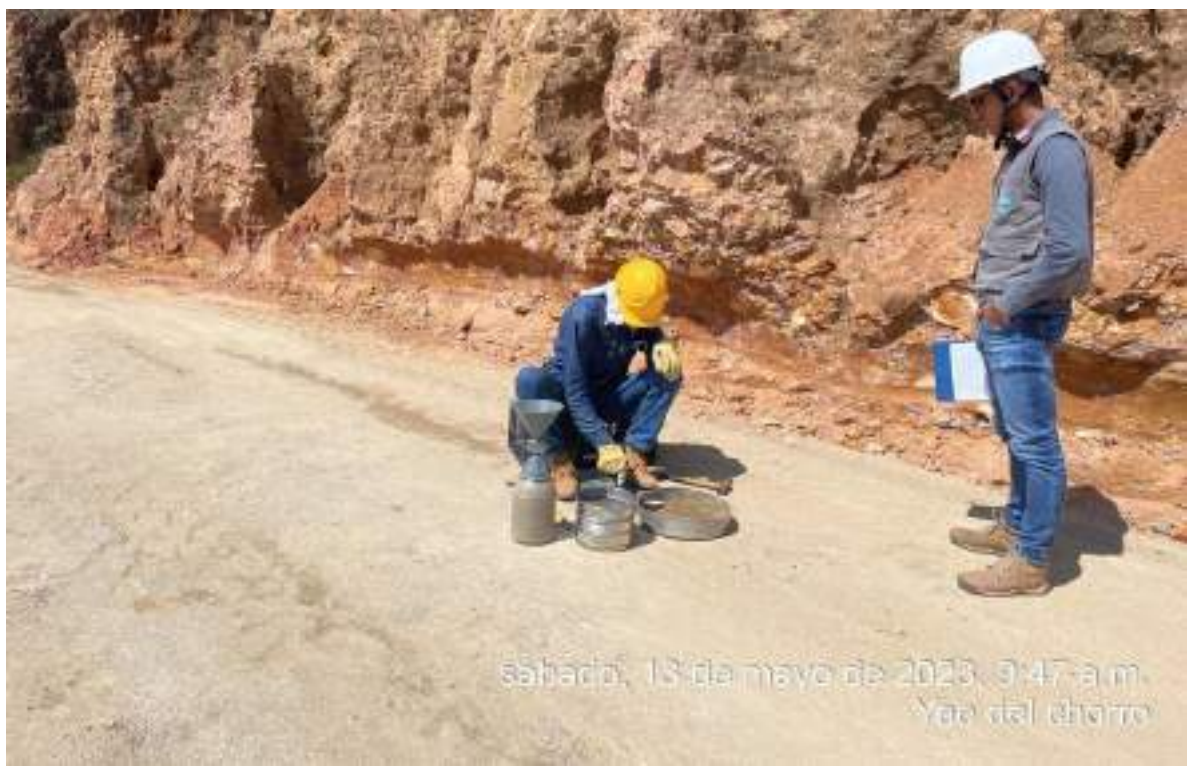
UBICACIÓN: ABREGO – CORREDOR 1 LA YEE DEL CHORRO DESCRIPCIÓN DE ACTIVIDAD: TOMA DE DENSIDADES PRIMERA CAPA
