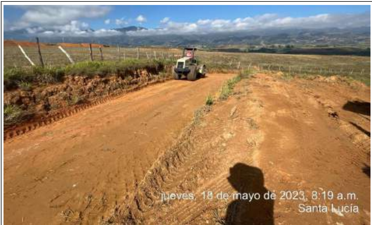
UBICACIÓN: ABREGO – CORREDOR 1 SANTA LUCIA 1 DESCRIPCIÓN DE ACTIVIDAD: COMPACTACION VIA ALTERNA
