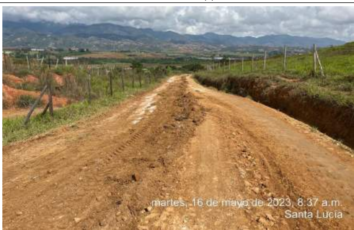
UBICACIÓN: ABREGO – CORREDOR 1 SANTA LUCIA DESCRIPCIÓN DE ACTIVIDAD: PERFILADO DE LA VIA
