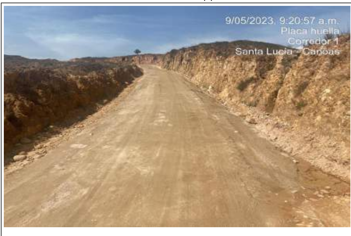
UBICACIÓN: ABREGO – CORREDOR 1 LA YEE DEL CHORRO DESCRIPCIÓN DE ACTIVIDAD: INSTALACION DE SUB-BASE
