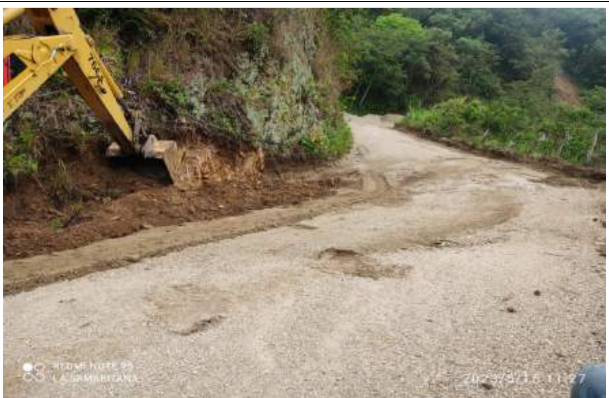
UBICACIÓN: LA SAMARITANA PR 15+0410 DESCRIPCIÓN DE ACTIVIDAD: ADECUACION DE CUNETAS
