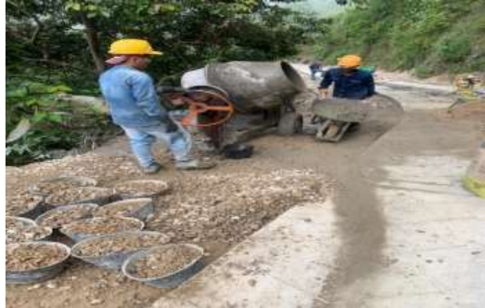
Actividades realizadas en obra
