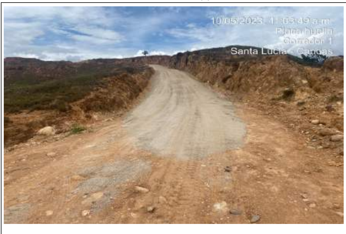
UBICACIÓN: ABREGO – CORREDOR 1 LA YEE DEL CHORRO DESCRIPCIÓN DE ACTIVIDAD: COMPACTACION DE SUB-BASE
