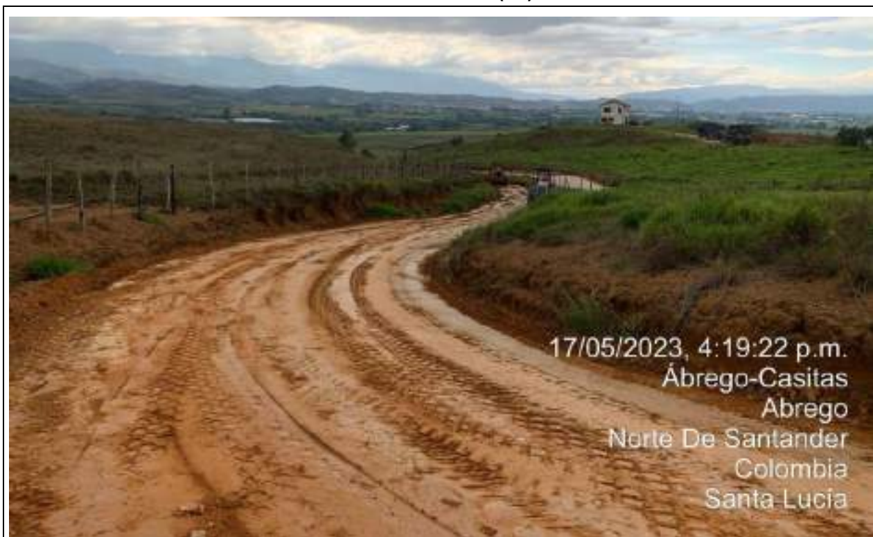
UBICACIÓN: ABREGO – CORREDOR 1 SANTA LUCIA DESCRIPCIÓN DE ACTIVIDAD: ADECUACION VIA ALTERNA
