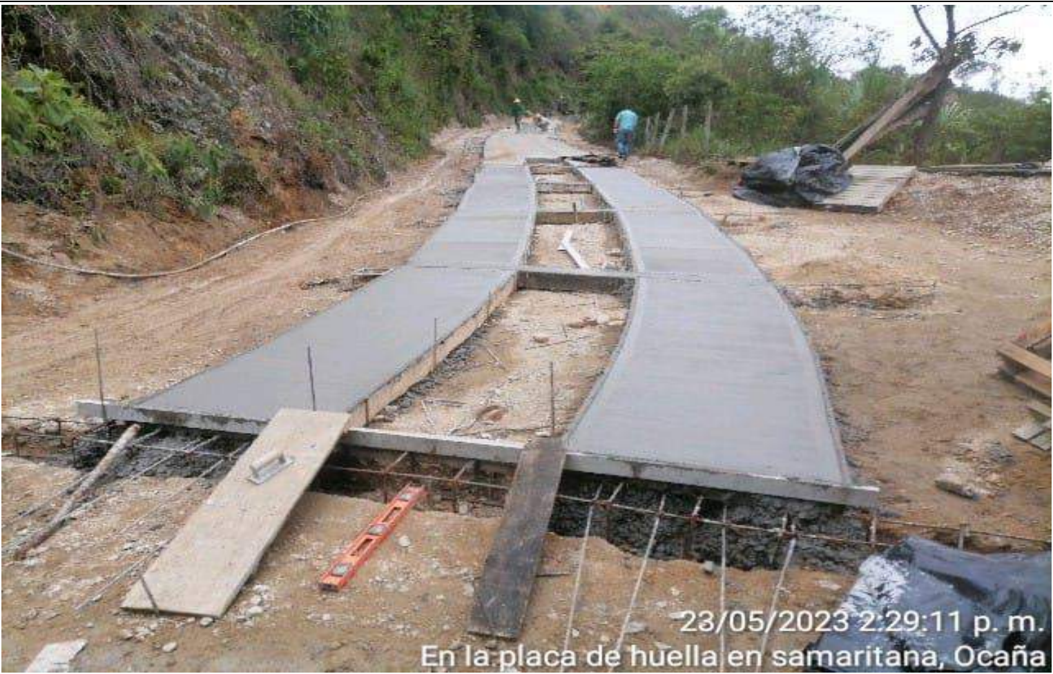
UBICACIÓN: LA SAMARITANA DESCRIPCIÓN DE ACTIVIDAD: FUNDIDA DE HUELLA Y VIGA RIOSTRA
