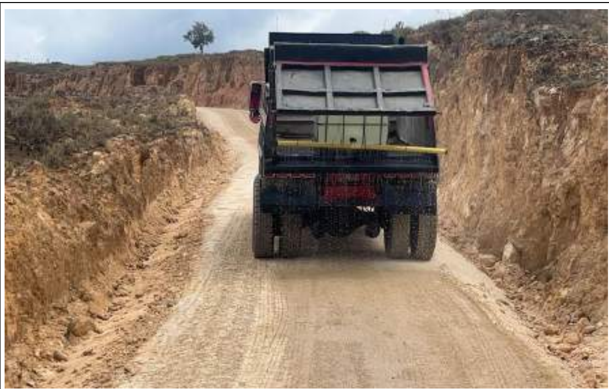
UBICACIÓN: ABREGO – CORREDOR 1 LA YEE DEL CHORRO DESCRIPCIÓN DE ACTIVIDAD: HIDRATACION A SUB-BASE
