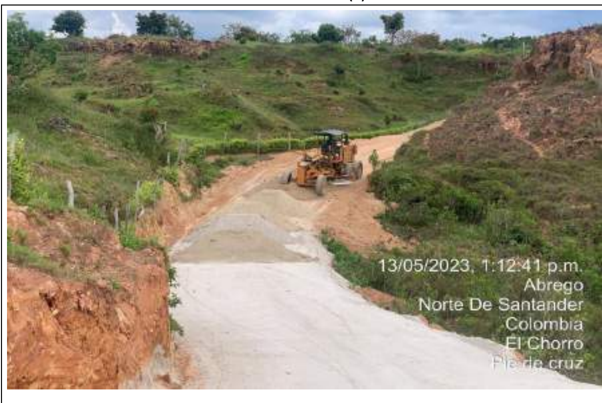
UBICACIÓN: ABREGO – CORREDOR 1 PIE DE CRUZ DESCRIPCIÓN DE ACTIVIDAD: INSTALACION DE SUB-BASE
