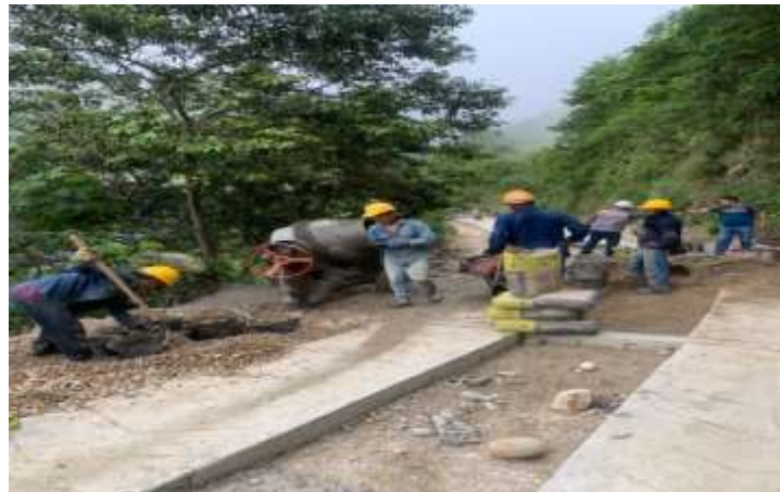
Manejo de herramientas y material de construcción.
