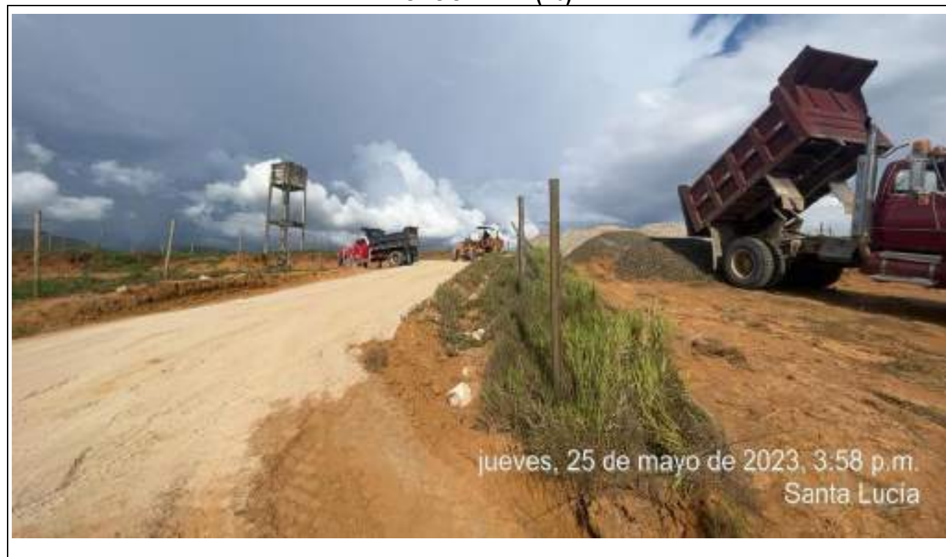
UBICACIÓN: ABREGO – CORREDOR 1 SANTA LUCIA DESCRIPCIÓN DE ACTIVIDAD: ACOPIO DE MATERIAL (TRITURADO)
