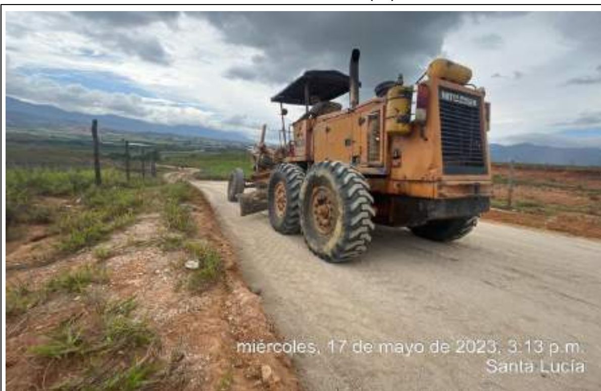
UBICACIÓN: ABREGO – CORREDOR 1 SANTA LUCIA DESCRIPCIÓN DE ACTIVIDAD: INSTALACION DE SUB BASE
