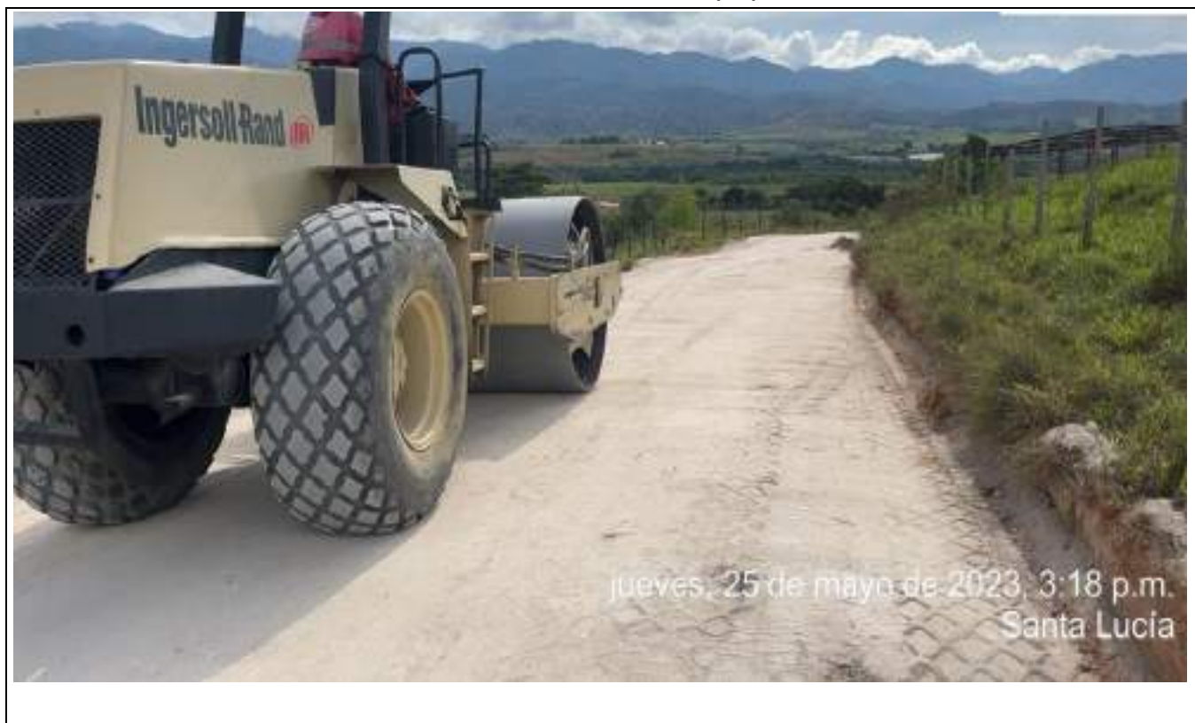
UBICACIÓN: ABREGO – CORREDOR 1 SANTA LUCÍA DESCRIPCIÓN DE ACTIVIDAD: COMPACTACION DE SUB BASE
