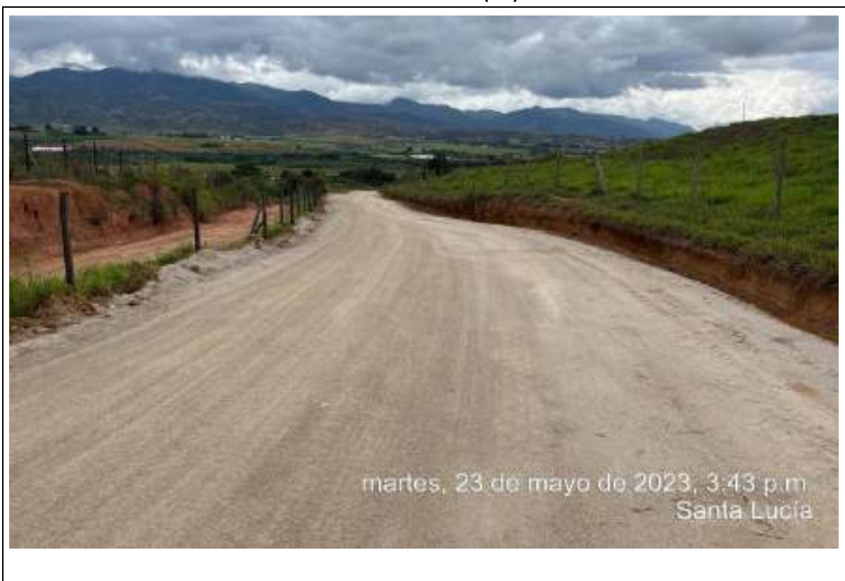
UBICACIÓN: ABREGO – CORREDOR 1 SANTA LUCIA DESCRIPCIÓN DE ACTIVIDAD: INSTALACION DE SUB BASE
