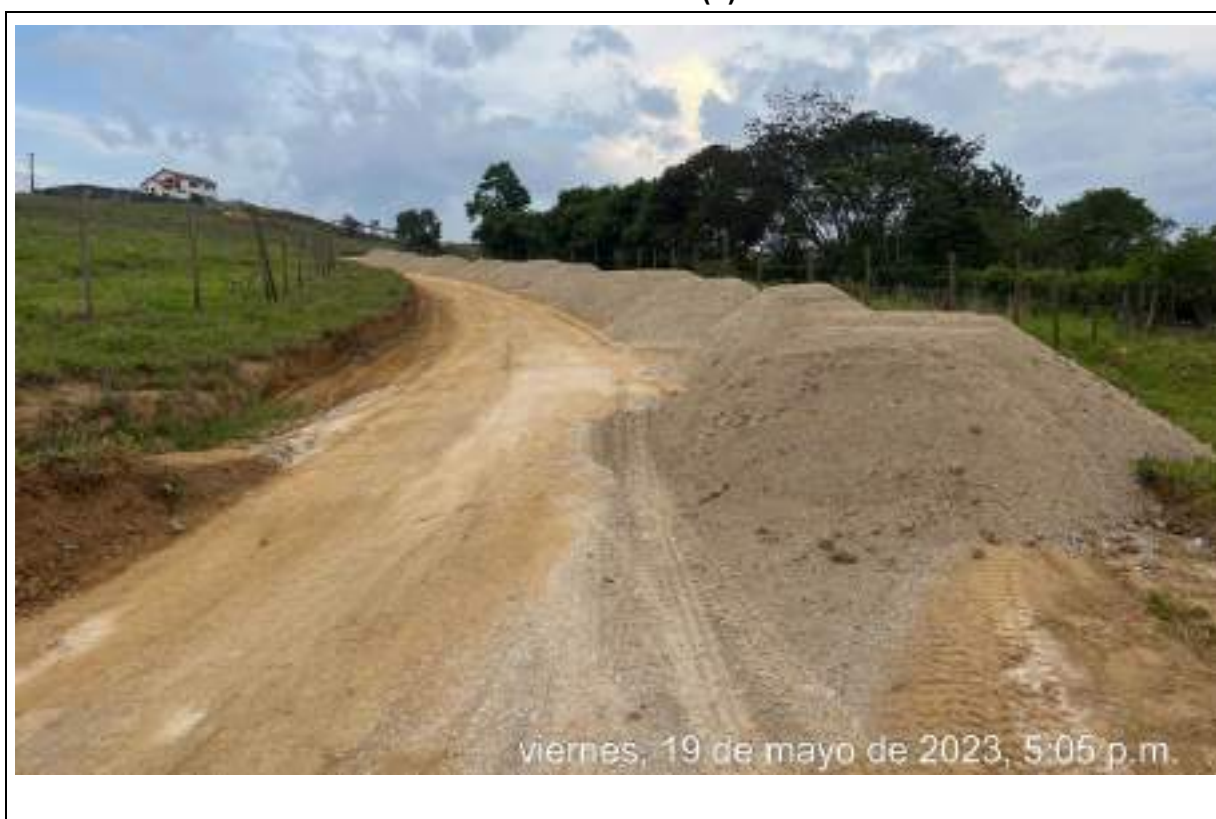
UBICACIÓN: ABREGO – CORREDOR 1 SANTA LUCIA DESCRIPCIÓN DE ACTIVIDAD: ACOPIO DE SUB-BASE
