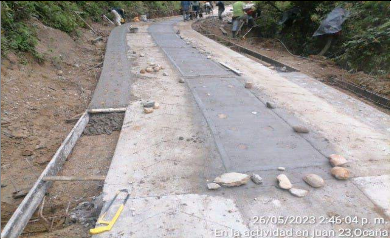
UBICACIÓN: LA SAMARITANA DESCRIPCIÓN DE ACTIVIDAD: FUNDIDA DE CONTRA HUELLA CENTRAL Y LATERAL
