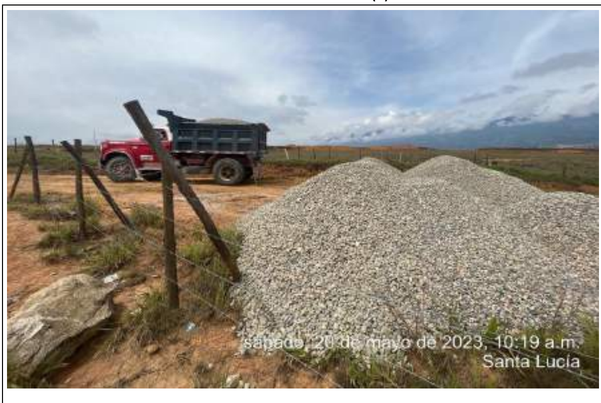
UBICACIÓN: ABREGO – CORREDOR 1 SANTA LUCIA DESCRIPCIÓN DE ACTIVIDAD: ACOPIO DE MATERIAL (TRITURADO)
