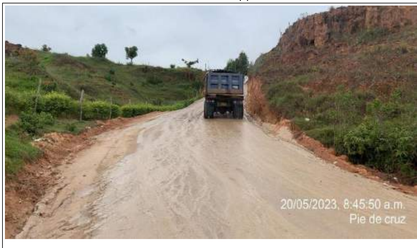
UBICACIÓN: ABREGO – CORREDOR 1 PIE DE CRUZ DESCRIPCIÓN DE ACTIVIDAD: IRRIGACION DE SUB BASE
