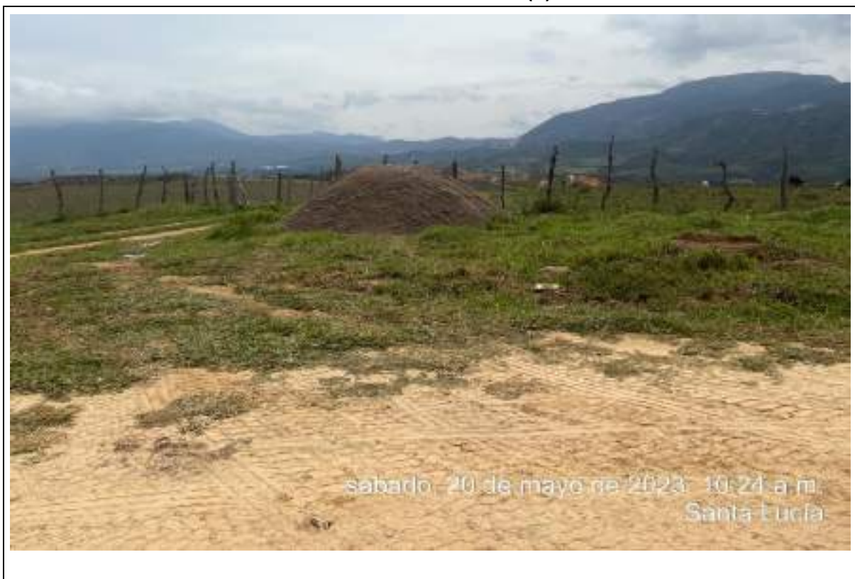
UBICACIÓN: ABREGO – CORREDOR 1 SANTA LUCIA DESCRIPCIÓN DE ACTIVIDAD: ACOPIO DE MATERIAL (ARENA)
