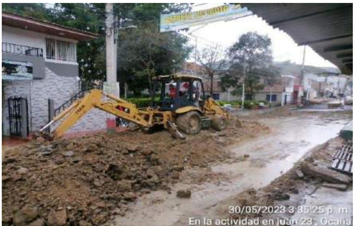
UBICACIÓN: BARRIO JUAN XXIII DESCRIPCIÓN DE ACTIVIDAD: EXCAVACION
