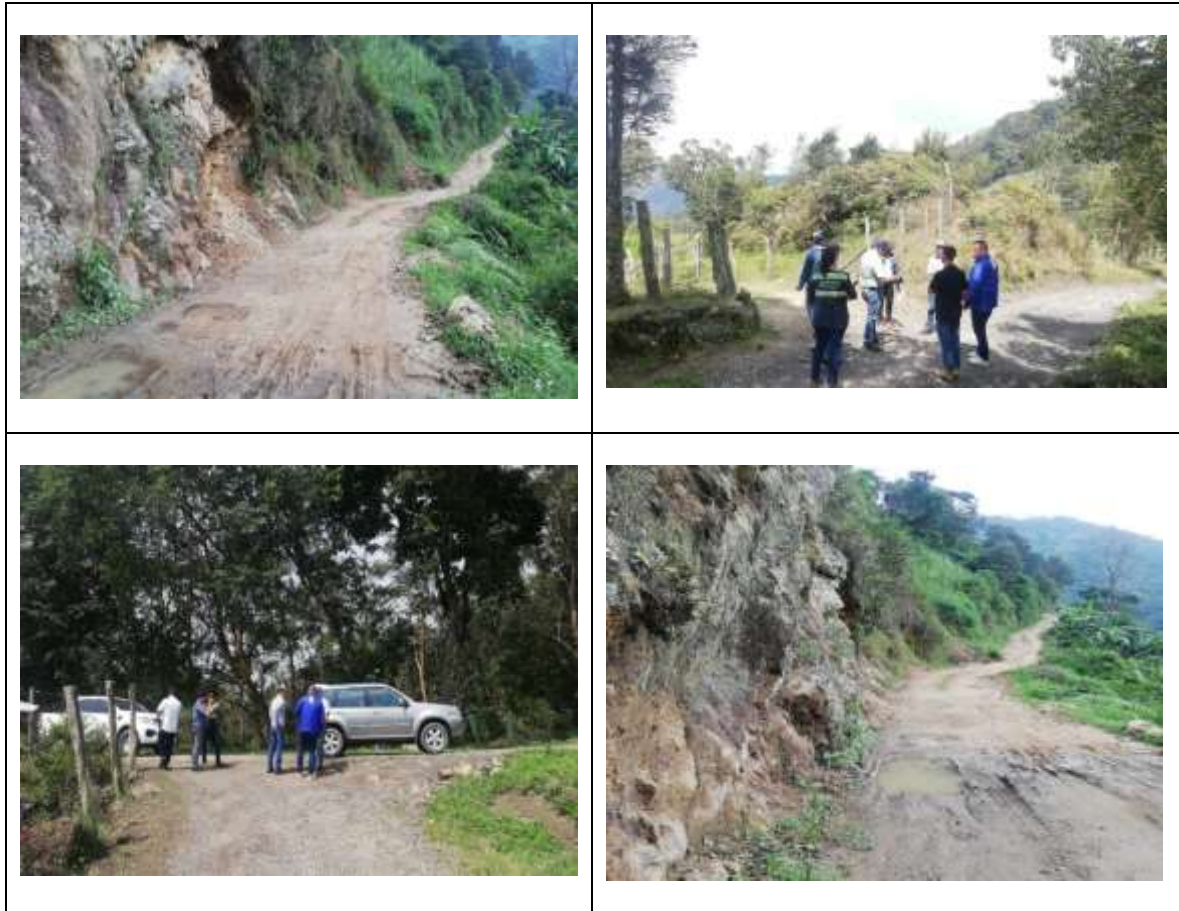
Fotografía 11 Estado actual del corredor vial a intervenir – Gobernación-1943- Gramalote
