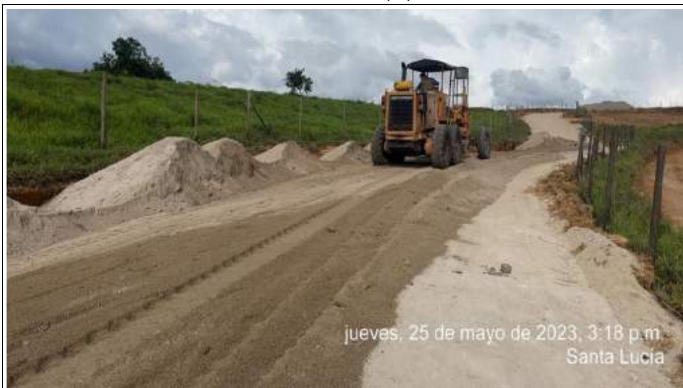
UBICACIÓN: ABREGO – CORREDOR 1 SANTA LUCIA DESCRIPCIÓN DE ACTIVIDAD: INSTALACION DE SUB BASE
