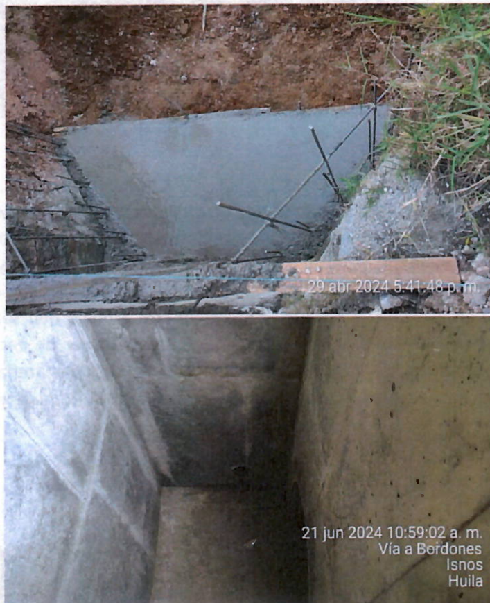
Ilustración 33 Concreto clase D para muros en drenaje transversal de tramo 2
