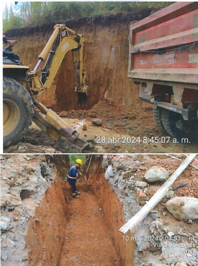
Ilustración 28 Excavación de material común seco en alcantarilla tramo 2
