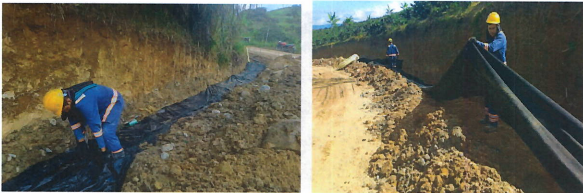
Ilustración 56 Instalación de geotextil para filtro en tramo 3
