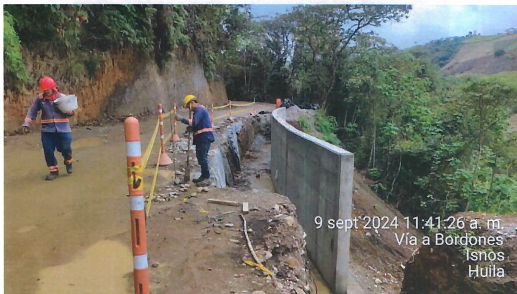
Ilustración 43 Concreto clase D para muros
