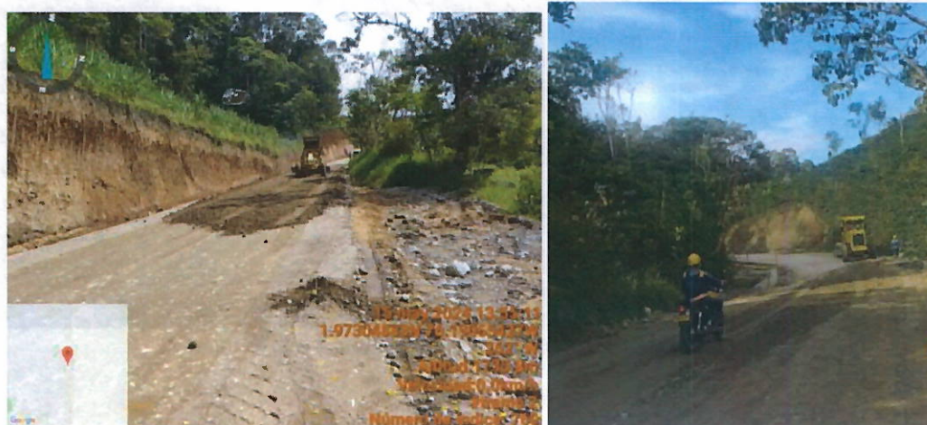
Ilustración 25 Instalación de subbase granular en tramo 2
