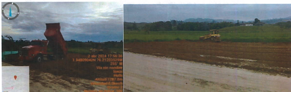
Ilustración 22 Conformación y renivelación en el zodme
