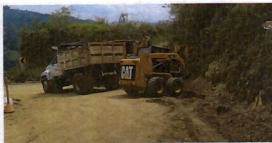
Ilustración 9 Excavación de material común seco en tramo 1
