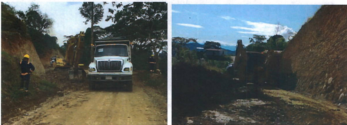
Ilustración 47 Transporte de material en volquetas en tramo 3
