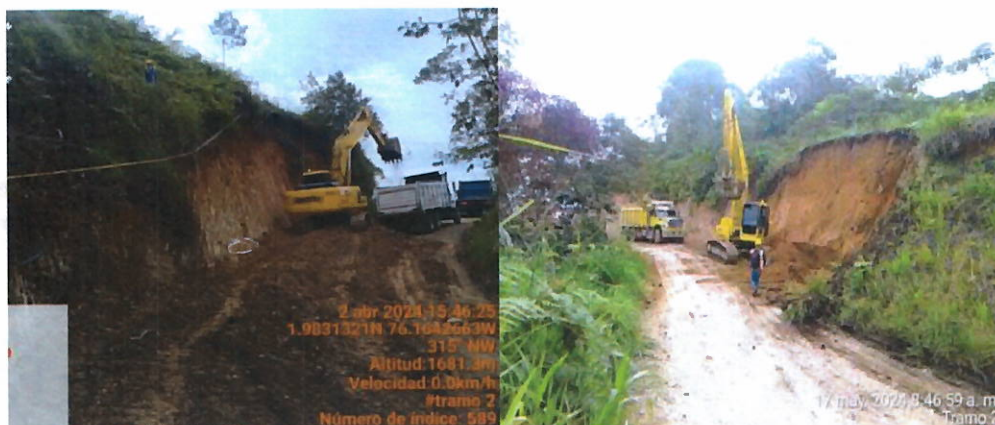
Ilustración 17 Excavación de taludes para explanación en tramo 2
