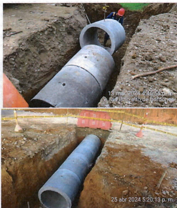
Ilustración 30 Colocación de tubería de concreto reforzado de 900mm en tramo 2
