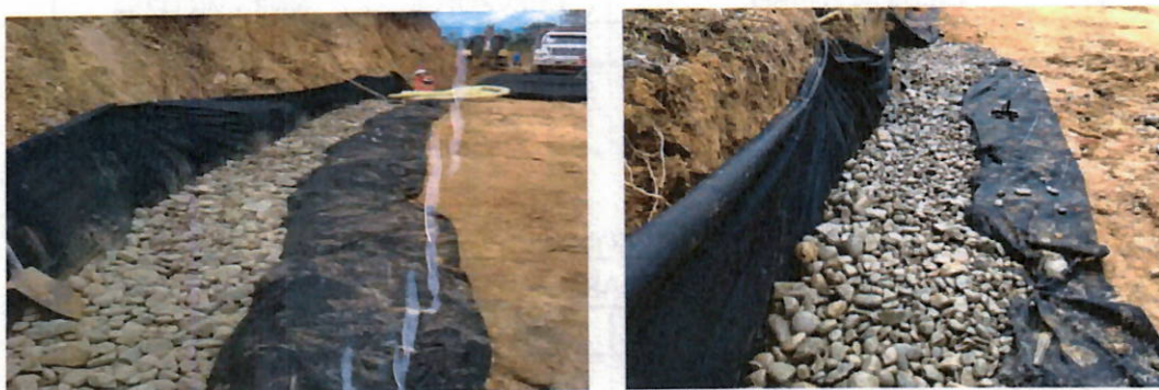
Ilustración 57 Instalación de material granular drenante en tramo 3
