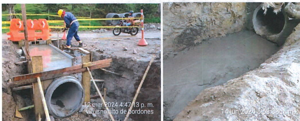
Ilustración 31 Concreto simple para atraque de tubería en tramo 2.
