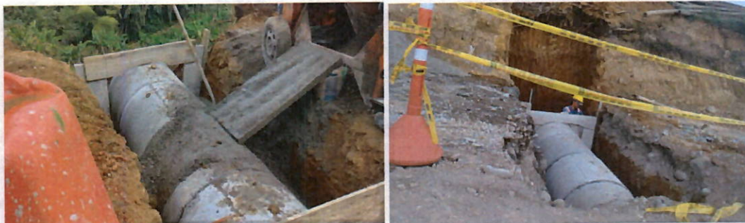
Ilustración 53 Colocación de tubería de concreto reforzado de 900mm en tramo 3
