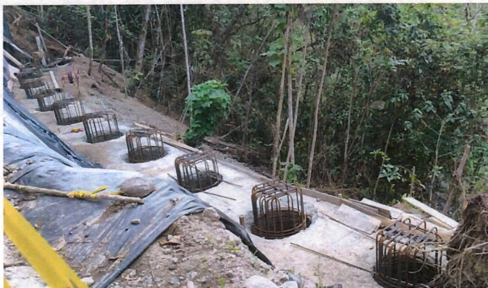
Ilustración 42. Pilote en tramo 2
