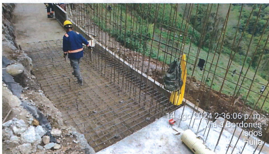
Ilustración 44 Acero de refuerzo para muros
