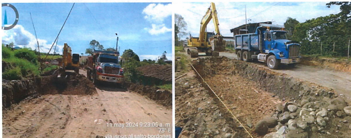
Ilustración 18 Excavación de banca en tramo 2
