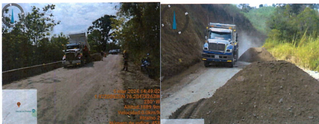
Ilustración 27 Transporte de subbase granular en tramo 2
