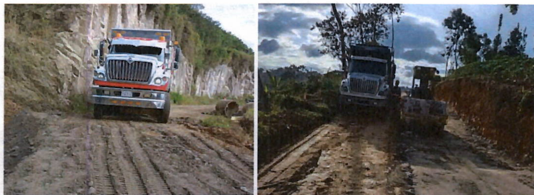
Ilustración 50 Transporte de material de mejoramiento en tramo 3
