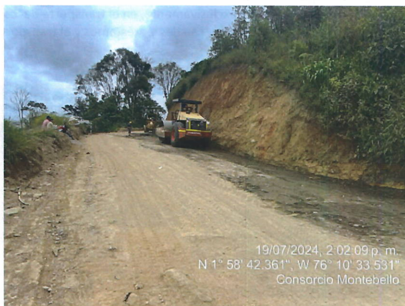
Ilustración 26 Protección de filtros con subbase granular
