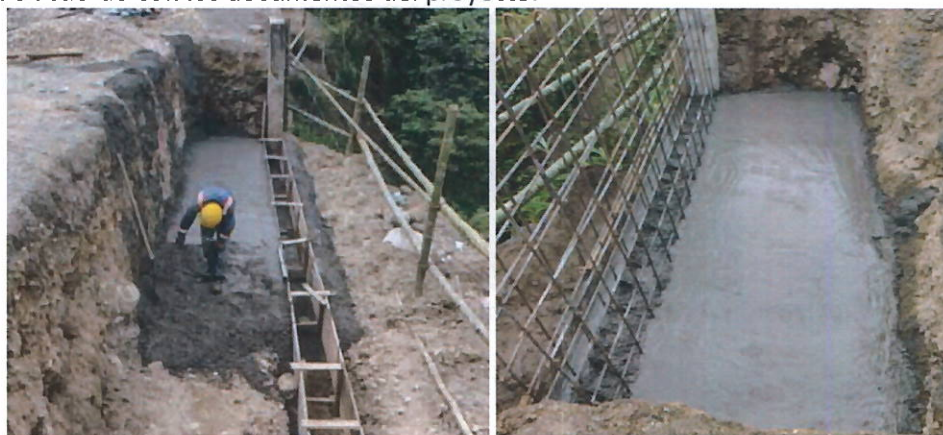
Ilustración 11 Instalación de concreto clase F para solado en tramo 1
