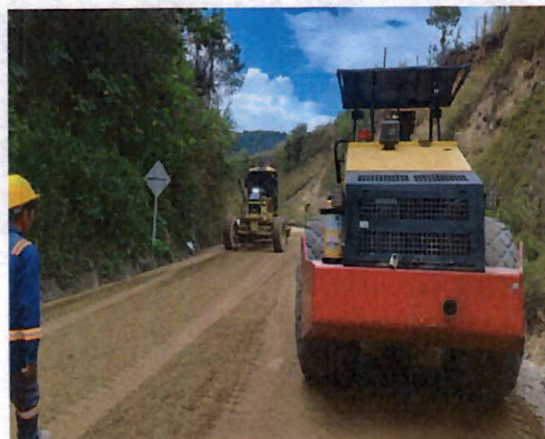
Ilustración 5 Instalación de base granular tramo 1
