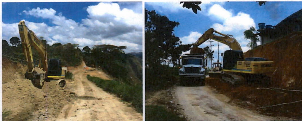
Ilustración 46 Excavación de taludes para explanación en tramo 3
