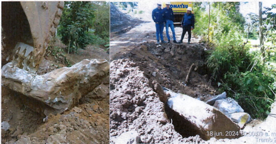
Ilustración 16 Demolición de alcantarilla en tramo 2
