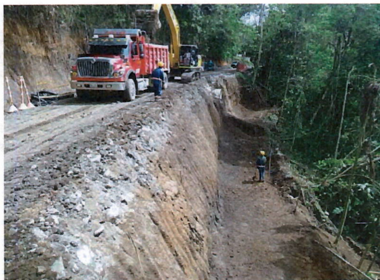
Ilustración 39 Instalación de material granular filtrante en tramo 2
