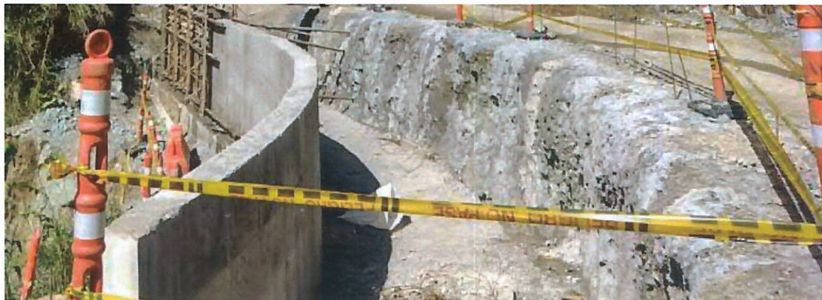
Ilustración 10 Relleno de estructuras con material seleccionado en tramo 1
