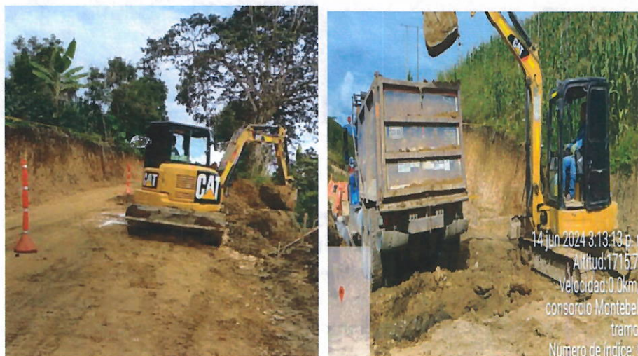
Ilustración 51 Conformación y renivelación en el zodme
