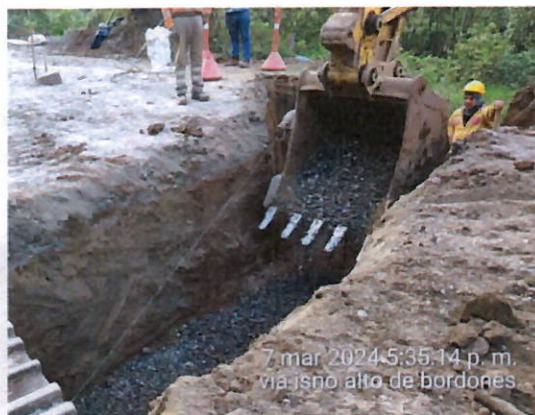
Ilustración 29 Material granular filtrante en alcantarillas tramo 2
