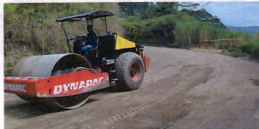
Ilustración 4. Instalación de subbase granular tramo 1
