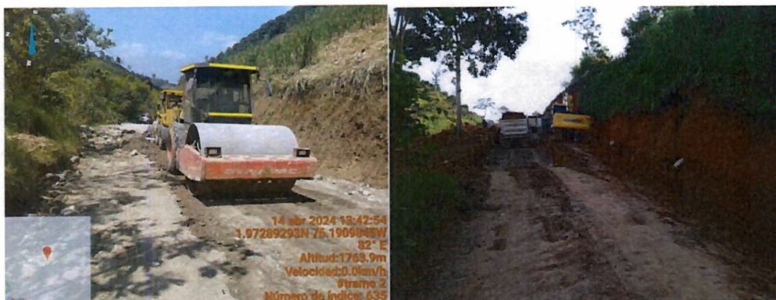
Ilustración 23 Instalación de material de mejoramiento en tramo 2
