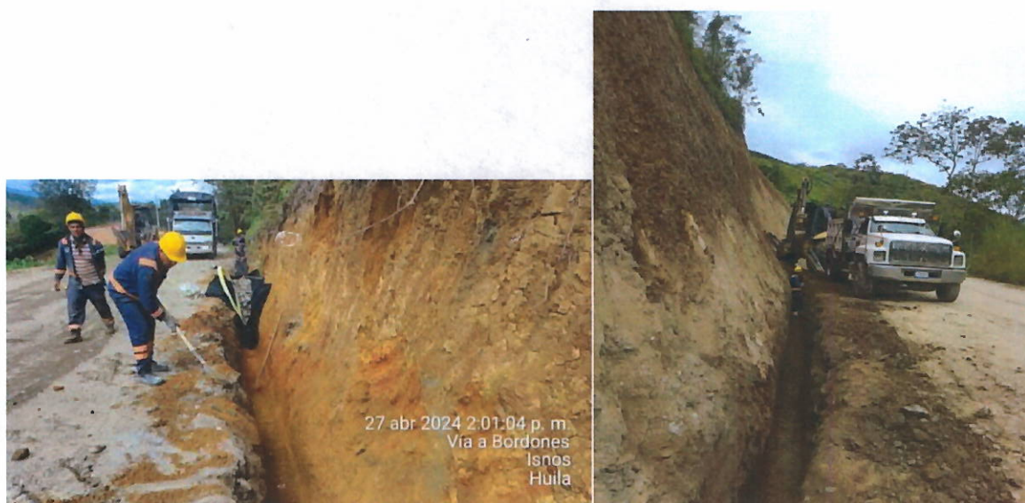
Ilustración 35 Excavación de material común seco en el tramo 2
