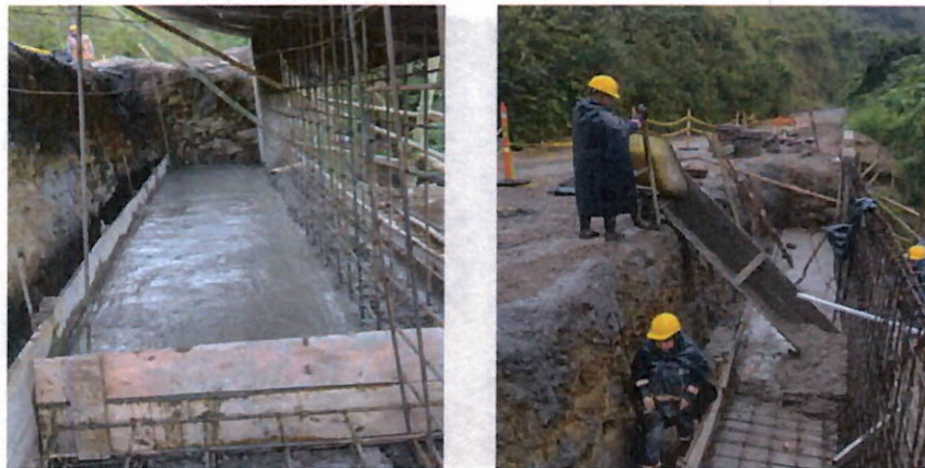
Ilustración 12 Instalación de concreto clase D para muros en tramo 1
