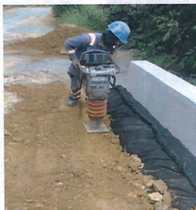
Ilustración 14 Instalación de geotextil no tejido 2400
