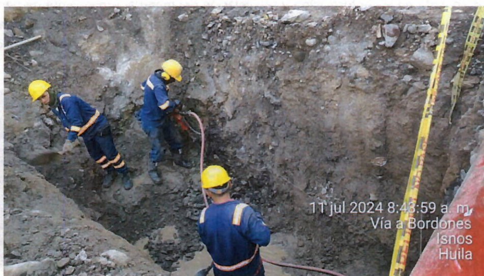
Ilustración 20. Excavación en roca para obras transversales
