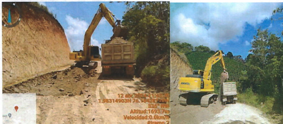
Ilustración 21 Cargue de material en volquetas para su transporte.
