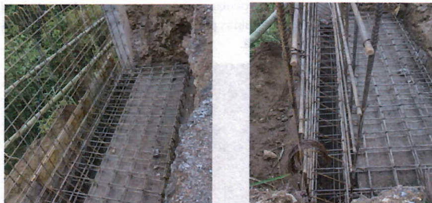
Ilustración 13 Instalación de acero de refuerzo en el tramo 1
