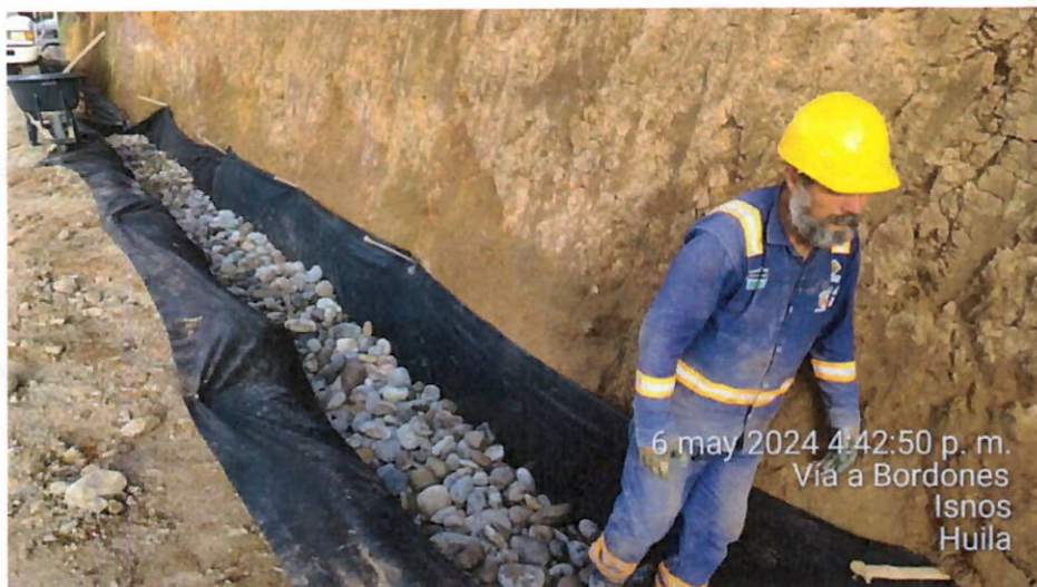
Ilustración 38 Instalación de material granular filtrante en tramo 2
