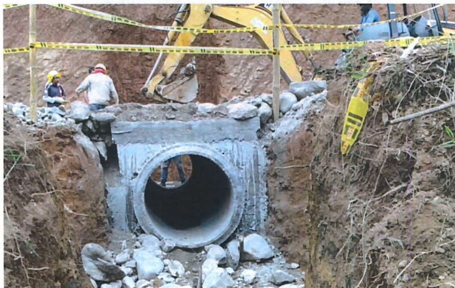
Ilustración 32 Relleno de estructuras de drenaje en tramo 2.
