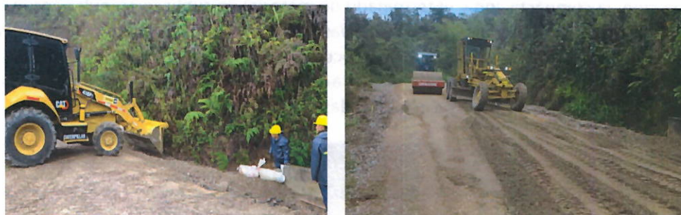
Ilustración 6 Instalación de mejoramiento para cunetas y mejoramiento de subrasante tramo 1
