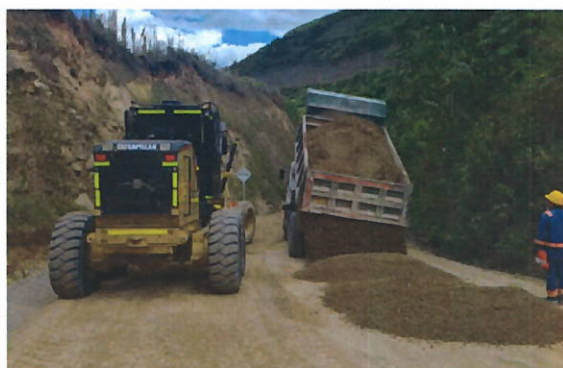
Ilustración 7 Transporte de base granular en tramo 1
