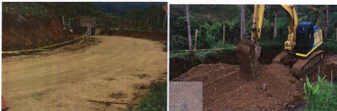
Ilustración 49 instalación de material de mejoramiento en tramo 3
