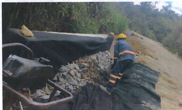
Ilustración 15 Instalación de geotextil no tejido 2400
