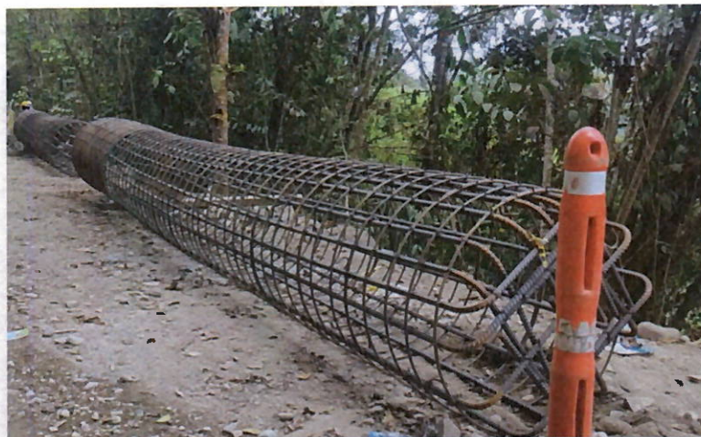
Ilustración 41 Construcción de pilotes en tramo 2
