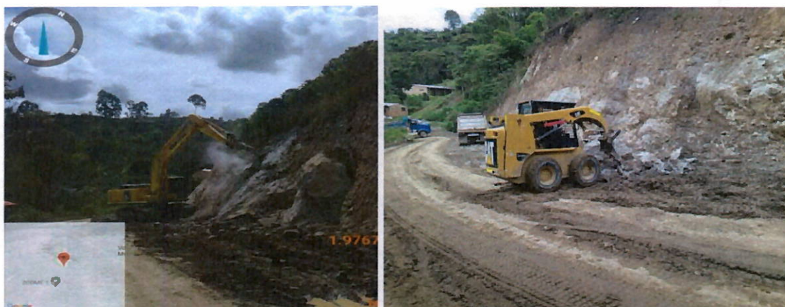
Ilustración 19 Excavación de roca
