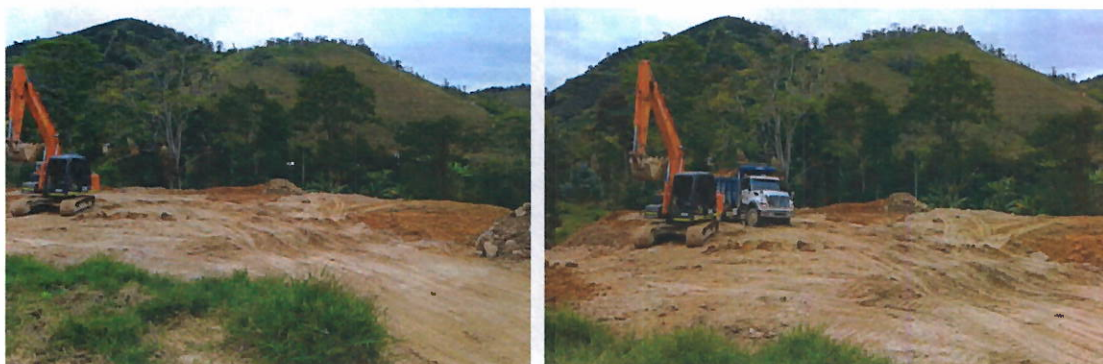
Ilustración 48 Conformación y renivelación en el zodme
