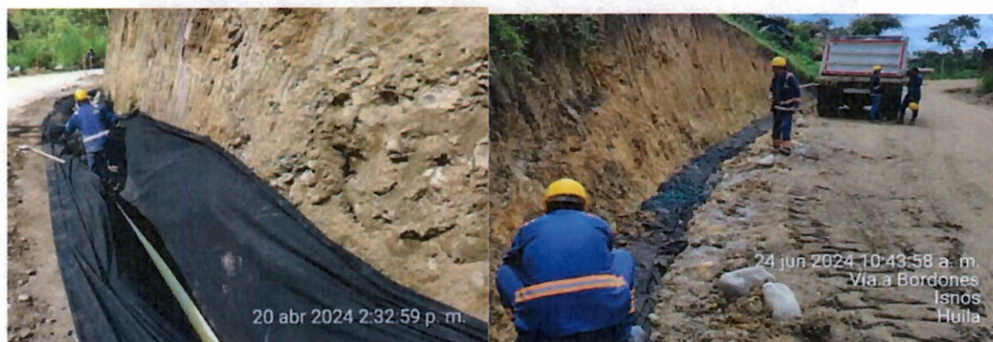
Ilustración 34. Instalación de geotextil para filtro en tramo 2
