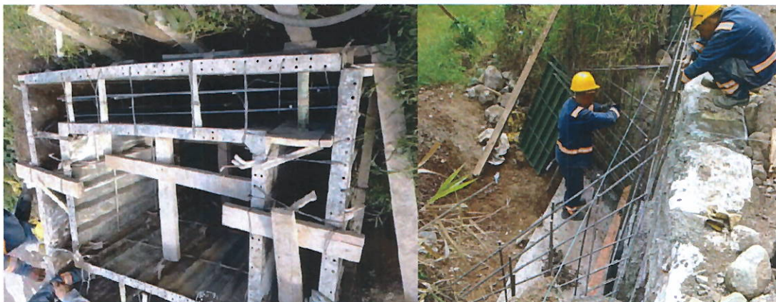
Ilustración 34 Acero de refuerzo en drenaje transversal de tramo 2
