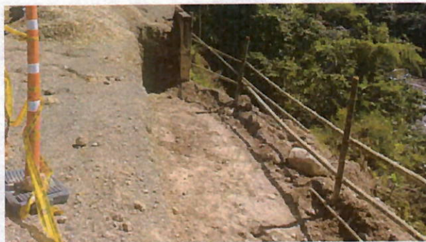
Ilustración 8 Excavación de material común seco en tramo 1
