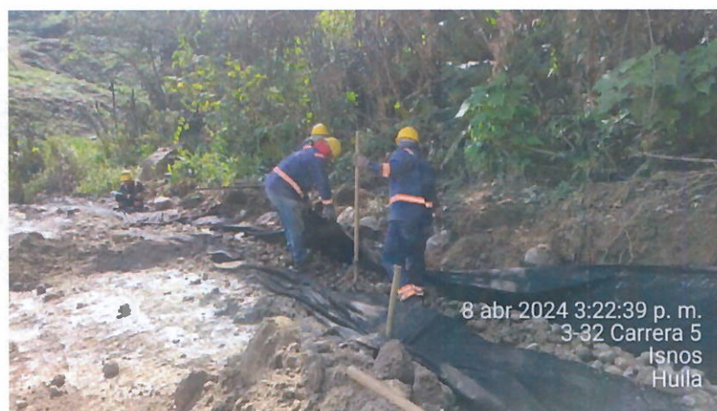
Ilustración 37 Instalación de material granular drenante en tramo 2
