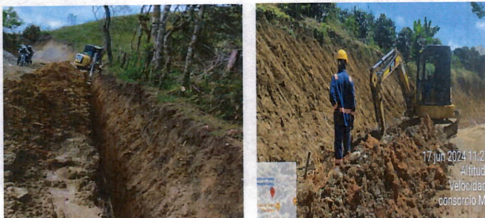
Ilustración 54 Excavación de material común seco en el tramo 3
