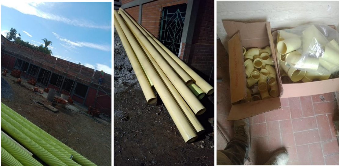
Foto 1. Acopio y almacenamiento de materiales en obra.
