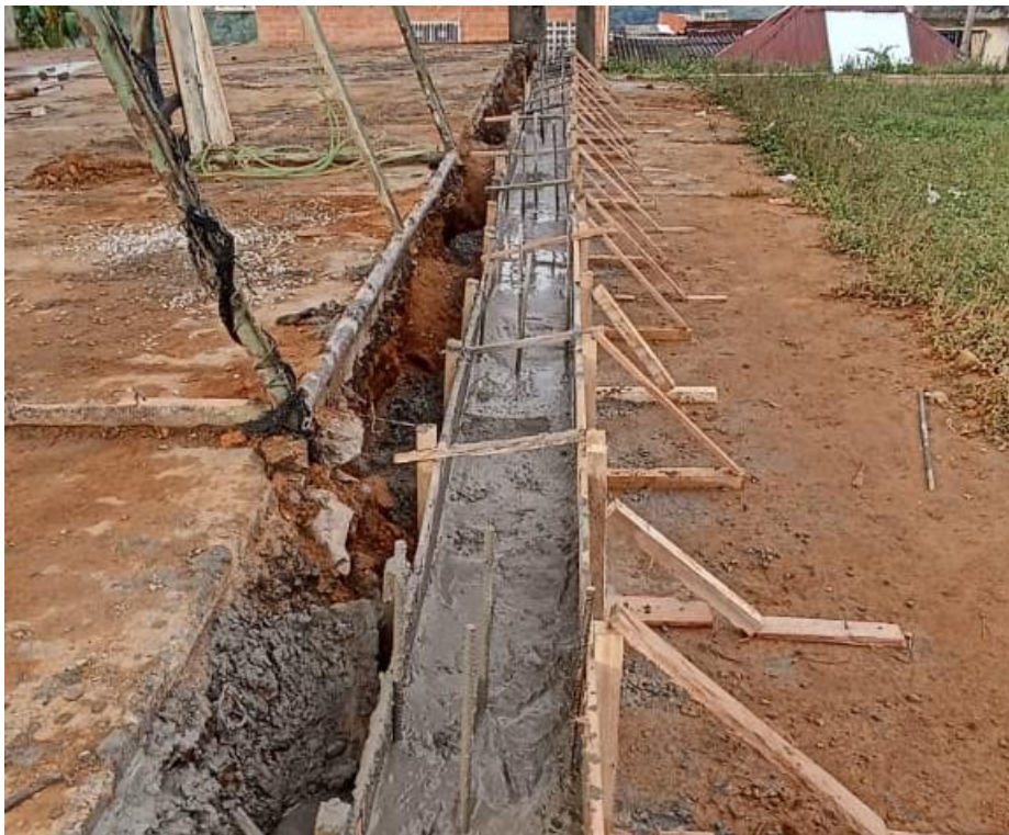
Vaciado de viga de fundación
