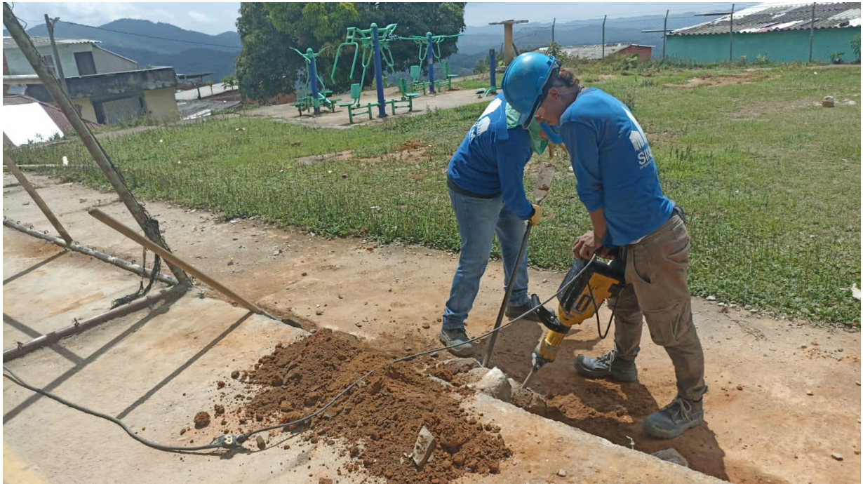
Demolición de viga existente
