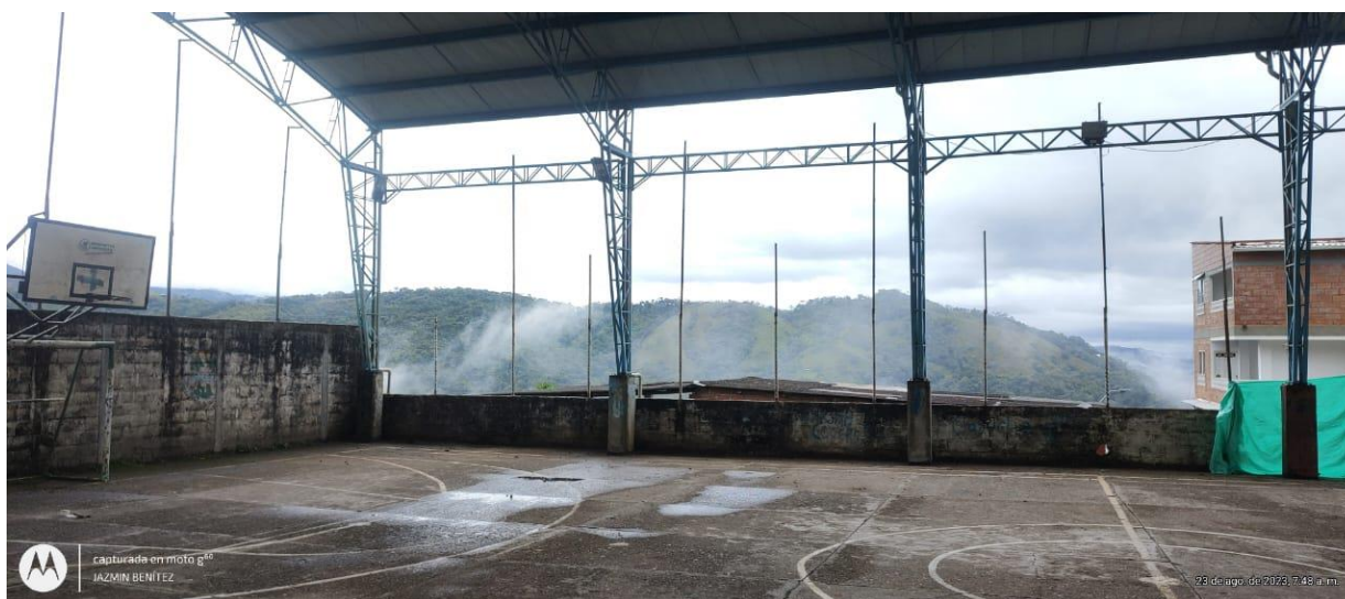
Retiro de maya eslabonada existente
