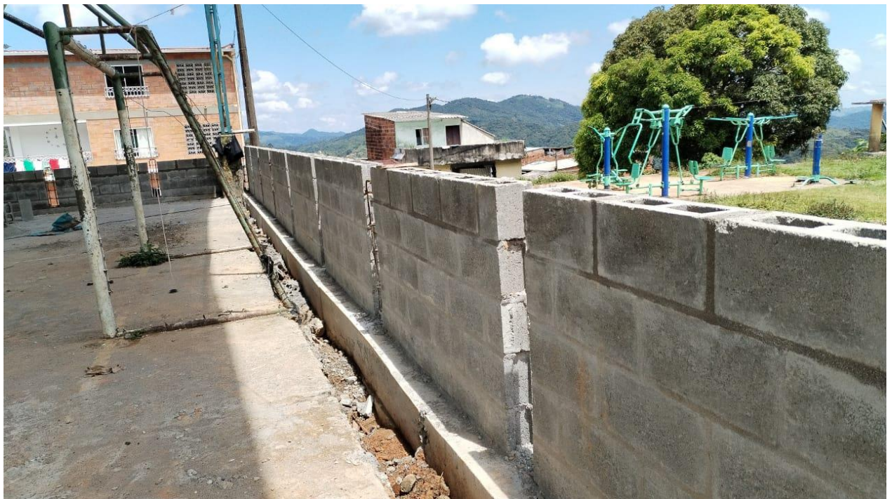
Construcción de cerramiento en mampostería
