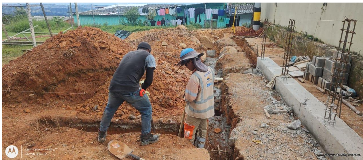
Excavación de brechas y construcción de vigas de la rampa
