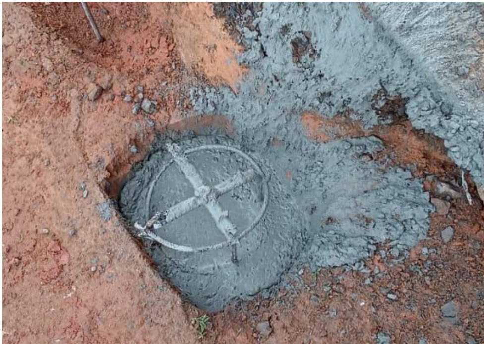
Construcción de micropilotes
