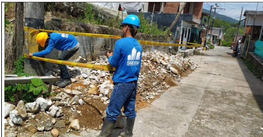
Fotografía 5: Señalización y Almacenamiento de material de demolición en obra
