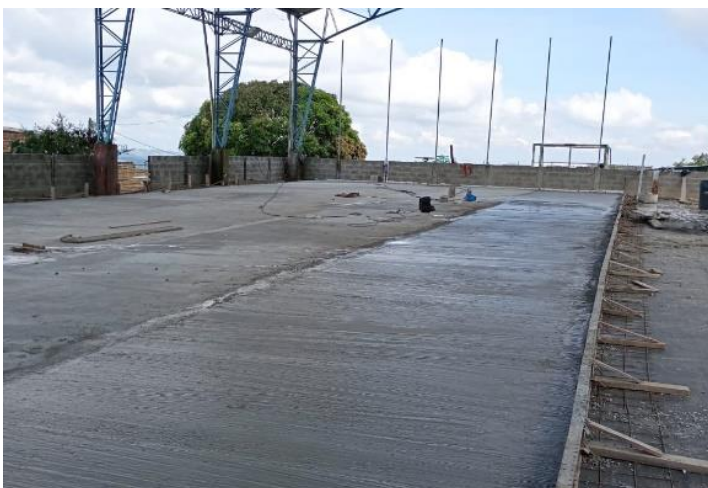
Fotografías 2, 3, 4 y 5: Construcción de losa de piso.
