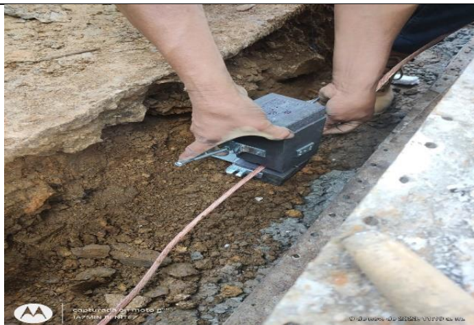
Fotografía 6: Construcción de apantallamiento eléctrico
