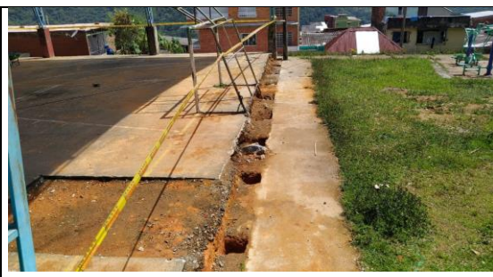
Fotografía 12: Señalización en obra
