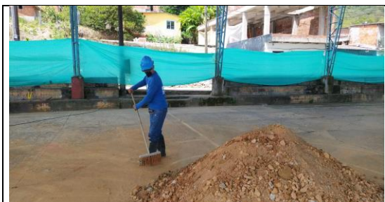
Fotografía 7: Aseo interno en la obra
