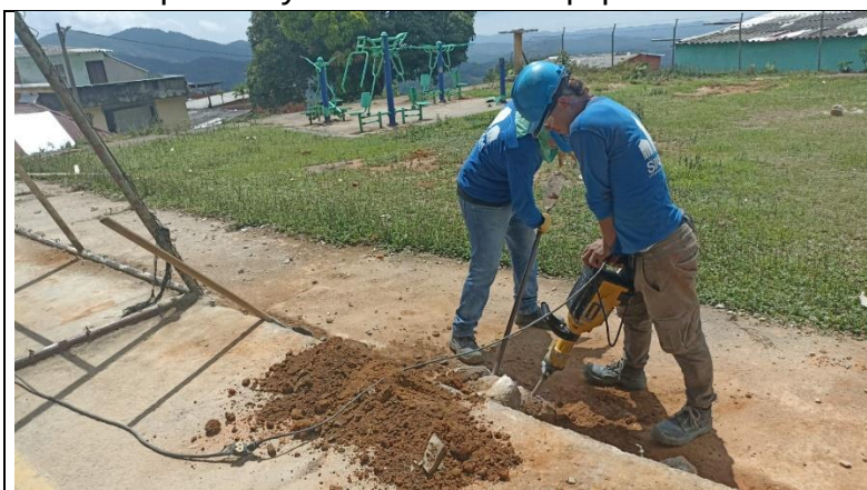
Fotografía 8: Manejo de equipos en obra.
