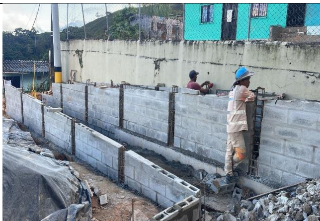
Fotografía 7: Construcción de mampostería para rampa.
