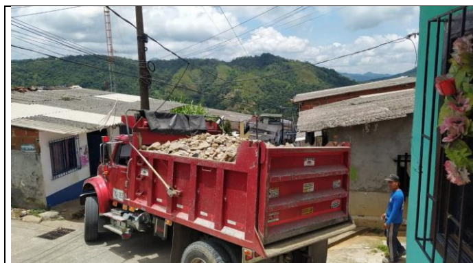
Fotografía 3: Transporte, manejo y disposición final de material sobrante.
