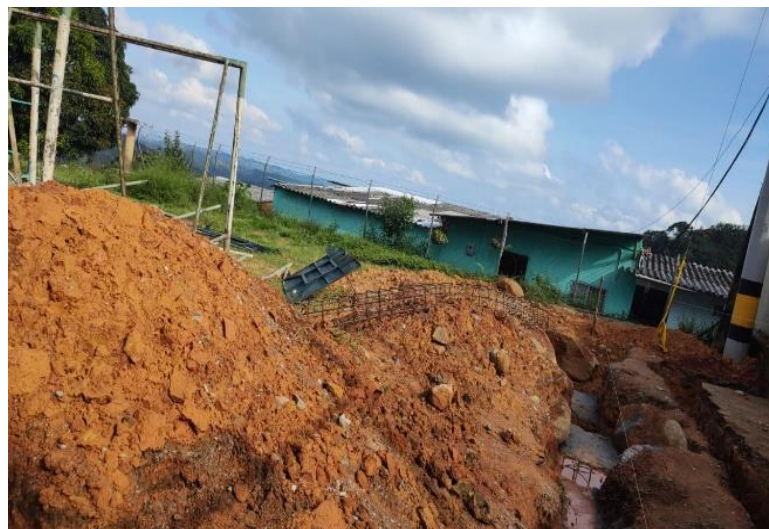
Fotografías 1 y 2: Instalación de cerramiento en bloque con malla eslabonada y construcción de rampa de acceso.
