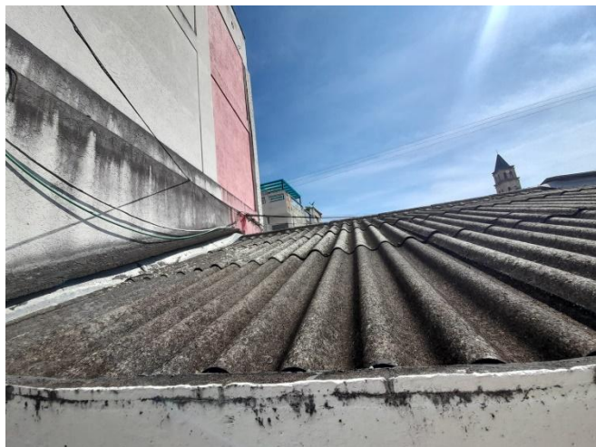
Fotografía No. 37. Visita de Inspección y reconocimiento del frente de obra.
