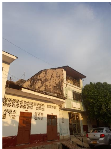
Fotografía No. 10. Visita de Inspección y reconocimiento del frente de obra.
