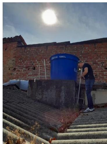
Fotografía No. 36. Visita de Inspección y reconocimiento del frente de obra.
