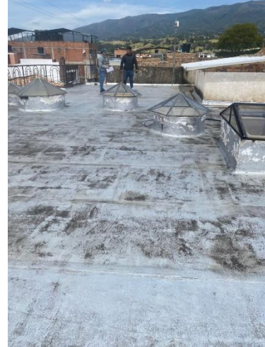
Fotografía No. 20. Visita de Inspección y reconocimiento del frente de obra.
