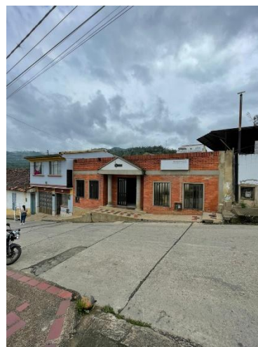
Fotografía No. 26. Visita de Inspección y reconocimiento del frente de obra.
