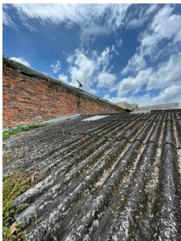
Fotografía No. 25. Visita de Inspección y reconocimiento del frente de obra.
