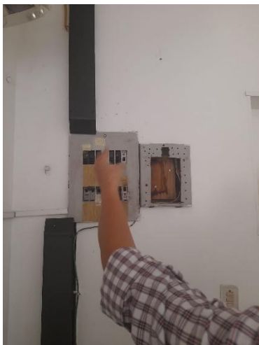
Fotografía No. 11. Visita de Inspección y reconocimiento del frente de obra.
