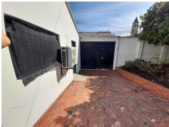
Fotografía No. 34. Visita de Inspección y reconocimiento del frente de obra.
