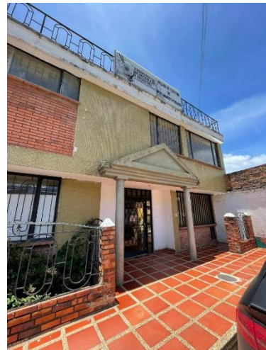
Fotografía No. 22. Visita de Inspección y reconocimiento del frente de obra.
