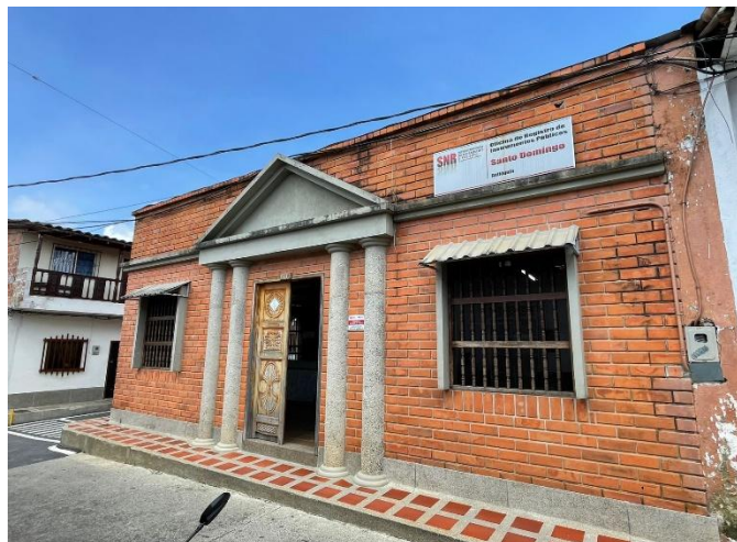
Fotografía No. 45. Visita de Inspección y reconocimiento del frente de obra.
