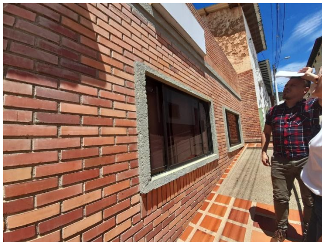
Fotografía No. 27. Visita de Inspección y reconocimiento del frente de obra.
