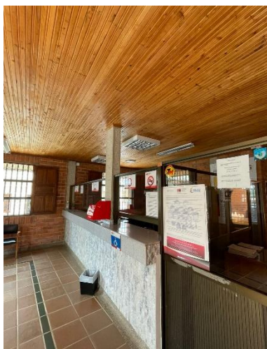
Fotografía No. 47. Visita de Inspección y reconocimiento del frente de obra.
