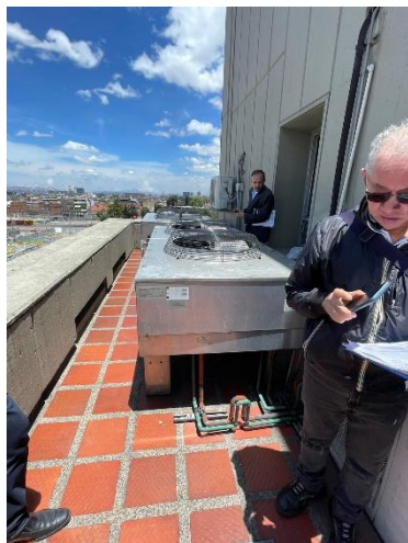
Fotografía No. 1. Visita de Inspección y reconocimiento del frente de obra.
