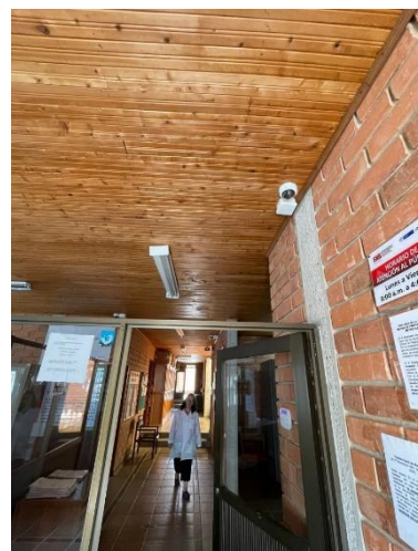
Fotografía No. 48. Visita de Inspección y reconocimiento del frente de obra.
