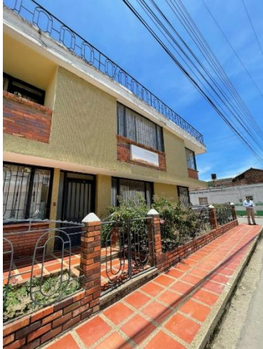
Fotografía No. 19. Visita de Inspección y reconocimiento del frente de obra.
