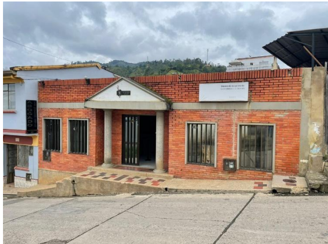
Fotografía No. 23. Visita de Inspección y reconocimiento del frente de obra.
