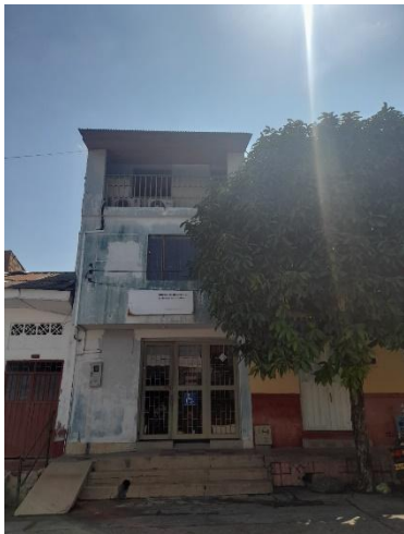
Fotografía No. 7. Visita de Inspección y reconocimiento del frente de obra.
