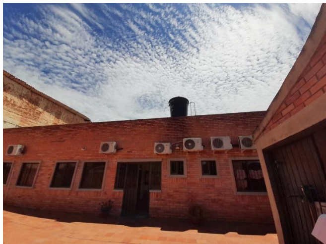
Fotografía No. 31. Visita de Inspección y reconocimiento del frente de obra.
