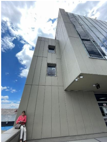
Fotografía No. 3. Visita de Inspección y reconocimiento del frente de obra.
