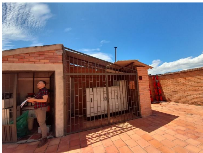
Fotografía No. 30. Visita de Inspección y reconocimiento del frente de obra.
