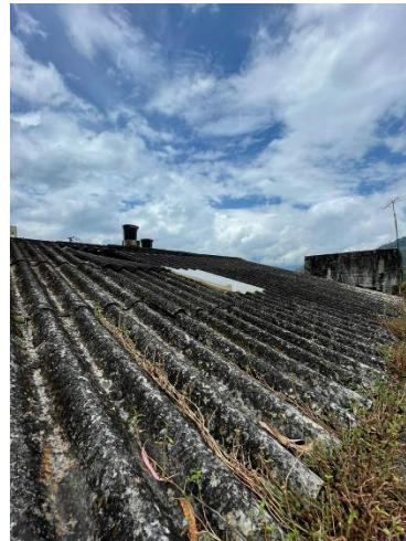
Fotografía No. 24. Visita de Inspección y reconocimiento del frente de obra.
