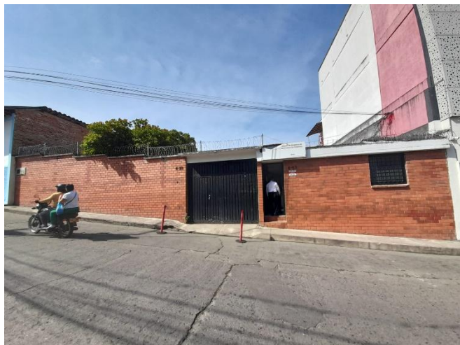
Fotografía No. 33. Visita de Inspección y reconocimiento del frente de obra.
