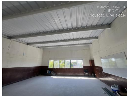
Supervisión IED Olaya
