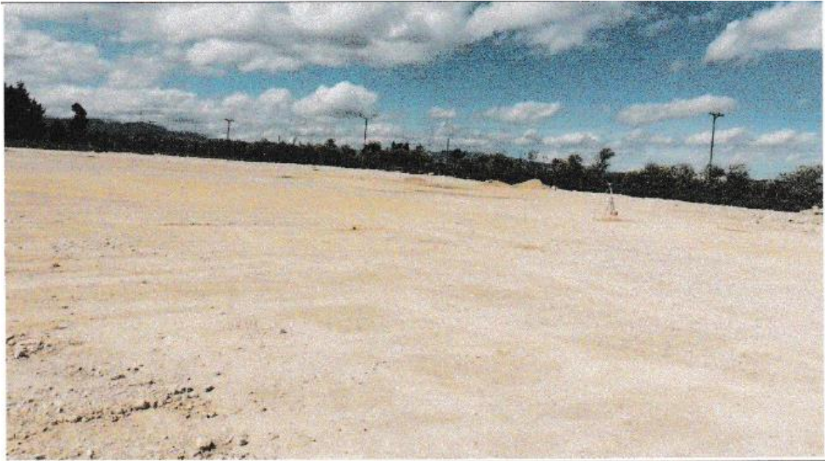
Replanteo de pilotes
