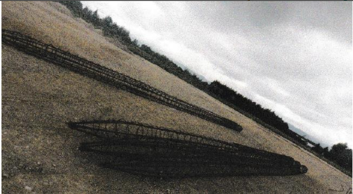
Armado de canastas de pilotes
