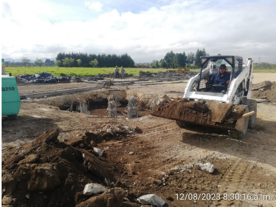
Excavación de dados eje H
