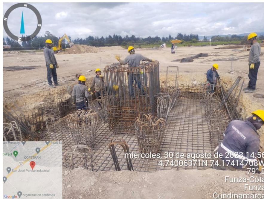
Armado acero pedestales eje H
