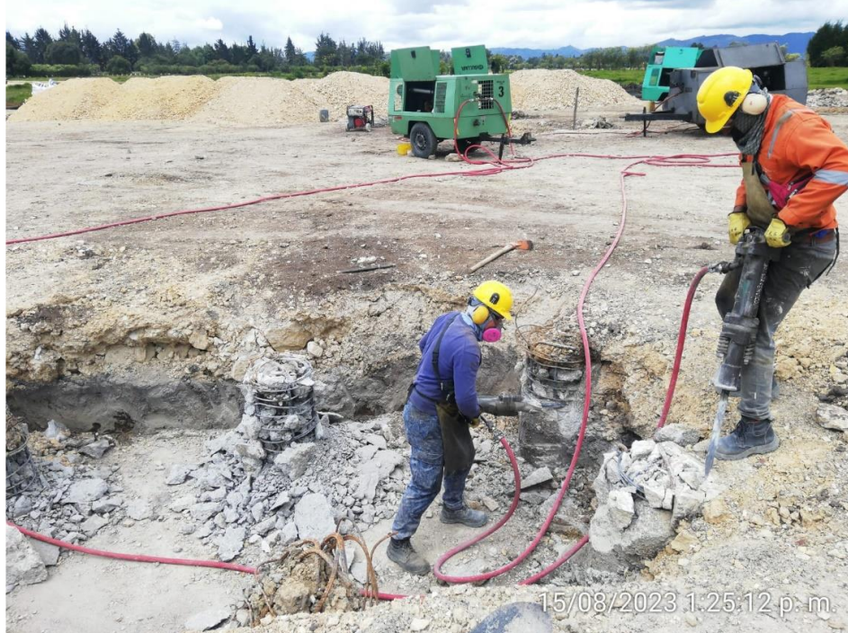
Descabece de pilotes eje H
