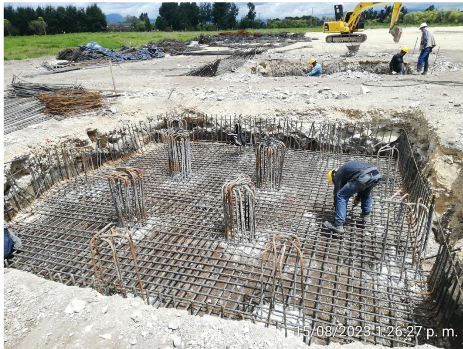
Armado acero dados eje H
