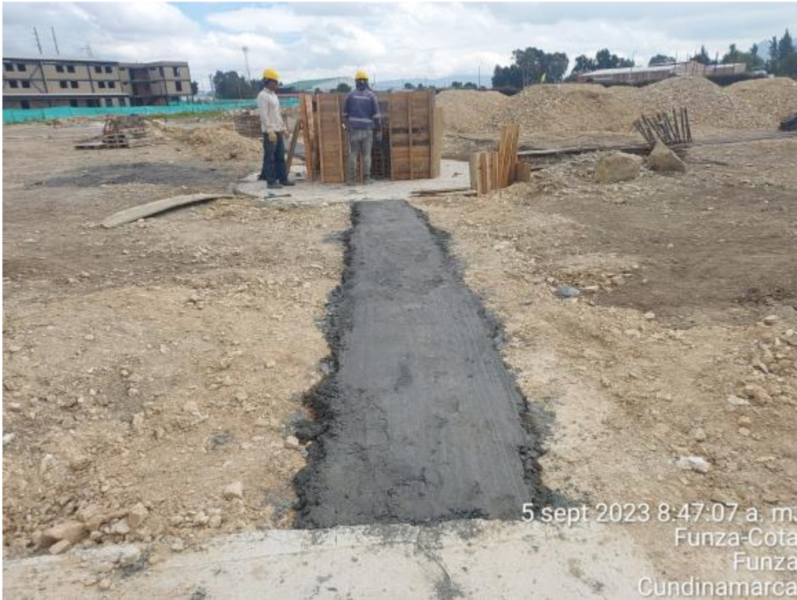
Solado de limpieza vigas de cimentación cubierta
