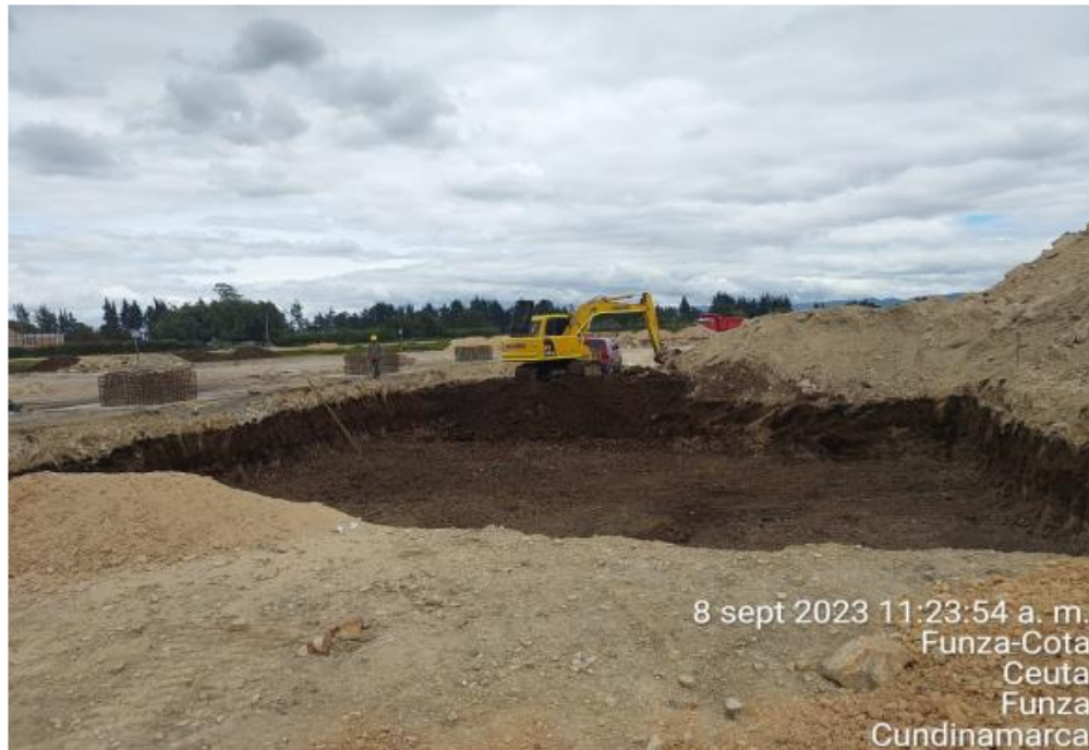
Excavación a máquina sin clasificar en zona de gradería 4
