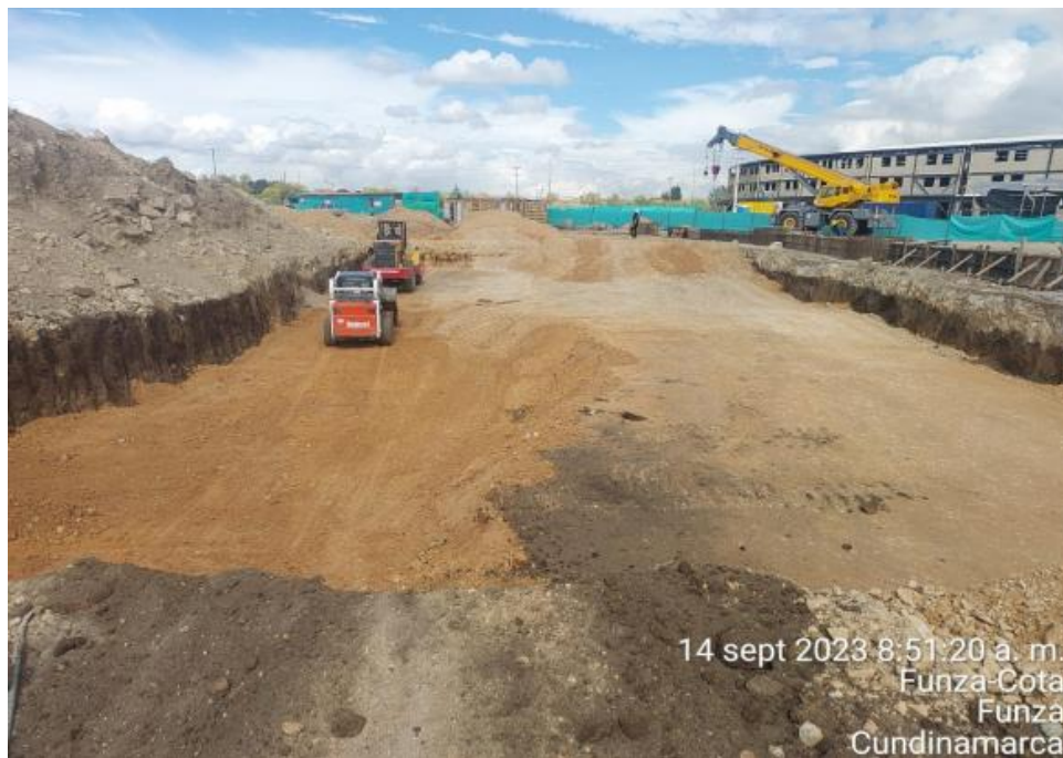
Compactación en recebo común zona de gradería 4
