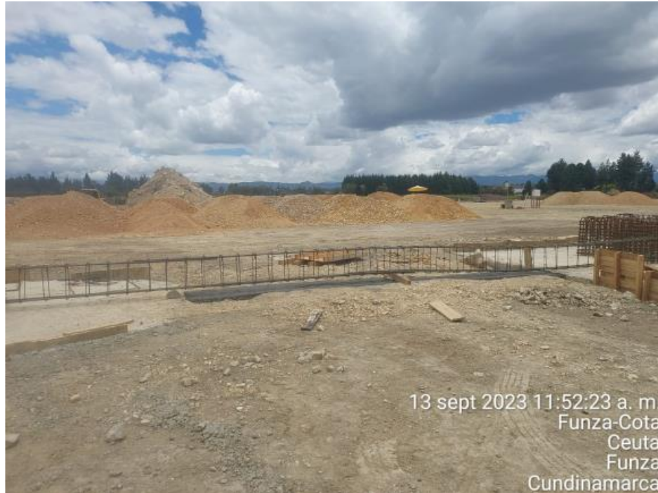
Amarre de acero de vigas de cimentación cubierta
