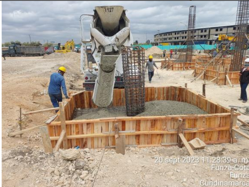
Fundición de zapatas gradería 4
