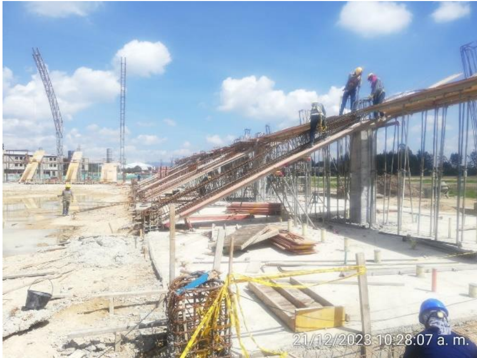
Armado de vigas principales gradería 1
