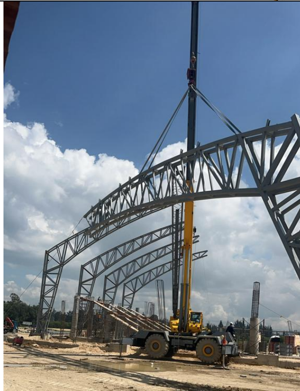
Izaje de columnas metálicas
