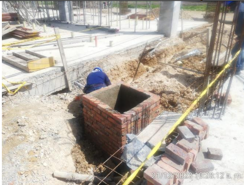
Construcción cajas de inspección
