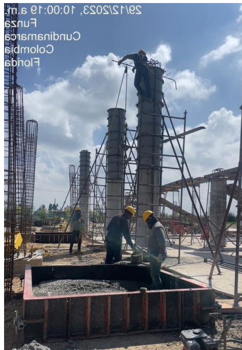
Fundidas columnas redondas
