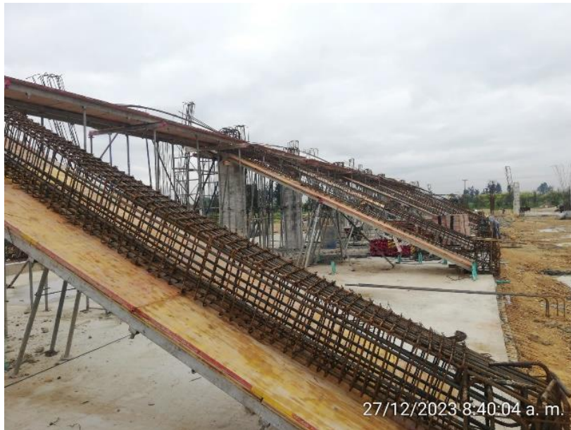
Armado de vigas principales gradería 1
