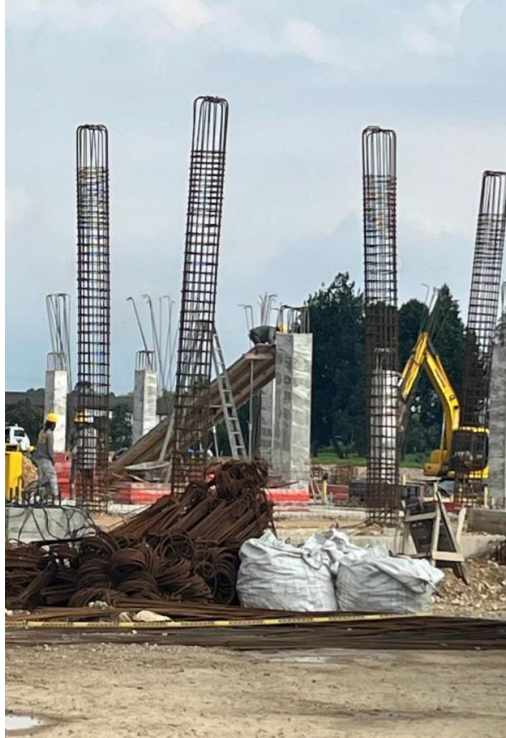
Armado acero de columnas redondas
