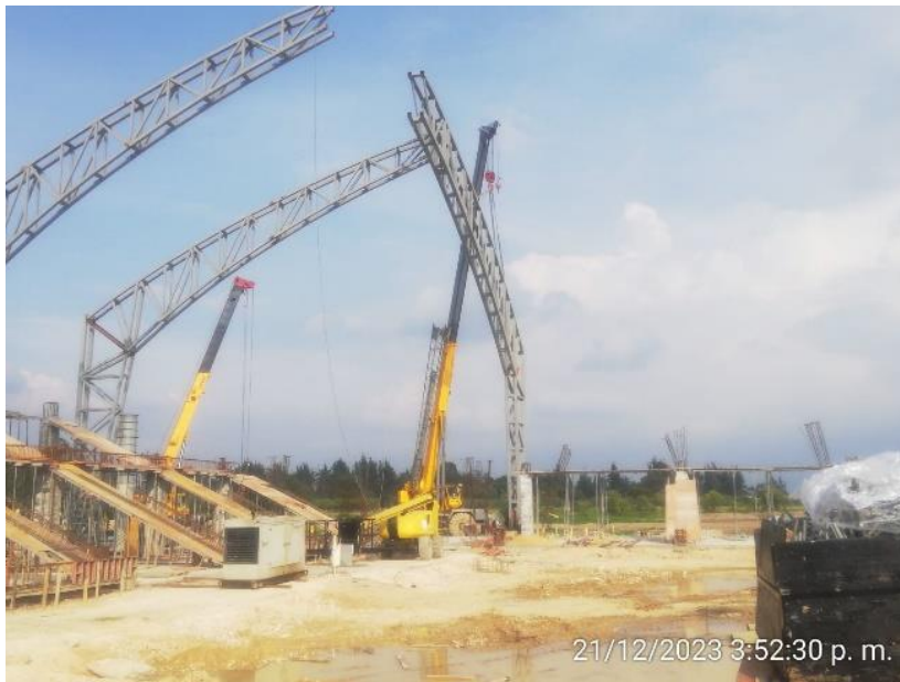
Izaje de columnas metálicas
