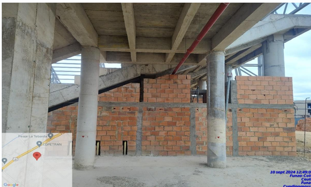
Mampostería gradería norte
