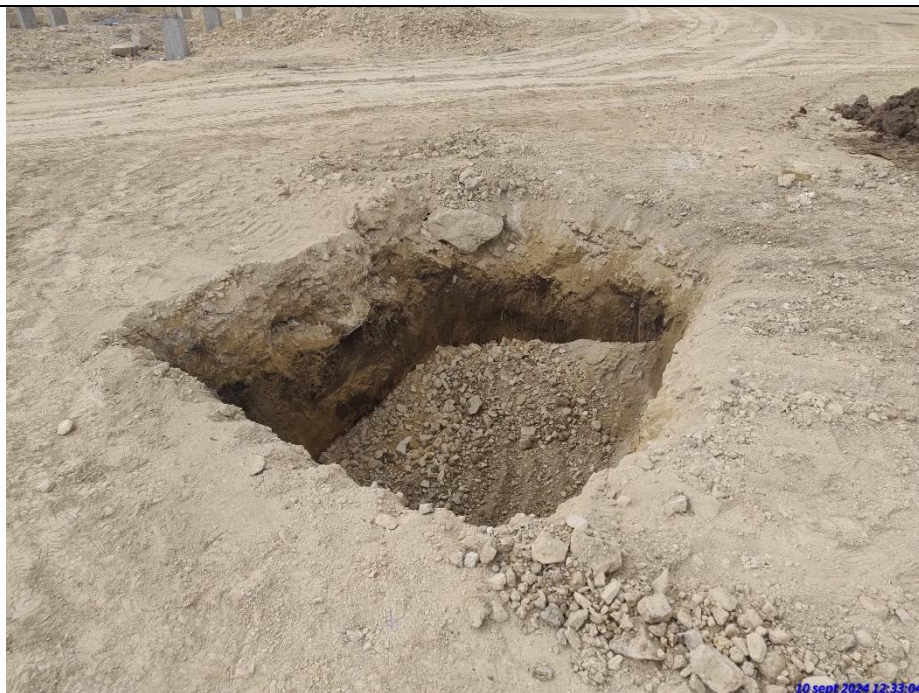
Excavación cimentación administración.
