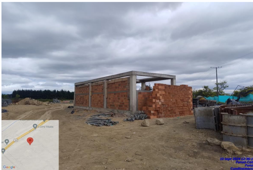
Estructura y mampostería edificio cuartos técnicos
