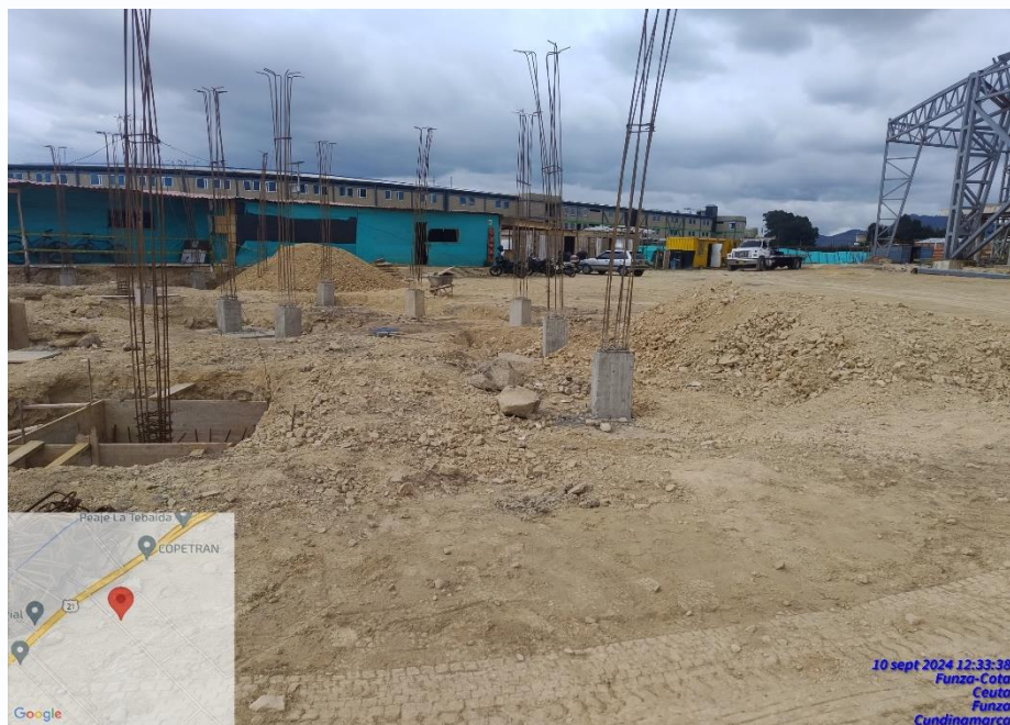
Cimentación edificio administración
