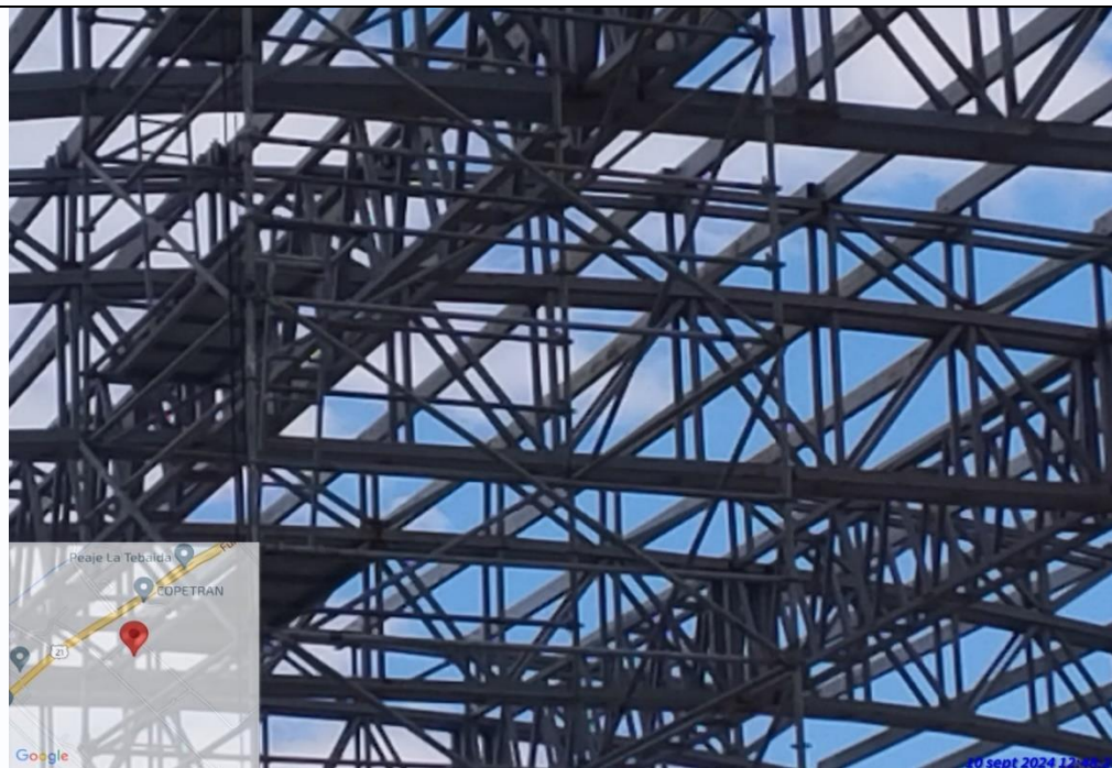
Vigas de amarre bóveda central
