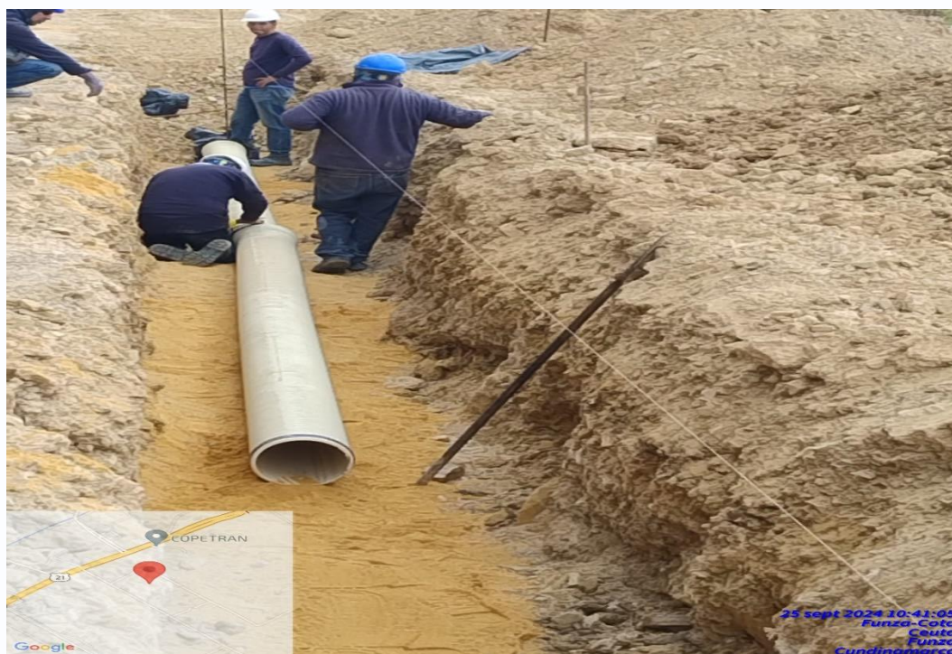
Instalación tubería aguas lluvias costado oriental
