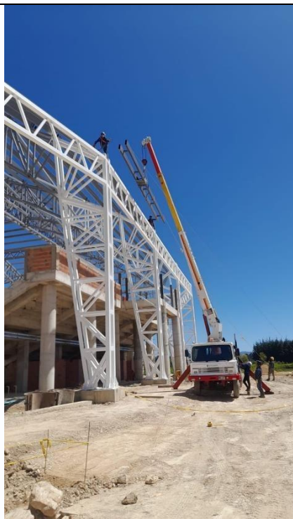
Estructura canal en lamina
