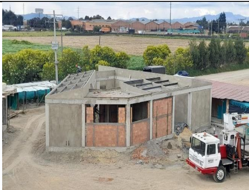
Estructura cubierta administración
