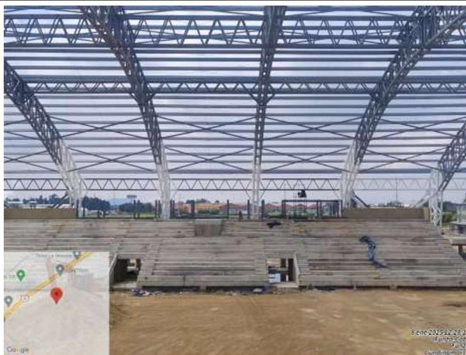
Instalación material granular en área de juego
