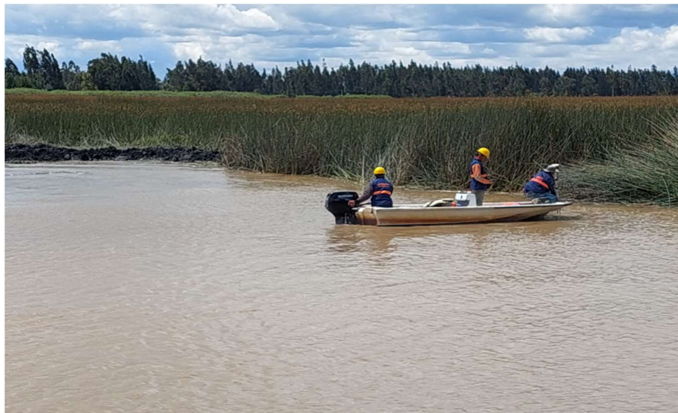
Ilustración 17. Topo batimetría realizada por topografía interventoría
