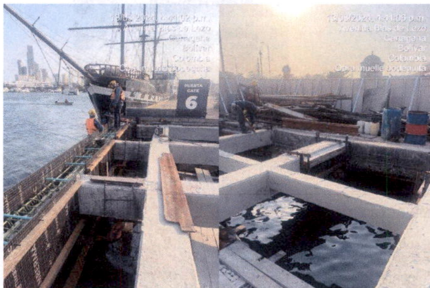
Ilustración 36. Progreso formaleta y fundida.
