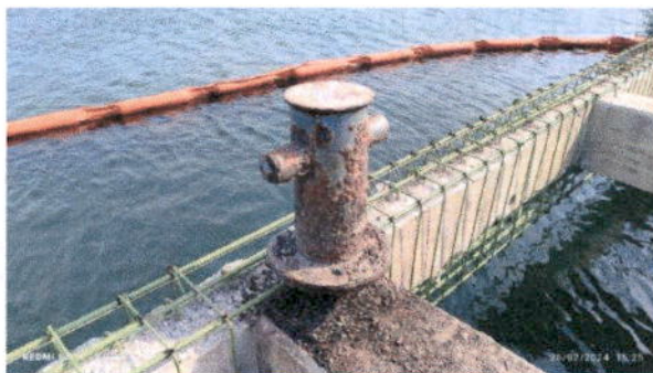
Ilustración 50. Bitas retiradas del muelle.
