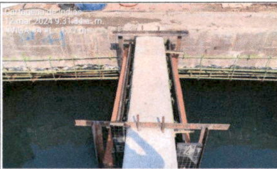
COLOCACION DE FORMALETA
