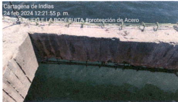
Ilustración 5. Continua demolición e impermeabilización en zona inferior de viga longitudinal.
