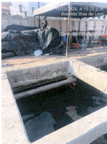
Ilustración 31. Progreso de demolición de parte inferior de viga longitudinal 1 y refuerzo.
