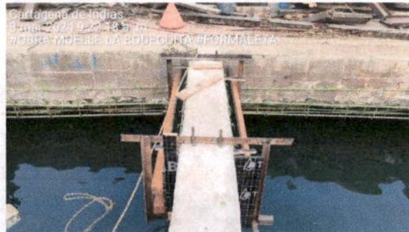
Ilustración 27. Progreso de perfiles para formaleta viga transversa 3.
