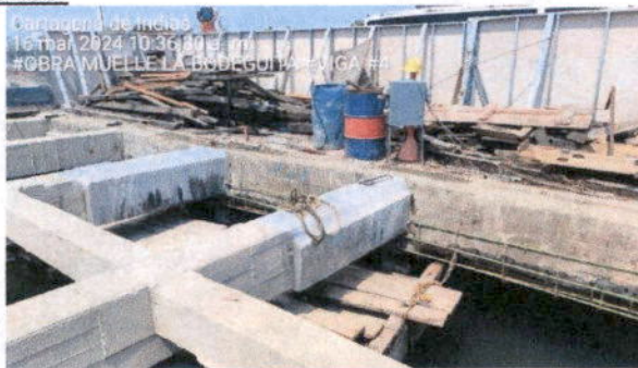
Ilustración 39. Curado de vigas intervenidas.
