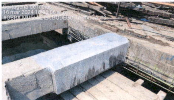
Ilustración 40. Curado de viga intervenida.
