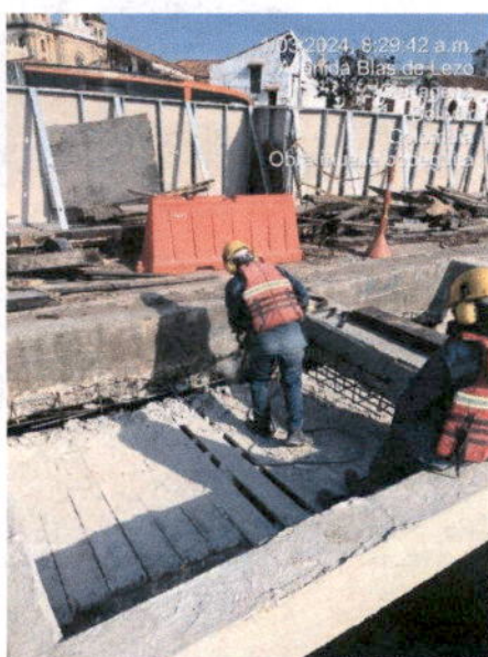
Ilustración 16. Avance en demolición de tramo de viga longitudinal 1.
