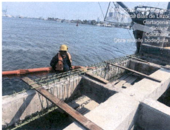
Ilustración 1. Continuación de figurado de acero
