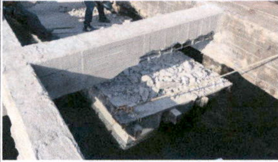
DEMOLICION DE LA ZONA AFECTADA
