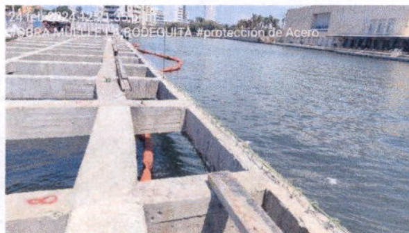
Ilustración 4. viga corona demolida
