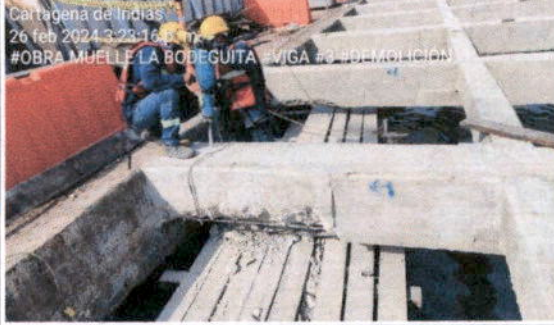
DEMOLICION DE LA ZONA AFECTADA
