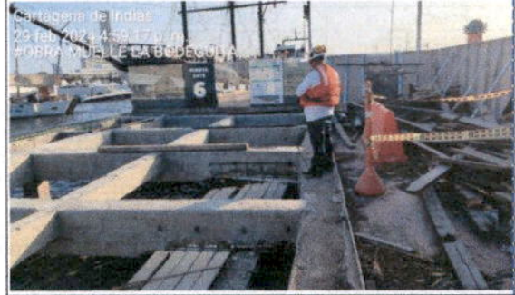
COLOCACION DE ACERO DE REFUERZO SEGÚN RECOMENDACIÓN ESTRUCTURAL DEL ASESOR
