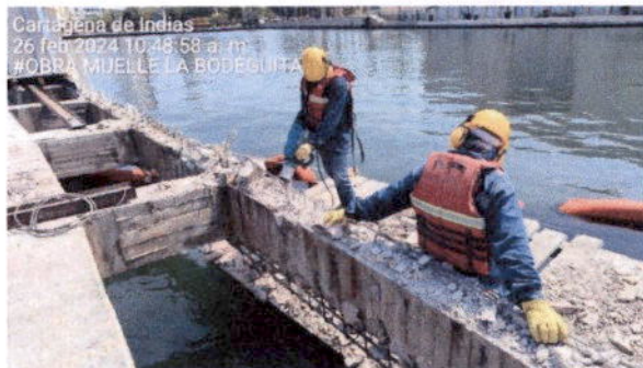
Ilustración 7. Demolición viga longitudinal 4.
