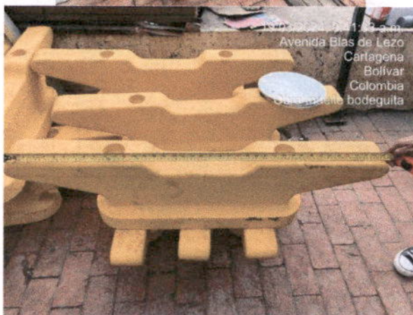
Ilustración 51. Bitas nuevas recibidas en obra.
