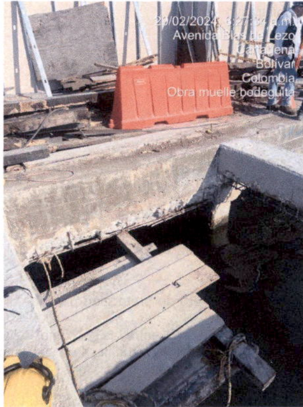
Ilustración 13. Demolición viga longitudinal 1 tramo 6-7.
