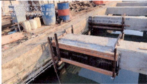
Ilustración 35. Progreso de encofrado y fundida.
