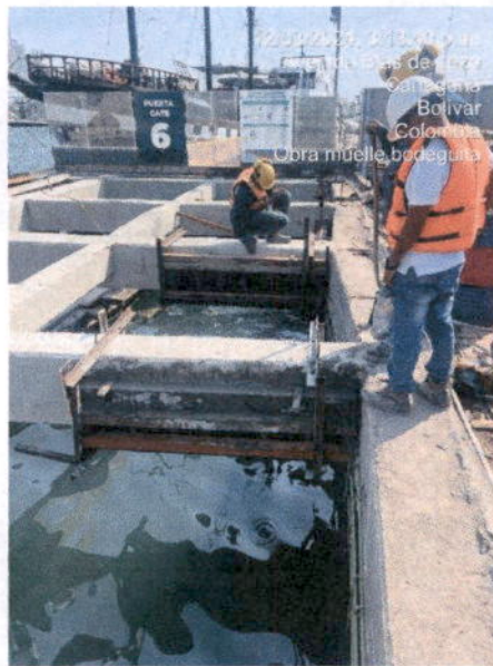
Ilustración 34. Revisión de interventoría de fundida.
