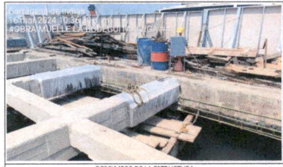
DESCIMBRE DE LA ESTRUCTURA
