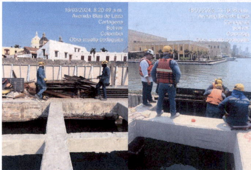
Ilustración 41. Preparacion y corte de madera para formaletas.
