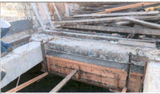
FUNDIDA DE CONCRETO
