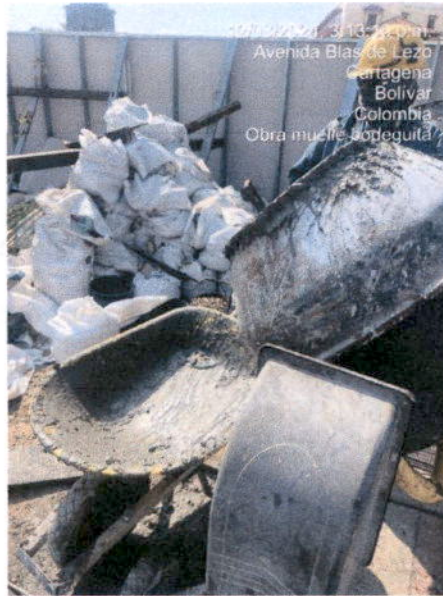
Ilustración 33. Fundida de concreto.
