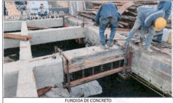
FUNDIDA DE CONCRETO
