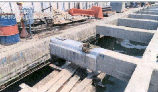
DESCIMBRE DE LA ESTRUCTURA
