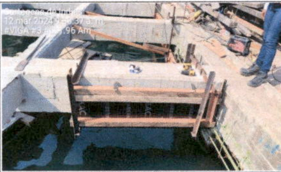
COLOCACION DE FORMALETA
