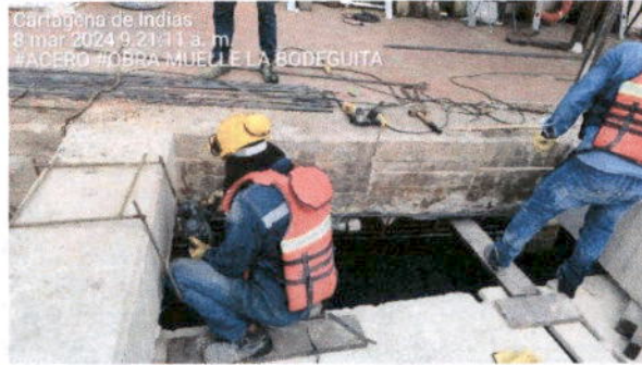
Ilustración 26. Progreso de refuerzo viga longitudinal.
