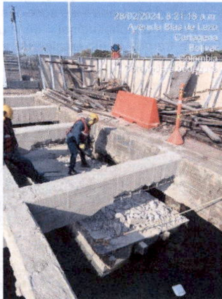
Ilustración 10. Demolición de vigas transversales por intervenir.
