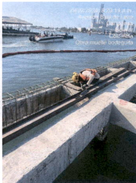
Ilustración 12. Colocación de acero para preparar formaletería.
