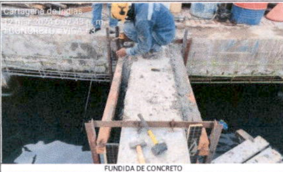
FUNDIDA DE CONCRETO
