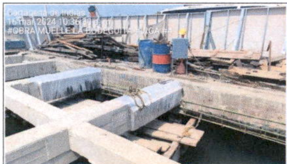
DESCIMBRE DE LA ESTRUCTURA
