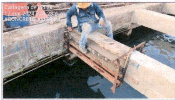
FUNDIDA DE CONCRETO
