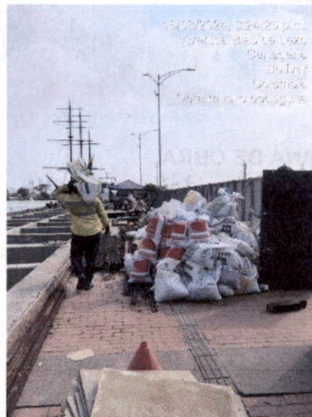
Ilustración 42. Llegada de material de arena para fundida.
