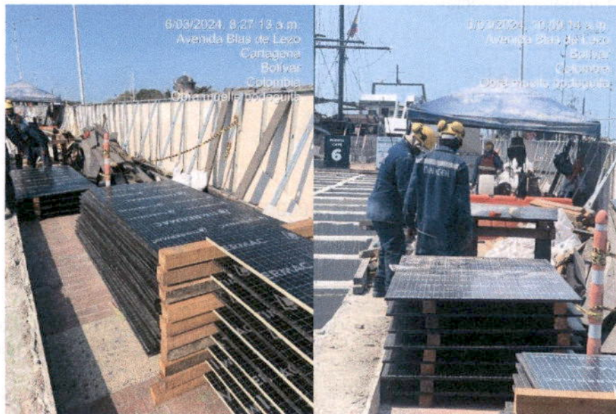
Ilustración 21. Llegada de material de madera para formaletas.
