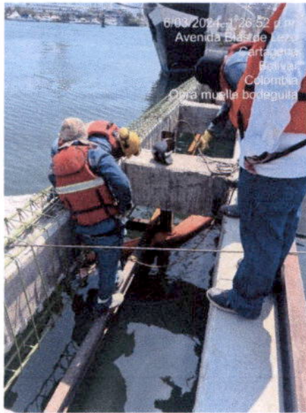
Ilustración 22. Perfiles fundidos para formatear la viga longitudinal 4.
