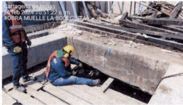
Ilustración 6. Inicio de demolición de viga longitudinal 1
