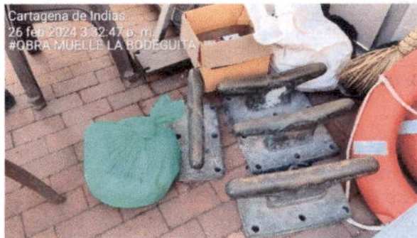
Ilustración 8. Antiguas bitas del muelle.
