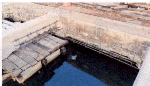
Ilustración 20. Refuerzo de acero tramos de viga longitudinal 1.
