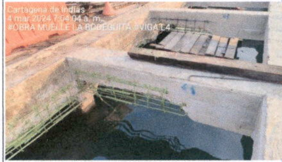
COLOCACION DE ACERO DE REFUERZO SEGUN RECOMENDACION ESTRUCTURAL DEL ASESOR
