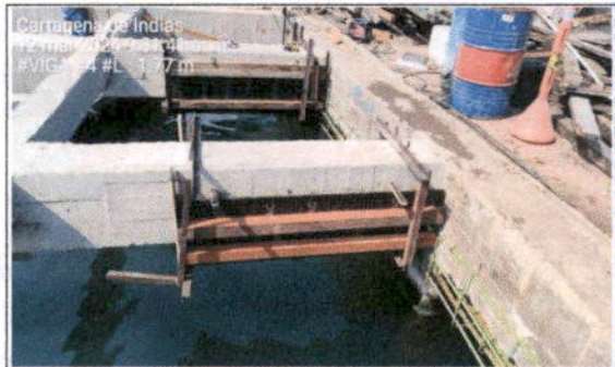
COLOCACION DE FORMALETA
