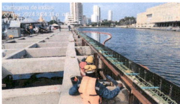
Ilustración 46. Progreso de formaleta de viga longitudinal 4 hasta 20 de marzo.
