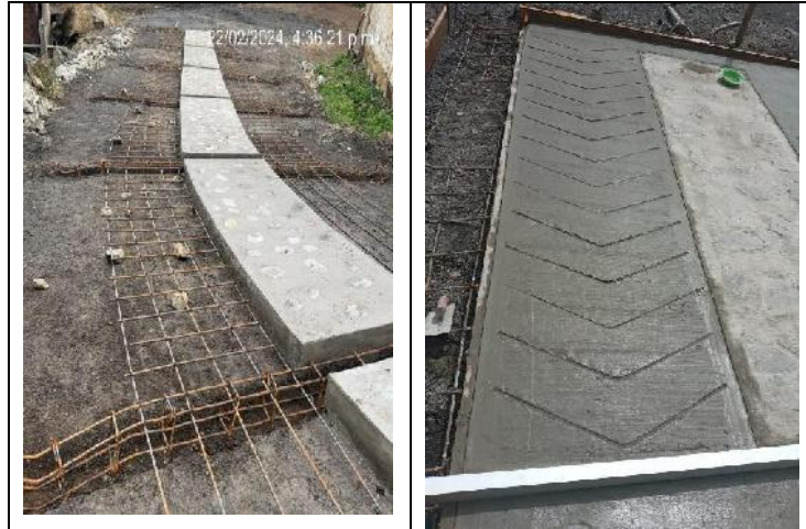
PROCESO FUNDICION DE HUELLAS DE LA VIA
