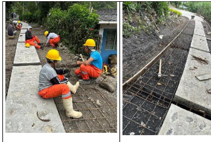
INSTALACION DE ACERO DE REFUERZO
