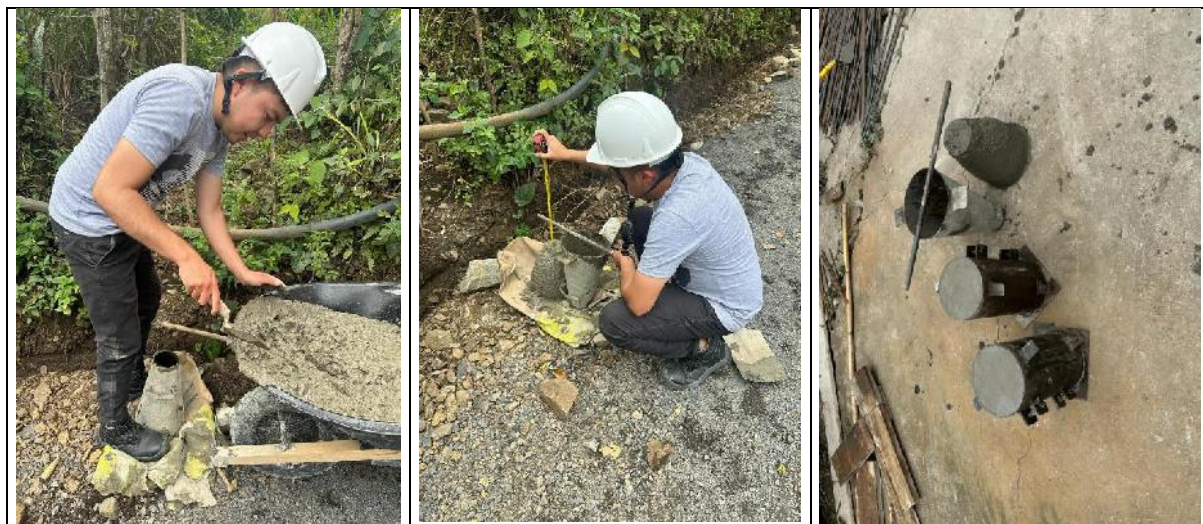
CONFORMACION DE SUBBASE CON MATERIAL SELECCIONADO
