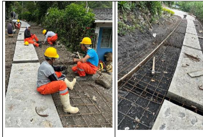
INSTALACION DE ACERO DE REFUERZO
