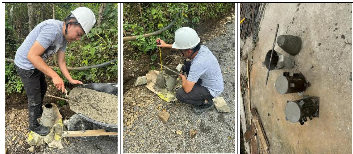
CONFORMACION DE SUBBASE CON MATERIAL SELECCIONADO
