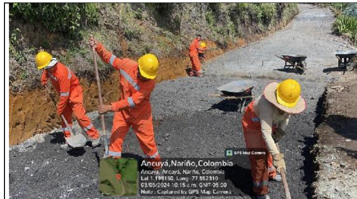
EXTENDIDO Y CONFORMACION SUBBASE GRANULAR
