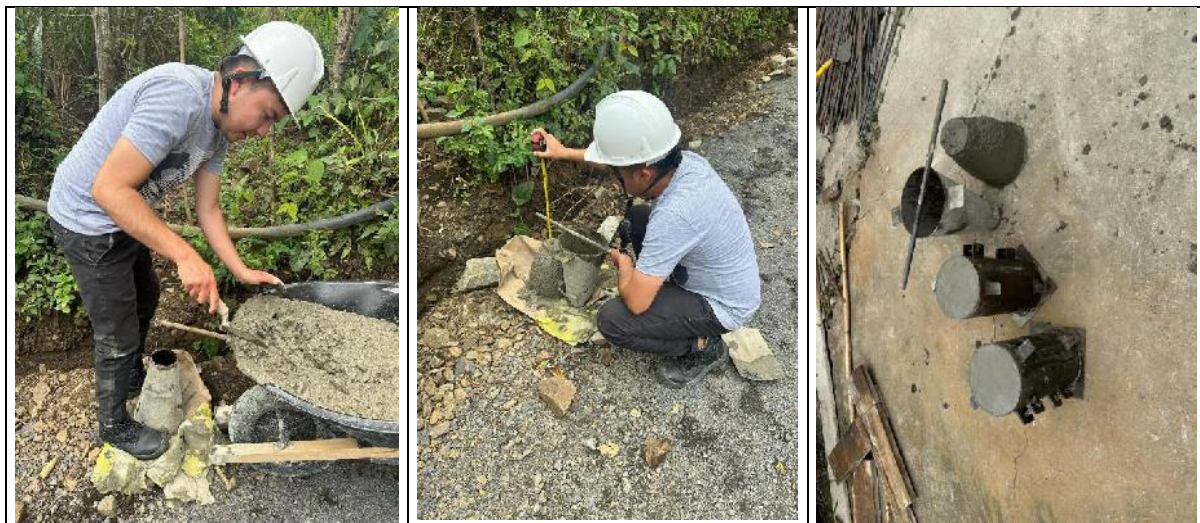
CONFORMACION DE SUBBASE CON MATERIAL SELECCIONADO
