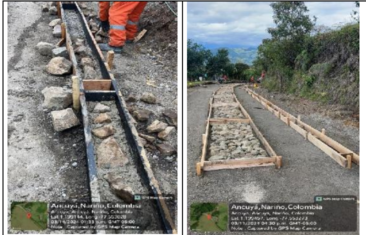
INSTALACION Y ALINEACION DE FORMALETA
