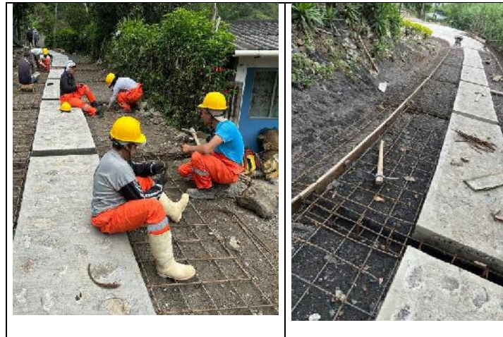
INSTALACION DE ACERO DE REFUERZO
