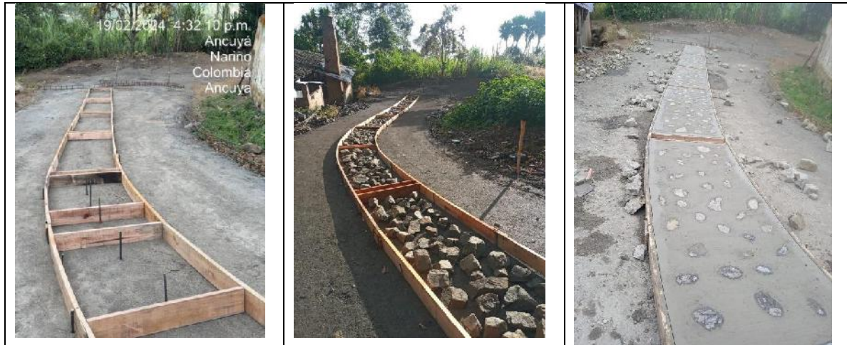
PROCESO FUNDICION DE EJE VIAL EN CONCRETO CICLOPEO
