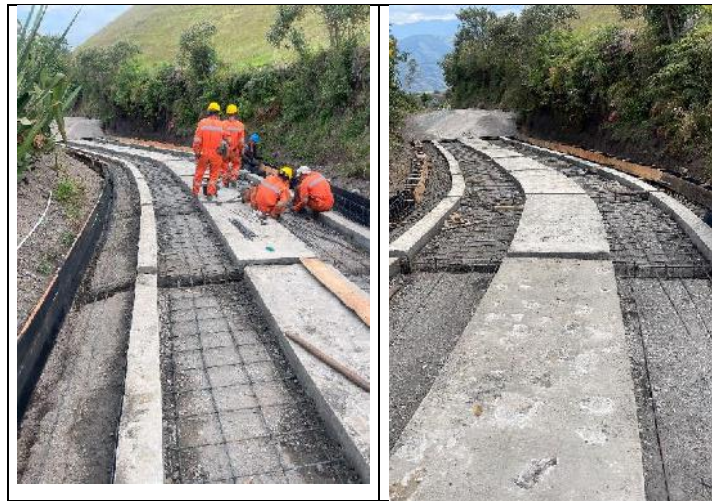
ARMADO E INSTALACION DE ACERO DE REFUERZO
