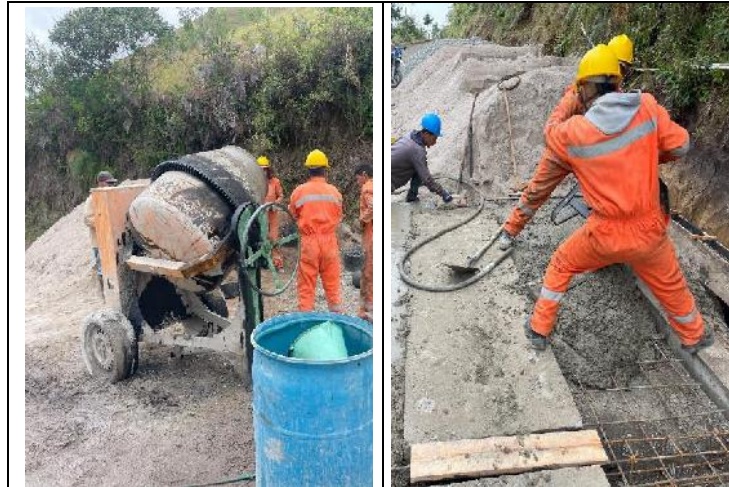
FUNDICION EN CONCRETO RIGIDO (CUNETAS, HUELLAS Y VIGAS)
