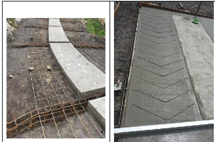
PROCESO FUNDICION DE HUELLAS DE LA VIA
