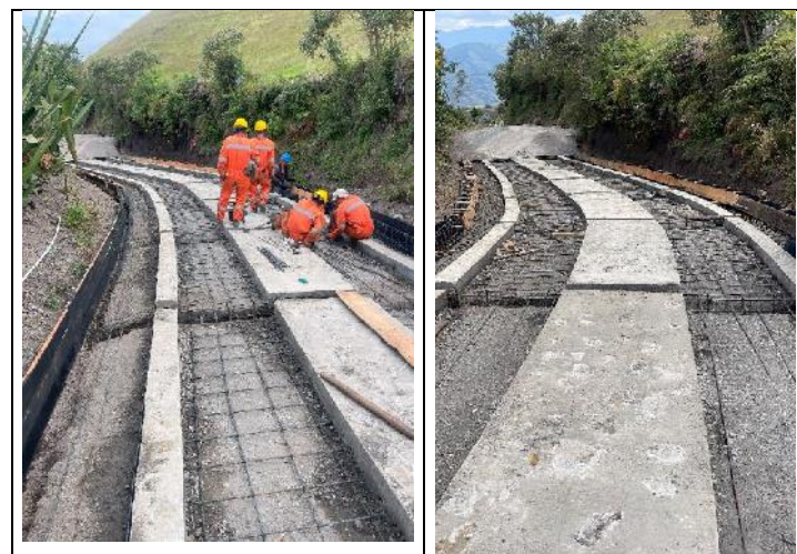
ARMADO E INSTALACION DE ACERO DE REFUERZO
