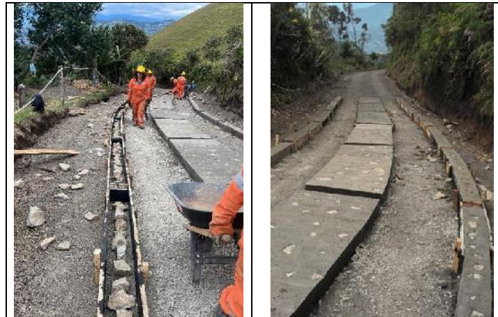
FUNDICION EN CONCRETO CICLOPEO (EJE Y SOBREAANCHOS)
