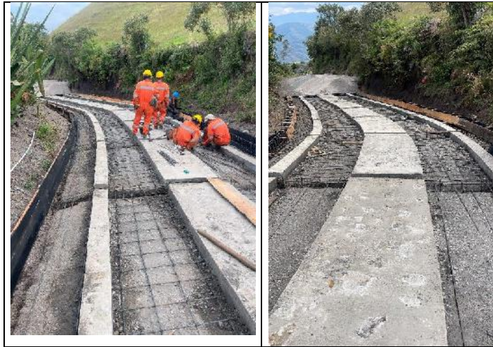
ARMADO E INSTALACION DE ACERO DE REFUERZO
