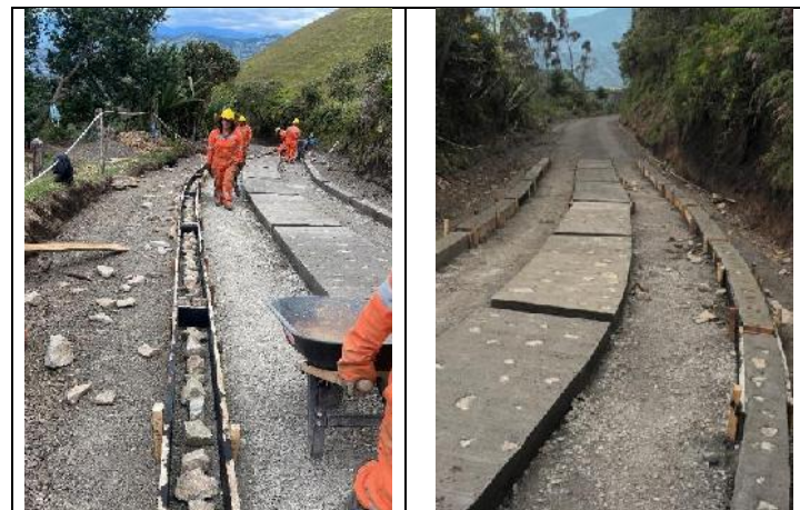
FUNDICION EN CONCRETO CICLOPEO (EJE Y SOBREALANCHOS)
