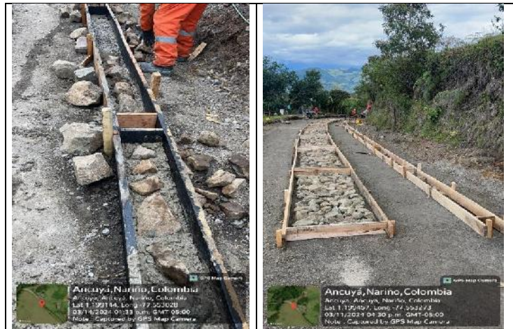
INSTALACION Y ALINEACION DE FORMALETA
