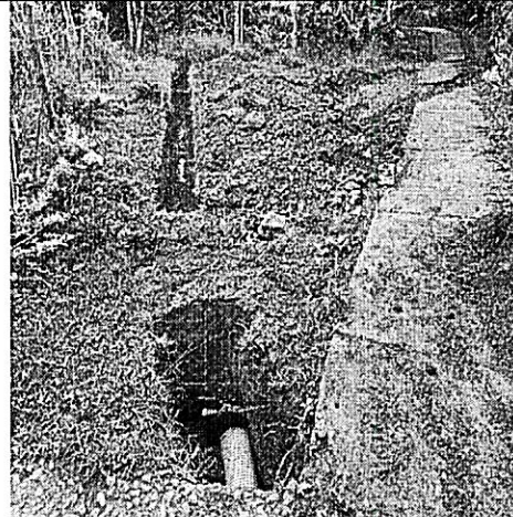
Foto 6 – Excavación de zanja para tubería
