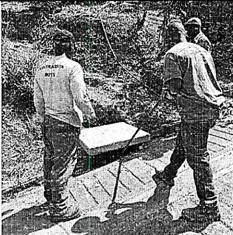
Foto 5 – Instalación tapas de cajas domiciliarias
