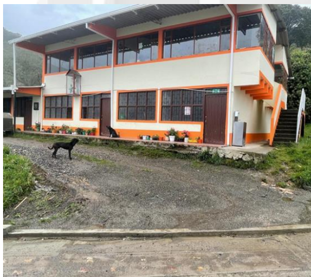
Imagen 1 – Zona a intervenir - K0+000 en Resguardo en Escuela rural sede vereda resguardos
