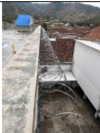
Ilustración 26: 12/12/2024 Instalación de concertina galvanizada en muro de fachada en parte superior de terraza
