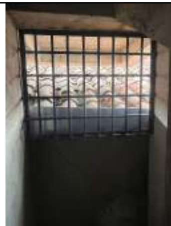
Ilustración 23: 12/12/2024 Instalación de rejilla en vano ubicado en la escalera que conduce a la terraza y garita
