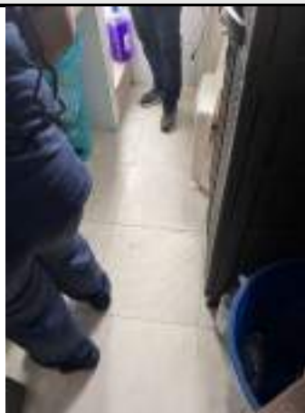
Ilustración 10: 24/01/2025 COCINAS Cocinas en buen estado paredes, cielo raso y mesones
