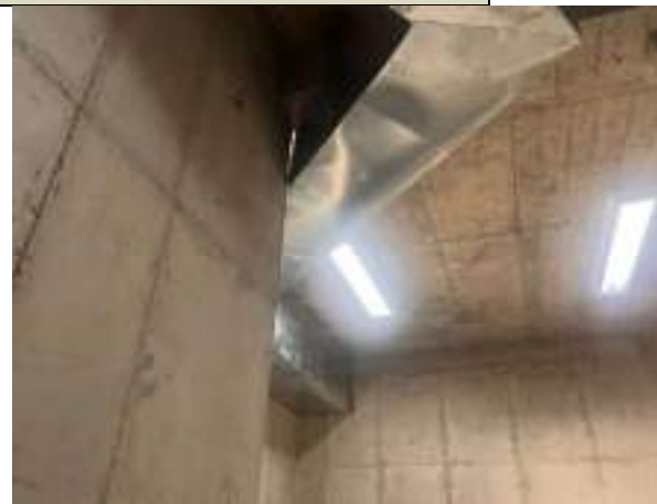
Ilustración 25: 12/12/2024 Instalación de luminarias antivandálicas en nuevo y segundo piso de bloque antiguo
