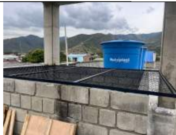
Ilustración 19: 12/12/2024 Instalación de cerramiento con malla de seguridad en vano de punto fijo del bloque de pabellones
