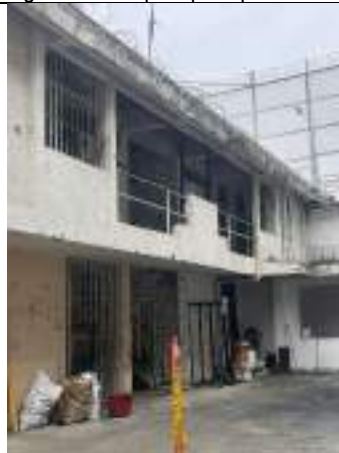
Ilustración 17: 12/12/2024 Instalación de cerramiento con malla de seguridad anclado entre vigas de entrepiso para pasillo de celdas del bloque antiguo. Piso 2
