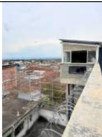
Ilustración 27: 12/12/2024 Instalación de concertina galvanizada en muro de fachada en parte superior de terraza
