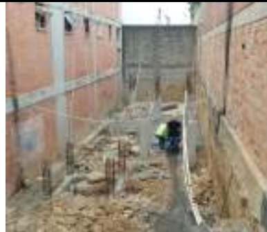
Ilustración 5: 30/01/2025 Fundición de plantilla de e=10cm
