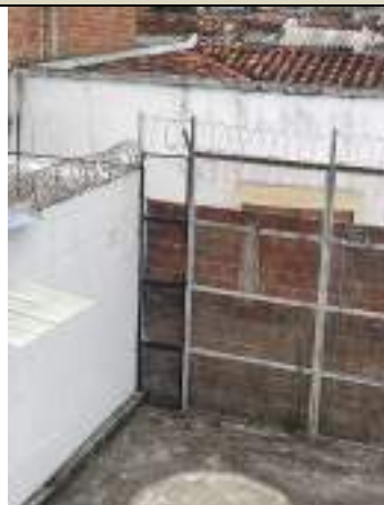
Ilustración 4: 12/12/2024 Continuidad de cerramiento perimetral con malla eslabonada
