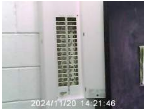
Ilustración 18: Traslado de tablero eléctrico
