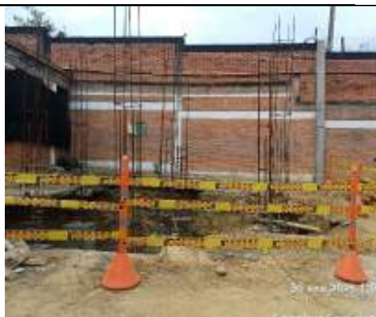
Ilustración 2: 30/01/2025 Señalización y delimitación de frentes de trabajo
