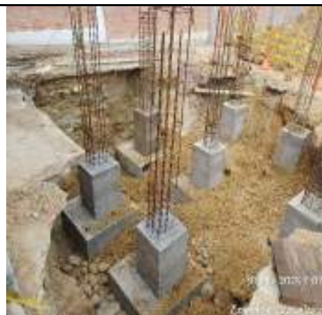
Ilustración 1: 30/01/2025 Construcción de cimentación (zapatas y pedestales) y relleno de excavación
