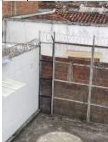
Ilustración 28: 12/12/2024 Instalación de concertina galvanizada en cerramiento perimetral
