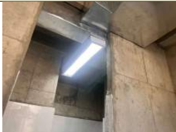
Ilustración 24: 12/12/2024 Instalación de luminarias antivandálicas en celdas del bloque nuevo y segundo piso de bloque antiguo
