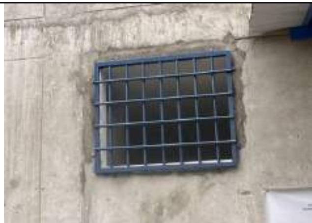
Ilustración 22: 12/12/2024 Instalación de rejilla en vano del área de sanidad
