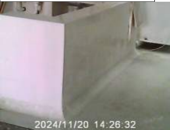
Ilustración 4: Impermeabilización manto asfáltico cubierta
