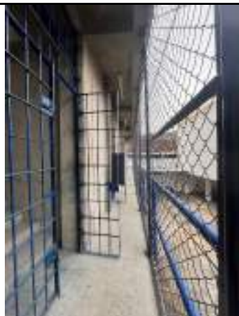
Ilustración 14: 12/12/2024 Instalación de cerramiento con malla de seguridad anclado entre vigas de entrepiso para pasillos de celdas del bloque nuevo
