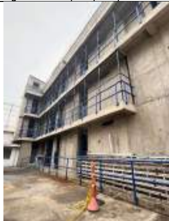
Ilustración 16: 12/12/2024 Instalación de cerramiento con malla de seguridad anclado entre vigas de entrepiso para pasillos de celdas del bloque nuevo. Piso 2 y 3
