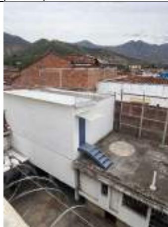
Ilustración 29: 12/12/2024 Instalación de concertina galvanizada en cerramiento perimetral
