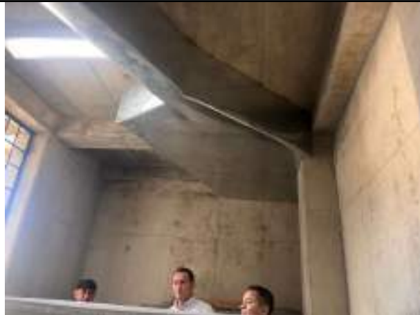
Ilustración 10: 12/12/2024 Instalación de ducto con lámina para proteger la instalación sanitaria a la vista de las celdas internas del bloque nuevo
