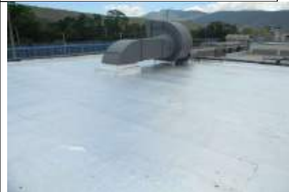
Ilustración 4: Impermeabilización manto asfáltico cubierta
