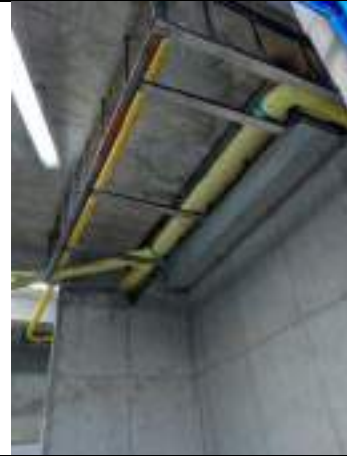
Ilustración 13: 22/10/2024 Instalación de estructura para ducto con lámina para proteger la instalación sanitaria a la vista de las celdas internas del bloque nuevo
