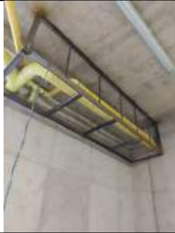
Ilustración 12: 22/10/2024 Instalación de estructura para ducto con lámina para proteger la instalación sanitaria a la vista de las celdas internas del bloque nuevo
