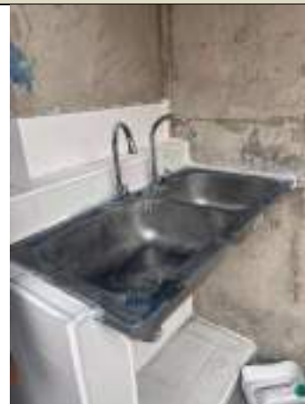
Ilustración 21: 12/12/2024 Revisión de aparatos hidrosanitarios en funcionamiento
