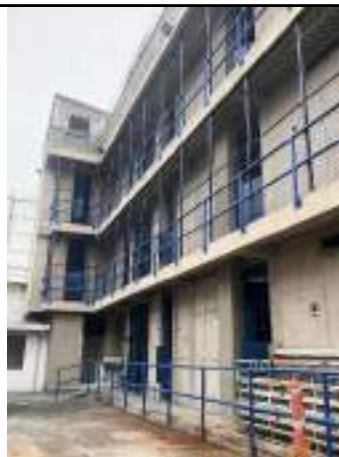
Ilustración 15: 12/12/2024 Instalación de cerramiento con malla de seguridad anclado entre vigas de entrepiso para pasillos de celdas del bloque nuevo
