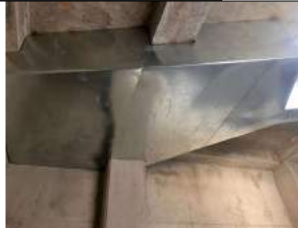
Ilustración 11: 12/12/2024 Instalación de ducto con lámina para proteger la instalación sanitaria a la vista de las celdas internas del bloque nuevo
