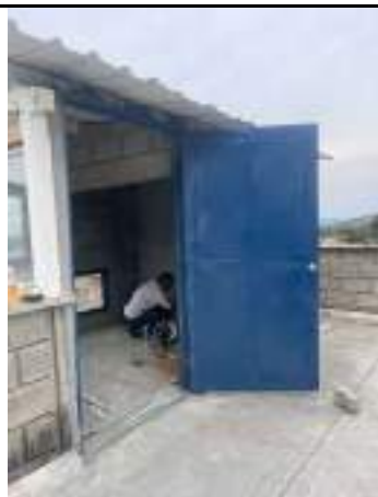
Ilustración 3: 12/12/2024 Instalación puerta metálica y cerradura
