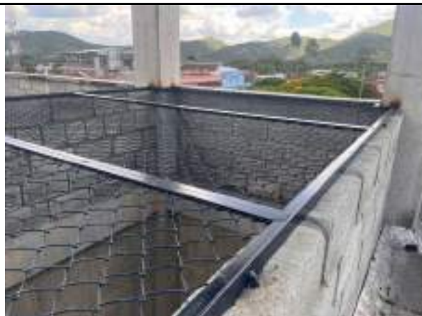
Ilustración 18: 12/12/2024 Instalación de cerramiento con malla de seguridad en vano de punto fijo del bloque de pabellones
