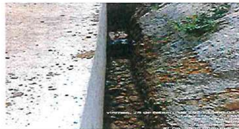
FOTOGRAFÍA No. 6: • Rellenos perimetrales: en ejecución
