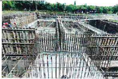
FOTOGRAFÍA No.9: Tanque de almacenamiento La Albania
