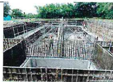
FOTOGRAFÍA No. 10: Tanque de almacenamiento La Albania
