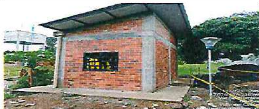
FOTOGRAFÍA No.7: caseta electrica, obra civil ejecutada,
