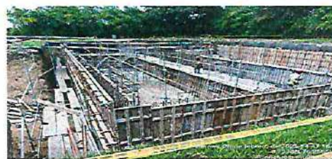
FOTOGRAFÍA No.8: Tanque de almacenamiento La Albania
