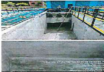
FOTOGRAFÍA No.3: Sedimentador 1: La obra civil se terminó, ya el Sub contratista Co Ingeniería, va iniciar las labores de verificación de medidas para el barrelados y canaletas en acero inoxidable .
