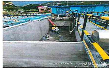
FOTOGRAFÍA No.4: Sedimentador 1: La obra civil se terminó, ya el Sub contratista Co Ingeniería, va iniciar las labores de verificación de medidas para el barrelados y canaletas en acero inoxidable .
