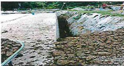
FOTOGRAFÍA No.5: • Rellenos perimetrales: en ejecución
