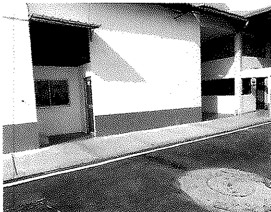
Pintura para exteriores sobre fachada.
