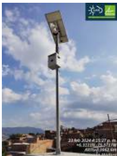
Figura 17.2: Reinstalación de cámara, Socavación La madera.
