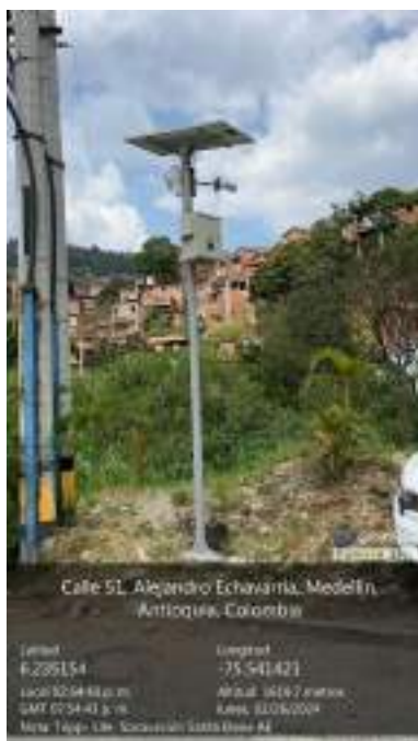
Figura 17.1: Instalación de cámara, Socavación Santa Elena AE.
