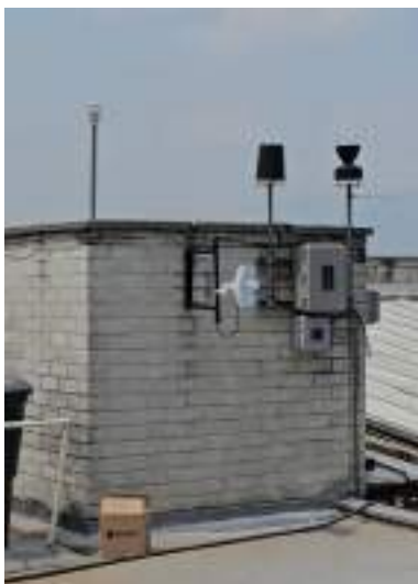
Figura 17.3: Instalación de caja Kowet en colegio Santa Catalina El Tesoro.
