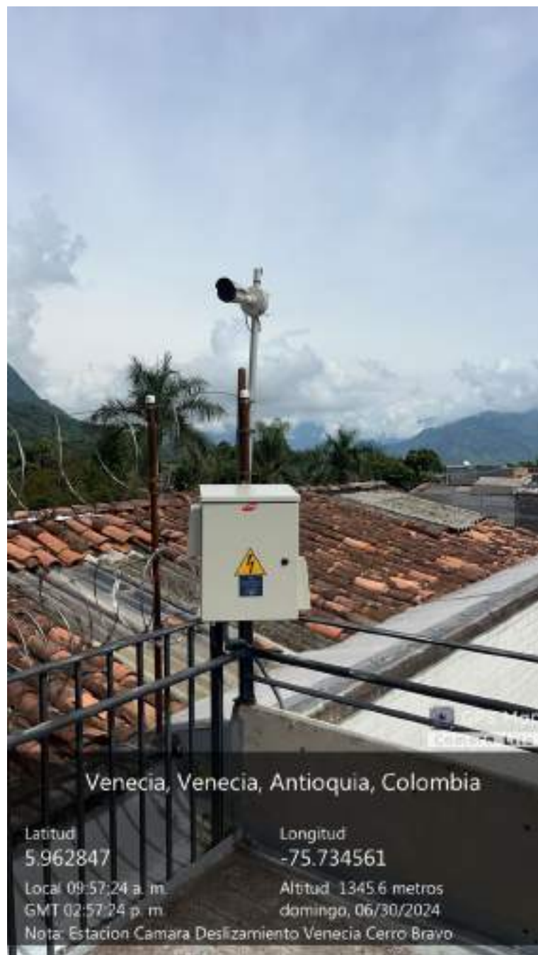
Figura 17.3: Deslizamiento Cerro Bravo.
