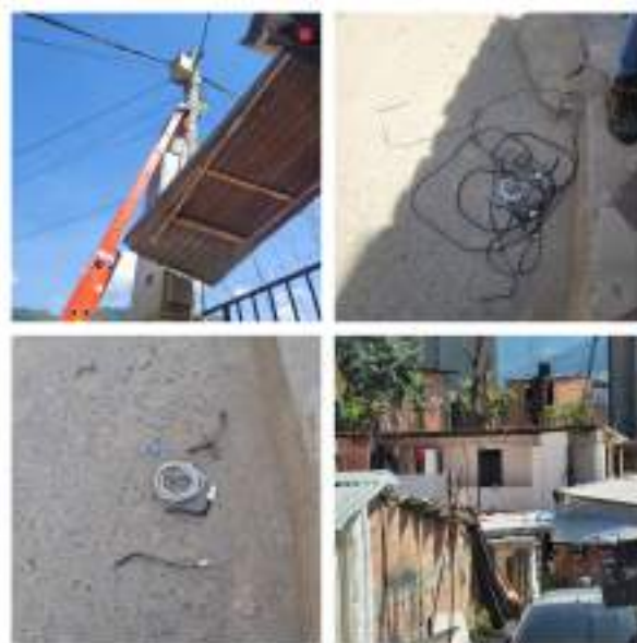
Figura 15.8: Desinstalación de conexiones acometida - SATC Hato Viejo - junio 13 de 2024.
