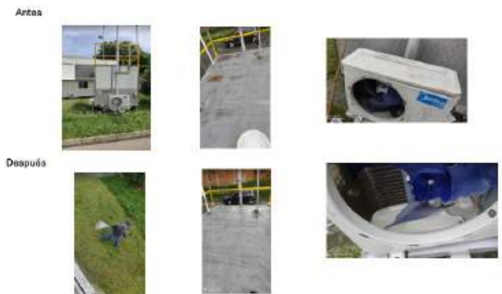
Figura 17.6: Evidencia de la ejecución del programa de limpieza en la estación Casa de Justicia durante el mes de junio de 2024.
