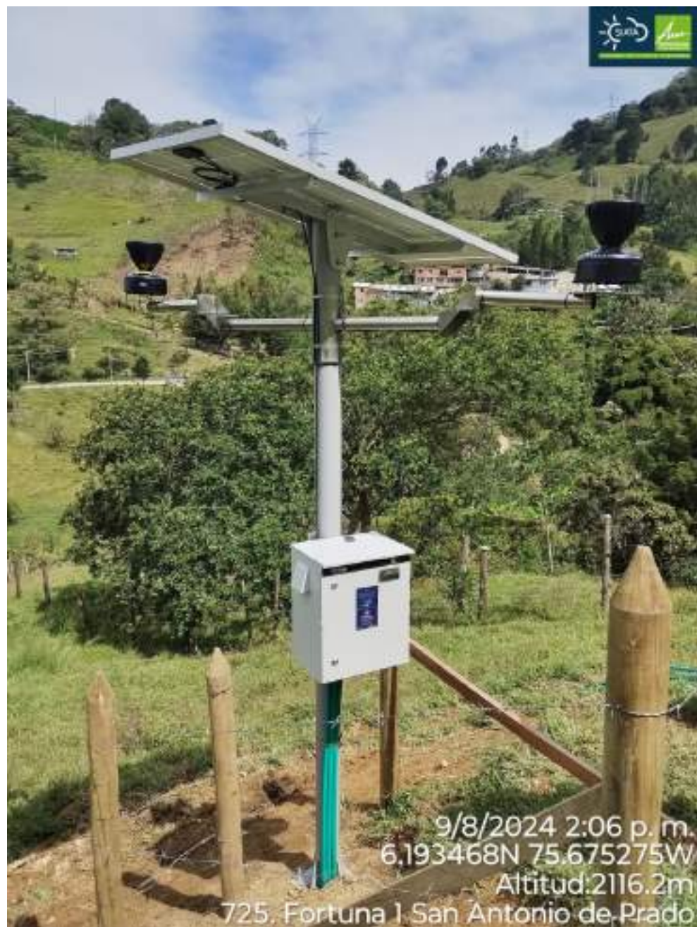
Figura 18.1: Monitoreo Geotecnia, La Fortuna 1.
