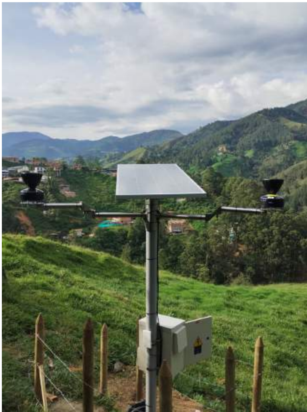
Figura 18.2: Monitoreo Geotecnia, Lomita 2.
