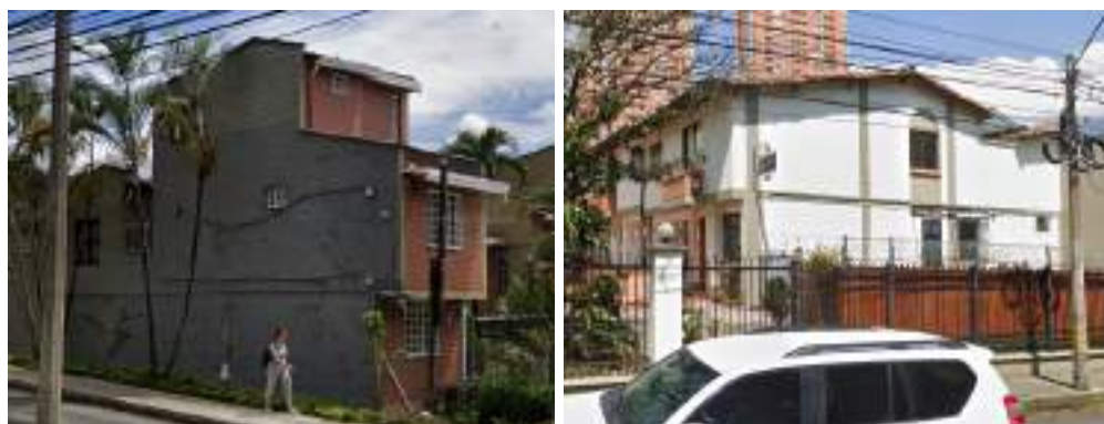
Figura 9.6: Ejemplo de edificaciones inspeccionadas de manera virtual para la asignación de las características de interés para la construcción del modelo de exposición.
