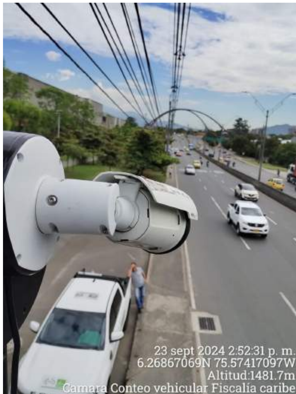
Figura 19.2: Cámara de conteo vehicular en la sede de la Fiscalía, Barrio Caribe.
