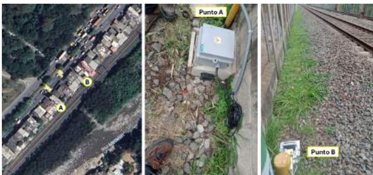
Figura 10.1: Ubicación acelerógrafos EQR-120 para la medición de vibraciones ambientales en el punto crítico localizado en la obra hidráulica de la quebrada Tinajas.
