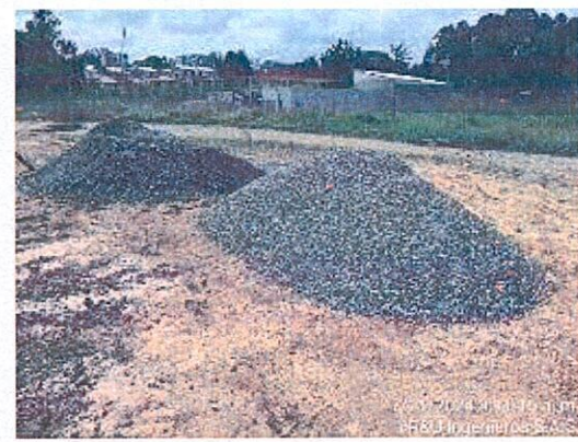
Fotografía 4: Almacenamiento temporal de materiales pétreos.
