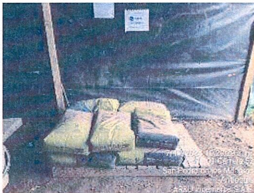
Fotografía 5: Campamento y almacén de obra.
