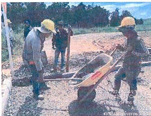
Fotografía 7: Preparación manual de concreto.
