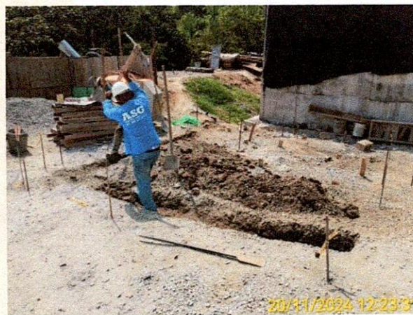
Fotografía: Se inicia con la excavación manual para las vigas de la caseta de operaciones.
