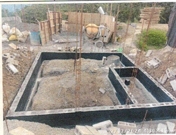
Fotografía: Aplicación de Sika igol denso para la protección las humedades en la cimentación de los muros de la caseta de operaciones.
