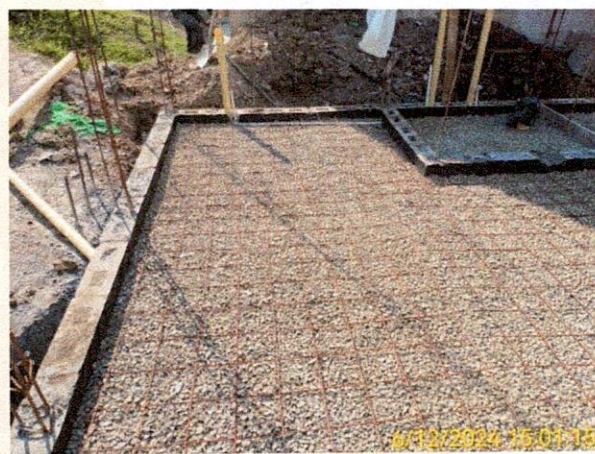
Fotografía: Instalación de la malla electrosoldado para el refuerzo del piso en concreto de la caseta de operaciones.
