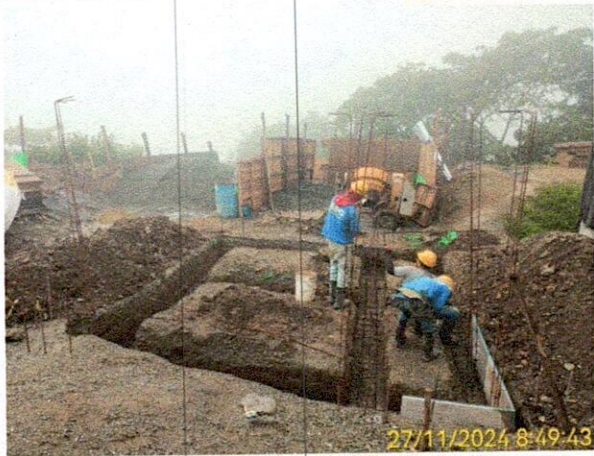
Fotografía: Encofrado en madera para la construcción de las vigas de cimentación de la caseta de operaciones de la planta de tratamiento de agua potable.
