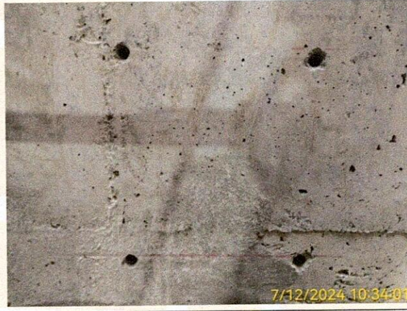
Fotografía: Marcación y escarificación mecánica para las zonas afectadas por el hormigueo en el concreto de la cara externa de los muros en los costados derecho e izquierdo del tanque de almacenamiento.
