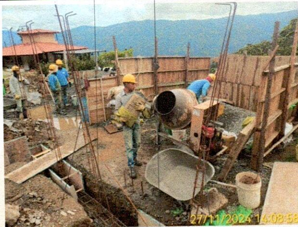
Fotografía: Preparación del concreto de 28Mpa para el vaciado de las vigas de cimentación de la caseta de operaciones.
