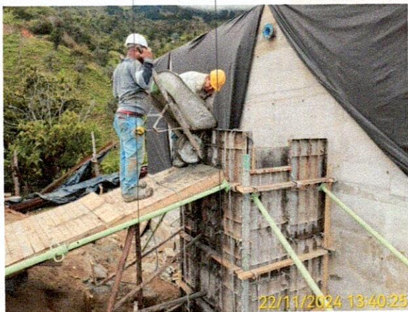
Fotografía: se realiza el vaciado y vibrado del concreto de 28Mpa para los muros del cuarto de válvulas del tanque de almacenamiento.
