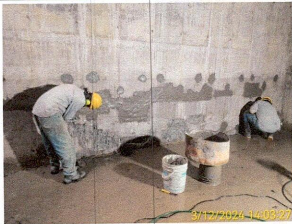
Fotografía: Aplicación del mortero de alta resistencia a las zonas afectadas por el hormiguo en la cara interna del muro frontal del tanque de almacenamiento.
