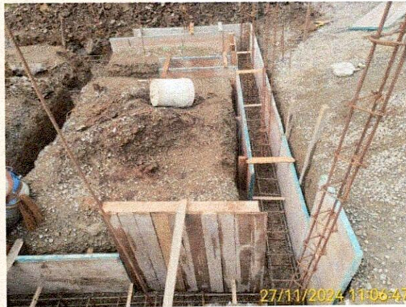
Fotografía: Encofrado en madera para la construcción de las vigas de cimentación de la caseta de operaciones de la planta de tratamiento de agua potable.
