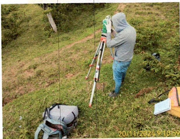
Fotografía: Levantamiento topográfico para el trazado de la red de conducción entre el desarenador y la planta de tratamiento de agua potable.
