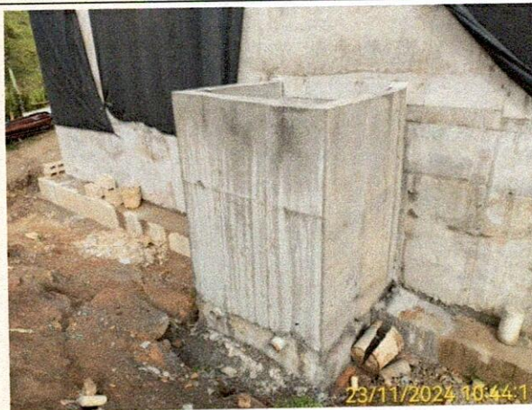
Fotografía: Desmonte de las formaleas metálicas que se encontraban instaladas para la construcción del cuarto de válvulas.
