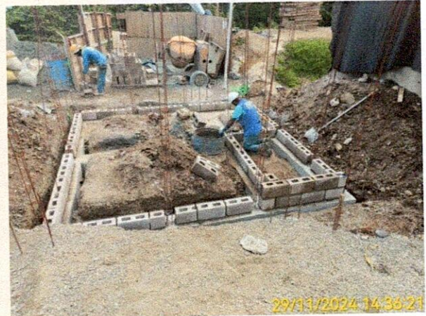
Fotografía: Instalación de los bloques de concreto para las dos primeras de la cimentación de la caseta de operaciones.
