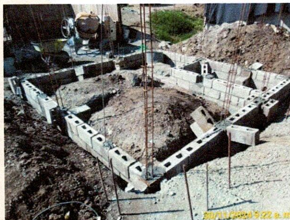
Fotografía: Vaciado de concreto para las columnetas en las dos primeras hiladas de los bloques.
