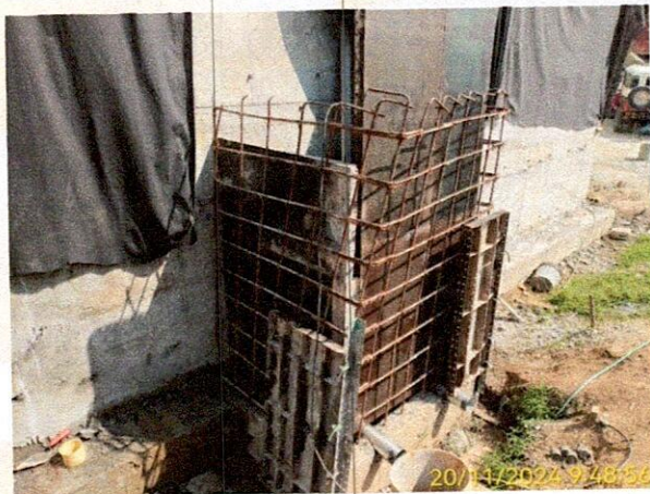
Fotografía: Instalación de las tapas metálicas para el encofrado de las caras interna y externa del cuarto de válvulas.
