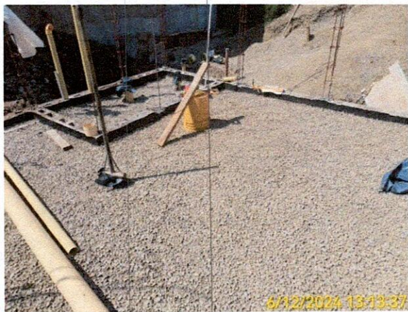
Fotografía: Instalación y nivelación del triturado para el entresuelo de la caseta de operaciones.
