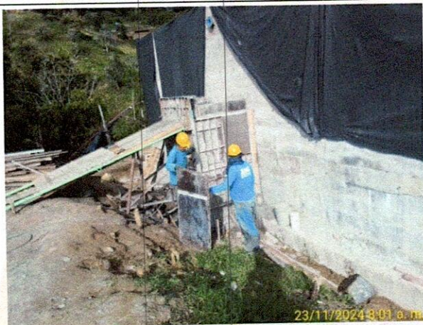
Fotografía: Desmonte de las formaleas metálicas que se encontraban instaladas para la construcción del cuarto de válvulas.
