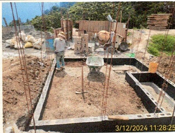
Fotografía: Se realiza llenos con material del sitio para la nivelación del entresuelo de la caseta de operaciones.
