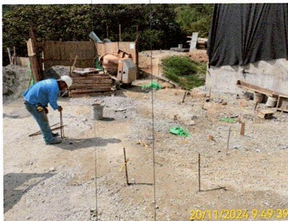
Fotografía: se realiza la marcación de los ejes para la ubicación de las vigas de la caseta de operaciones.
