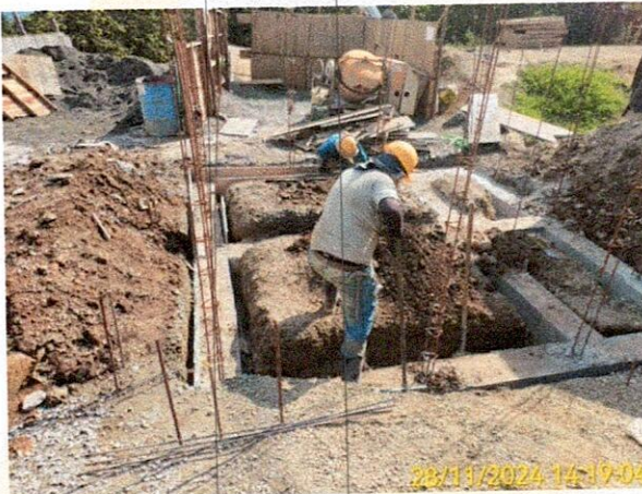
Fotografía: Retiro de las formaletas en madera que se utilizaron en la construcción de las vigas de cimentación.
