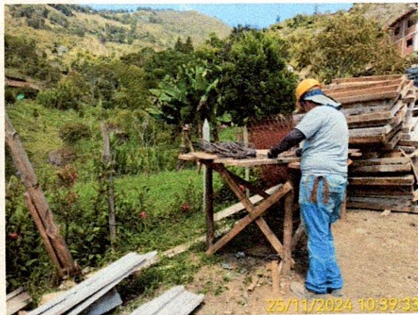
Fotografía: Corte y figurado del acero de refuerzo para las vigas de cimentación de la caseta de operaciones.
