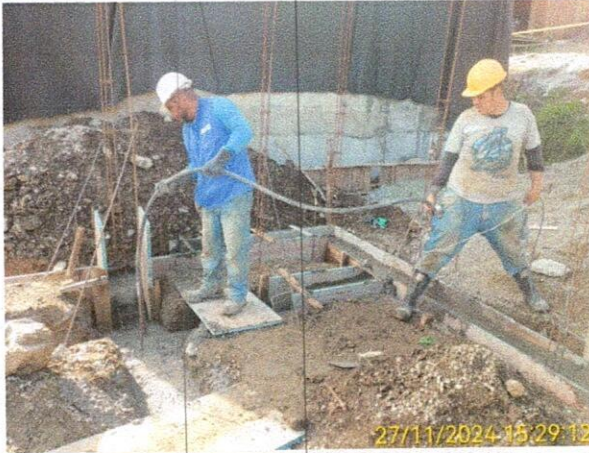
Fotografía: Vibrado del concreto que se ha vaciado en las vigas de cimentación.
