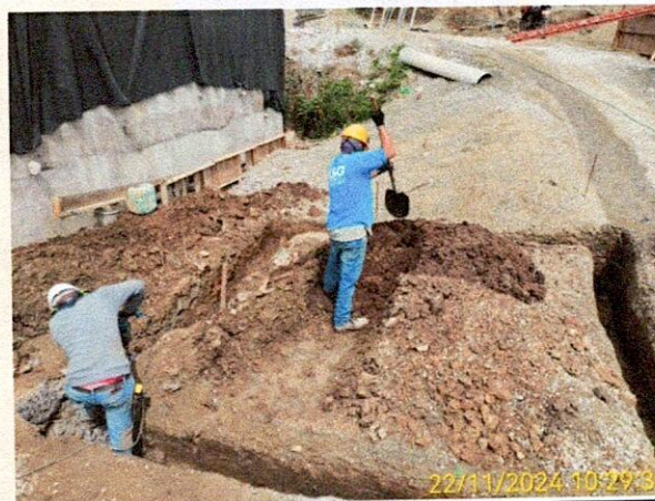
Fotografía: Se continua con la excavación manual para las zanjas de las vigas de cimentación de la caseta de operaciones.
