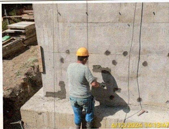
Fotografía: Marcación y escarificación mecánica para las zonas afectadas por el hormigueo en el concreto de la cara externa de los muros en los costados derecho e izquierdo del tanque de almacenamiento.
