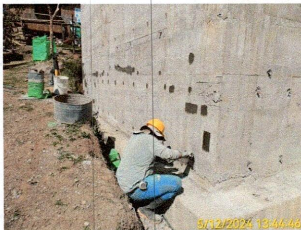
Fotografía: Aplicación del mortero de alta resistencia a las zonas afectadas por el hormigueo en el concreto en la cara externa de los muros de los costados del tanque de almacenamiento.
