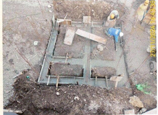
Fotografía: Vigas de cimentación de la caseta de operaciones.
