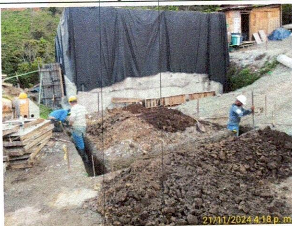
Fotografía: Se continua con la excavación manual para las zanjas de las vigas de cimentación de la caseta de operaciones.
